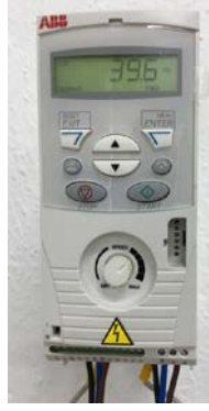
Görsel 4.3. Radyal Fan Kontrol Sürücüsü
