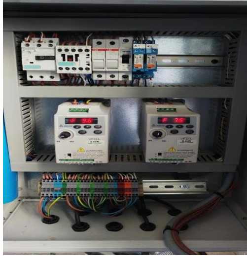
Şekil 3.31. Jet-grout deney setinin kontrol paneli ünitesi
