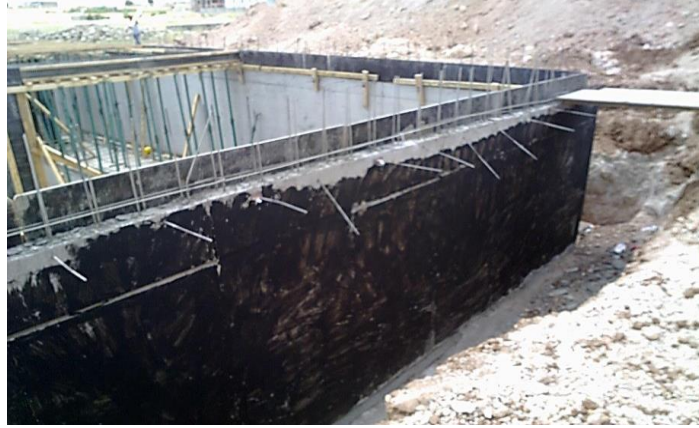
Şekil 3.25. Yüzeyi özel bitümlü sıvı ile boyanmış beton
