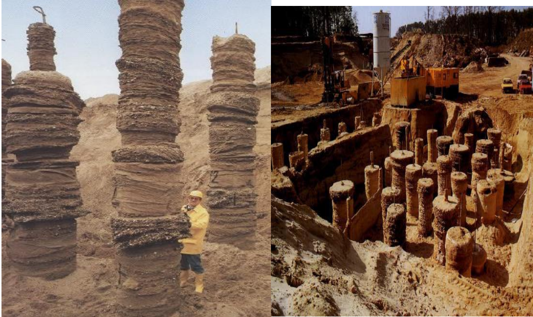
Şekil 3.17. Deneme kazısı ile çap ve süreklilik kontrolü (Keller-Ground-Engineering)
