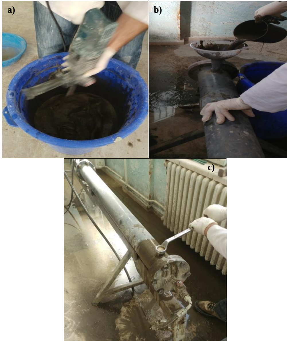
Şekil 3.34 a), b), c). Enjeksiyon malzemesinin hazırlanması ve hazneye doldurulması
