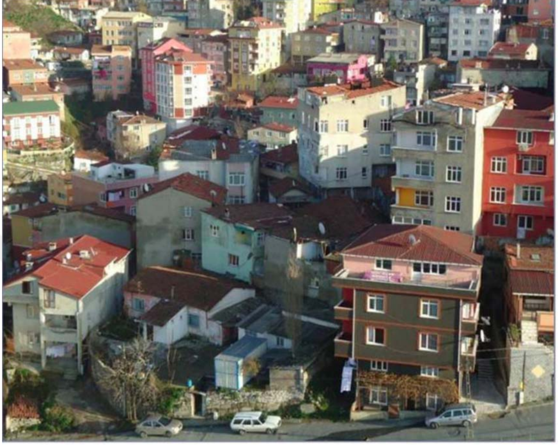
Fotoğraf 12: Dönüşüm Alanının Yıkımdan Önceki Hali
