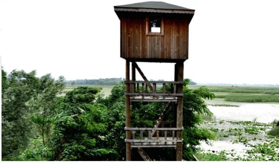
Şekil 1.7. Düzce'de Kuş Gözlemciliği Kulesi
