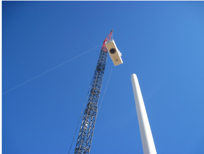
Şekil 2.11. Nasel Montajı
