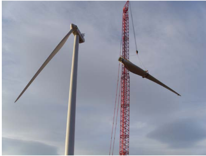
Şekil 2.9. Rüzgar Türbini Kanadının Montajı
