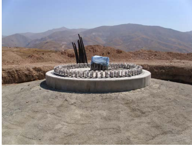
Şekil 2.6. Beton Dökümü Yapılmış ve Rüzgar Türbini Dikilmeye Hazır Temel
