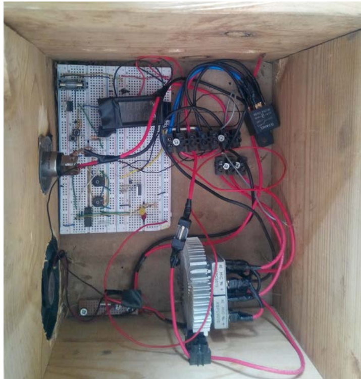
Şekil 3.44 Uygulama Amaçlı Yapılan Akü Şarj Kontrol Devresi
