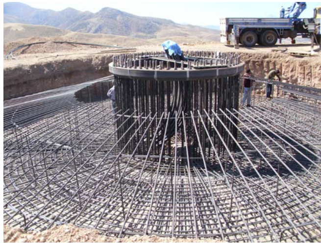
Şekil 2.5. Temelin Kafes Şeklinde Örülmesi
