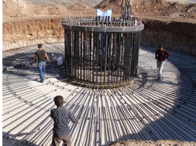
Şekil 2.4. Türbinin Üzerine Oturacağı Ankraj ve Temel
