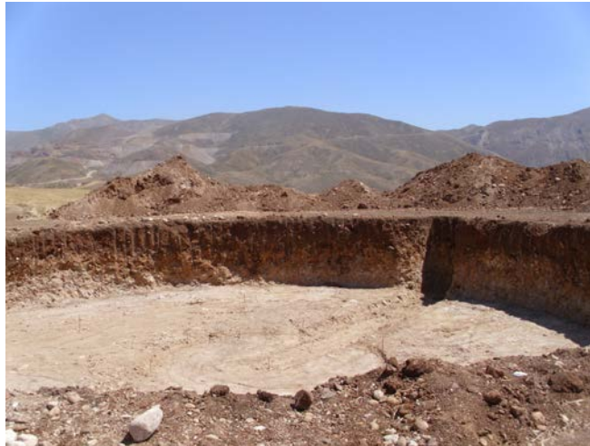
Şekil 2.2. Türbin Temeli İçin Açılan Çukur
