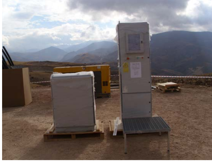
Şekil 2.13. Vestas V100 Modeline Ait Kontrol Sistemi
