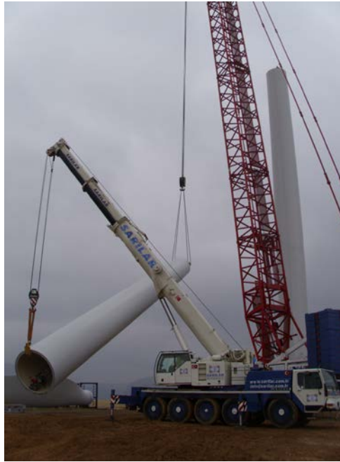
Şekil 2.8. Kulenin Montajı
