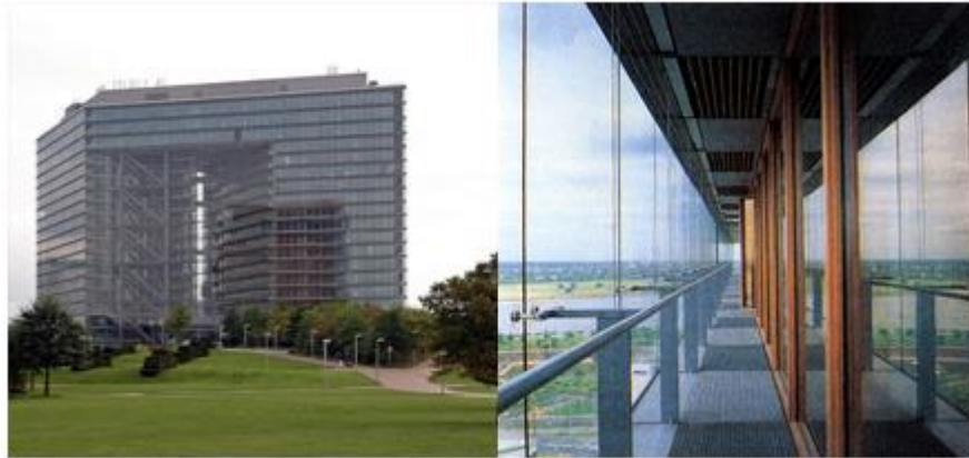
Şekil 3.12 : Dış görünüm ve cephe detayı Stadttor binası, (Almanya) [22].
