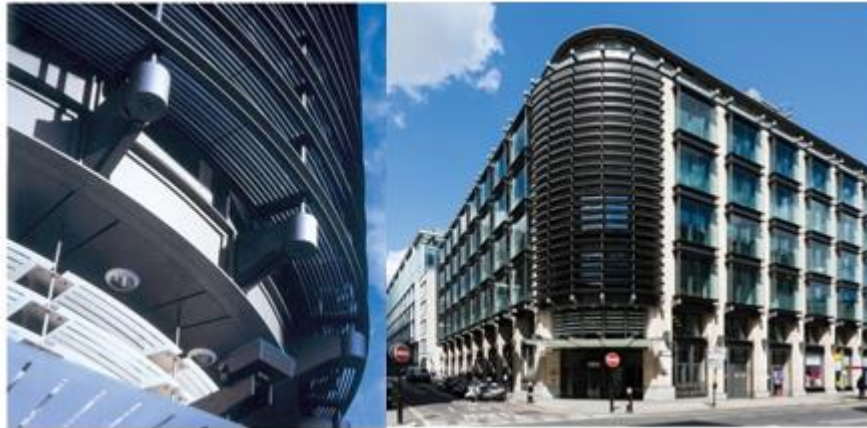
Şekil 3.7 : Dış görünüm ve cephe detayı Debis binası [22].
