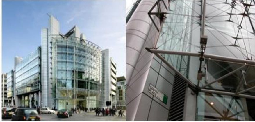
Şekil 3.9 : Dış görünüm ve cephe görünüm Helicon binası [23].
