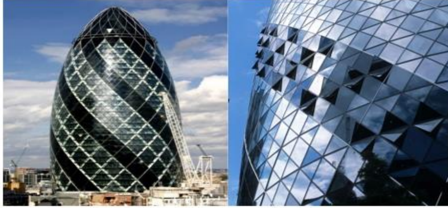
Şekil 3.13 : Dış görünüm ve cephe detayı Swiss Re kulesi, (İngiltere) [22].
