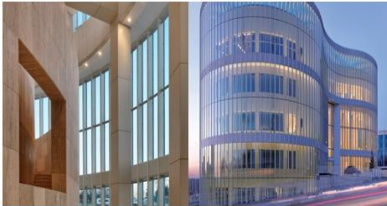
Şekil 3.17 : İç görünüm ve dış görünüm (Küçükçekmece belediye binası, İstanbul) [23].
