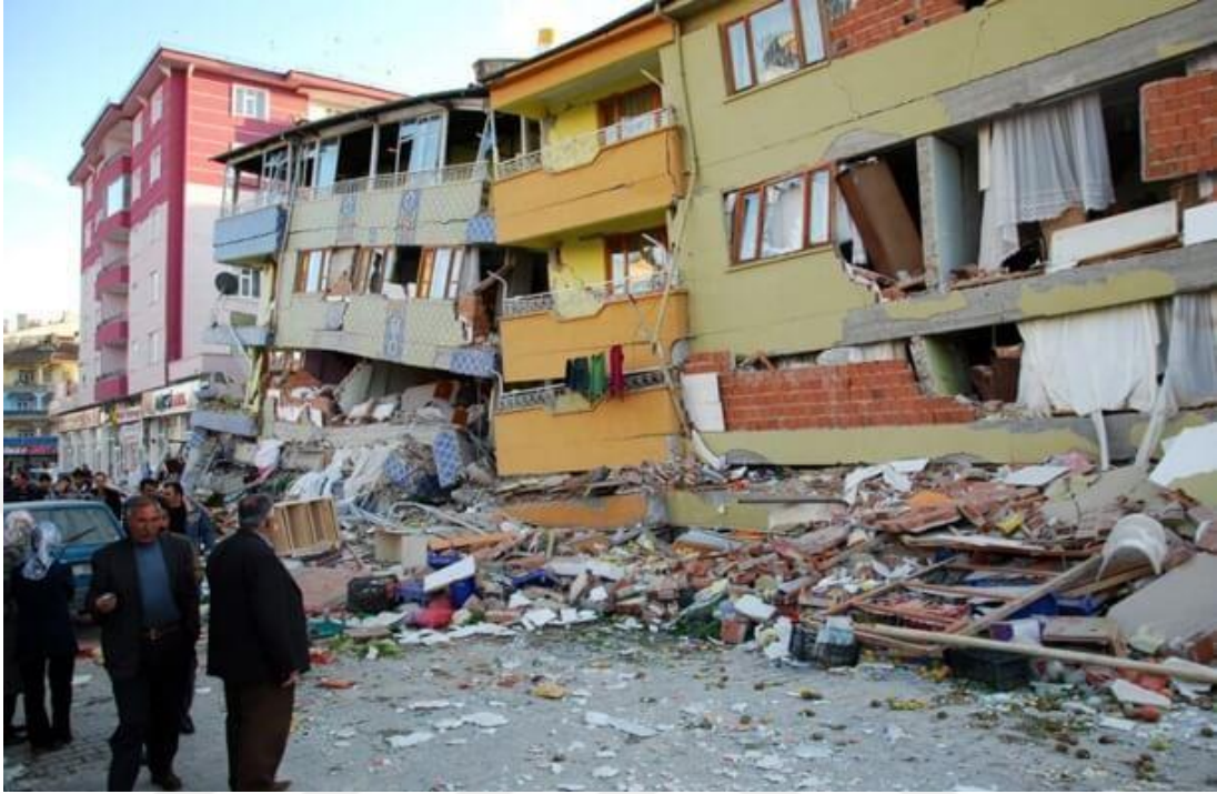
Fotoğraf 1. Depremde Yıkılan Binalar
