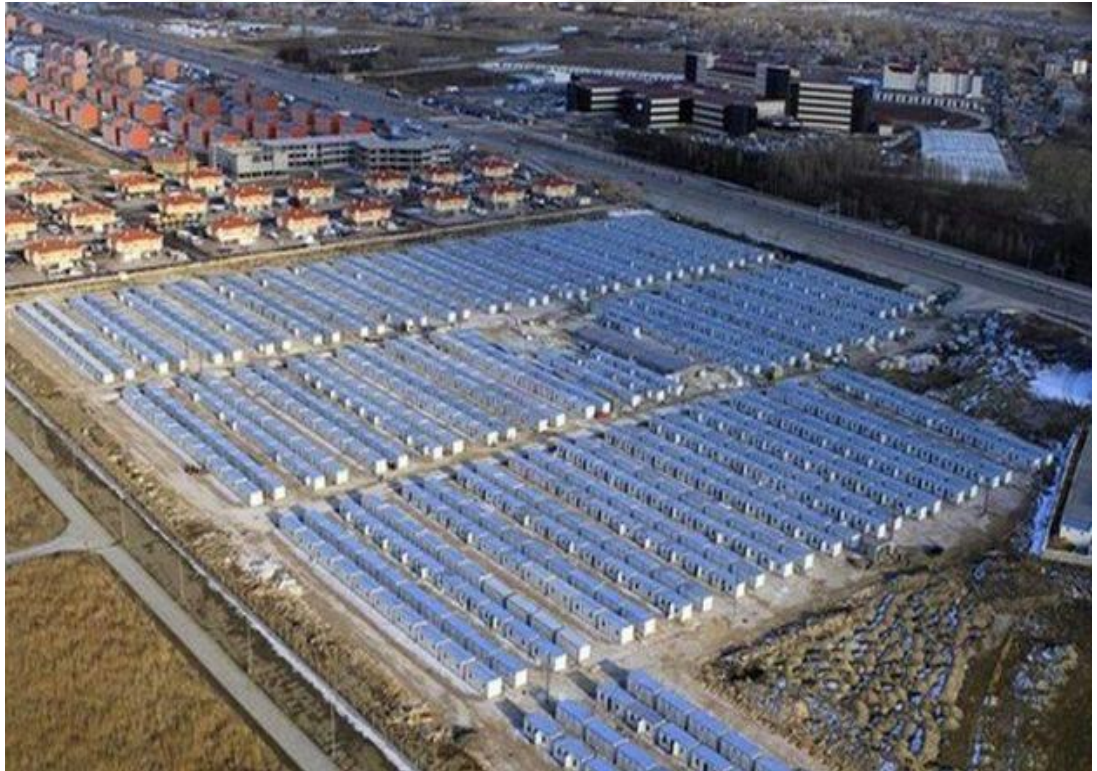
Foto 14: Van depremi Konteyner Kent
