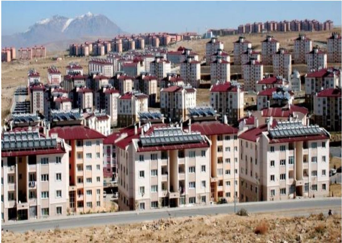
Foto 22: Van depremi TOKİ Afet Konutları
