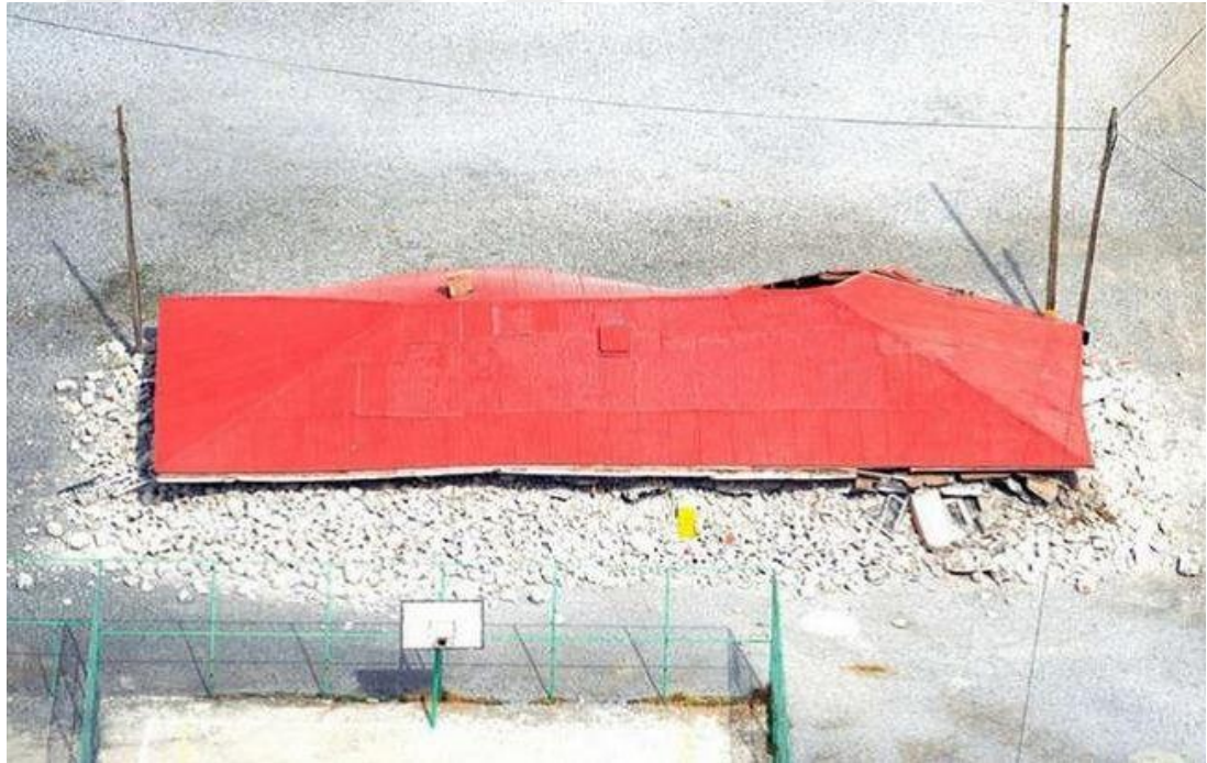
Foto 6: Yıkılan Okul Binası
