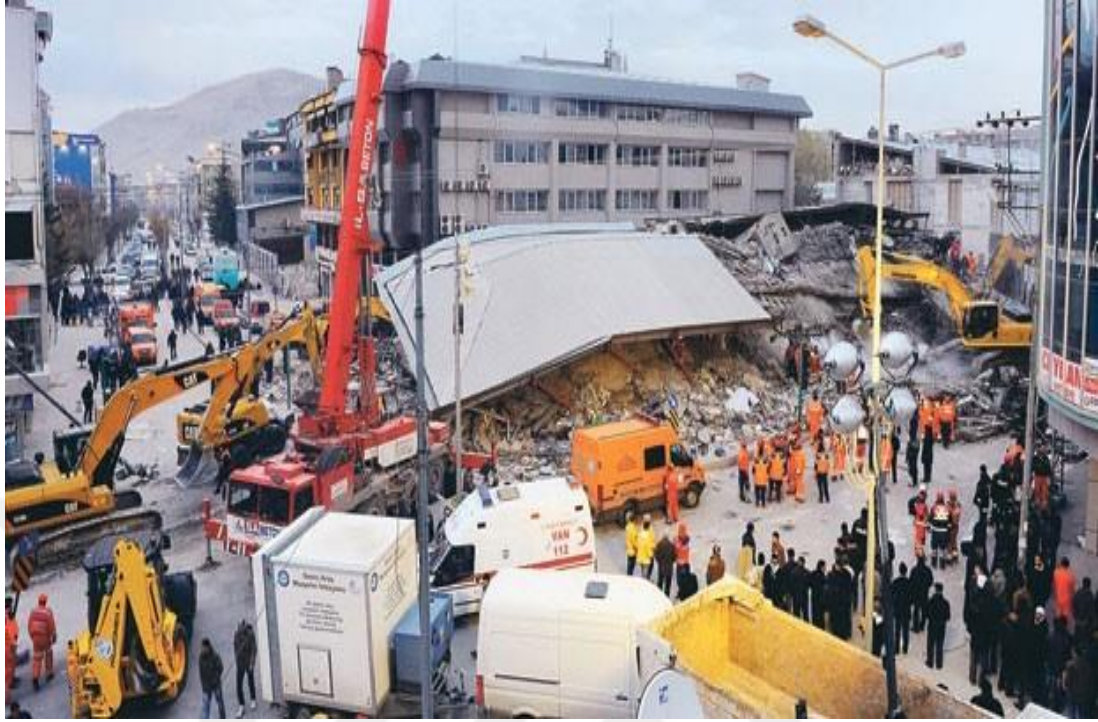
Foto 5: Depremde Yıkılan Bayram Otel
