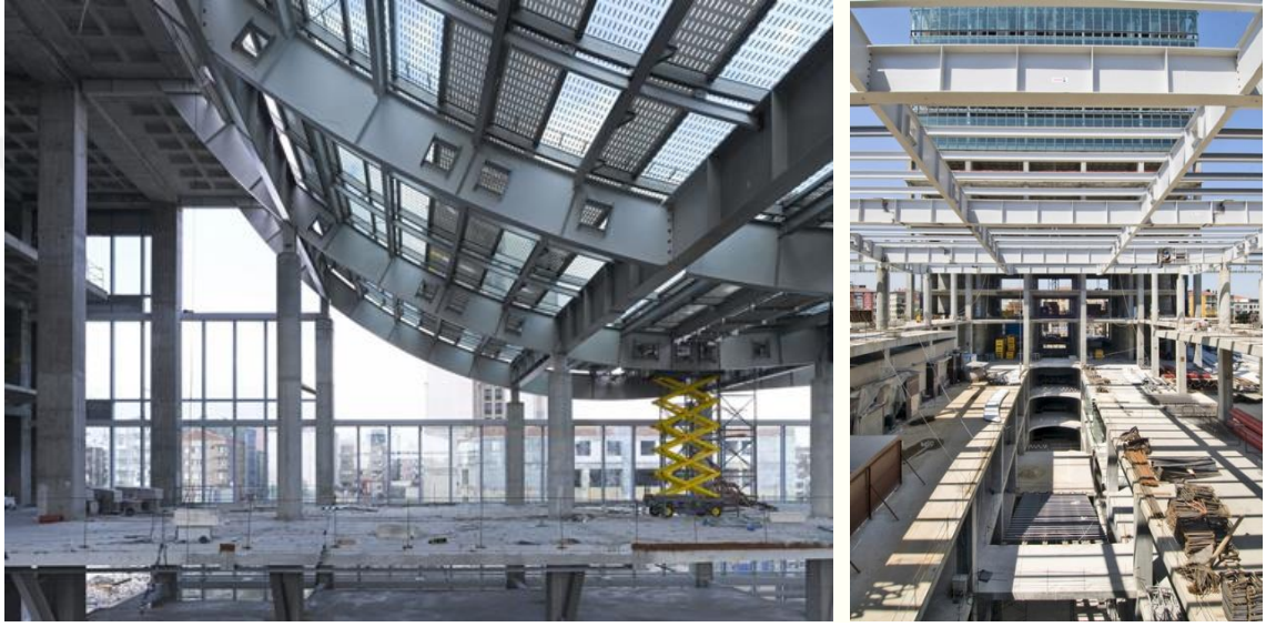
Şekil 4.13. Sapphire Residence Tower alışveriş merkezinde betonarme ve çelik strüktürün birlikte kullanımı [163]
