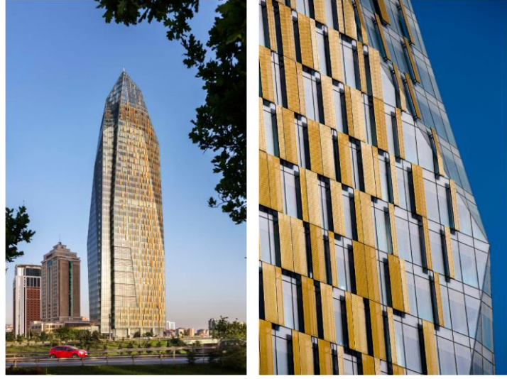
Şekil 3.6. Allianz Tower güneş kontrollü cam giydirme cephesi [110]
