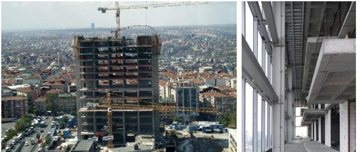
Şekil 4.14. Sapphire Residence Tower konut kulesi taşıyıcı sistemi [163]
