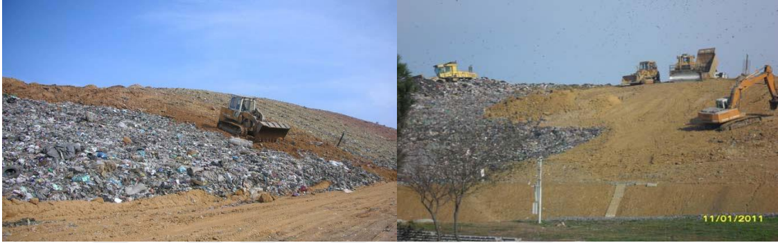
Şekil 2.4 Son örtü serilmesi [18]
