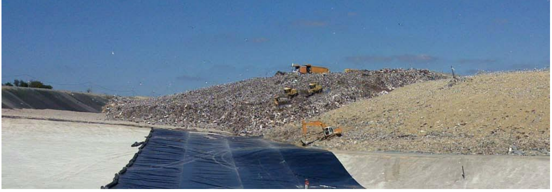
Şekil 2.5 Katı atıkların hücre metodu ile depolanması [18]
