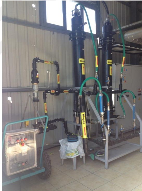
Şekil 4.11 Nemli gaz ve aktif karbon ile H 2 S giderim sistemi
