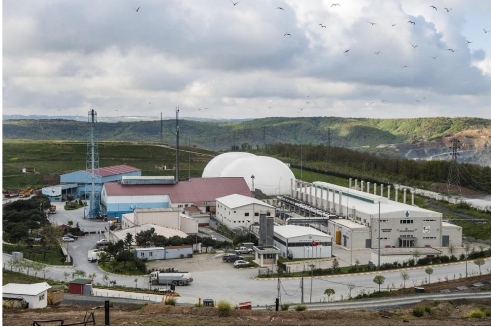
Şekil 4.2 Ortadoğu Enerji Odayeri Elektrik Üretim Santrali
