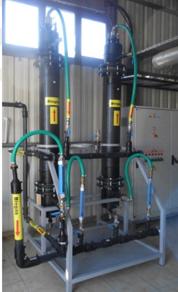
Şekil 4.8 Kuru gaz ve aktif karbon ile H 2 S giderim sistemi
