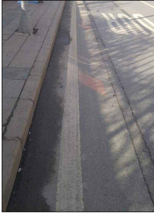
Şekil 4.13: Fiber hat çalışma örneği
