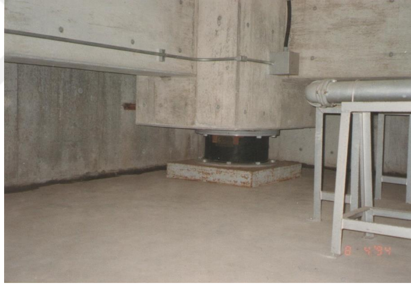
Şekil 1.3 : Kauçuk esaslı bir mesnet uygulaması.
