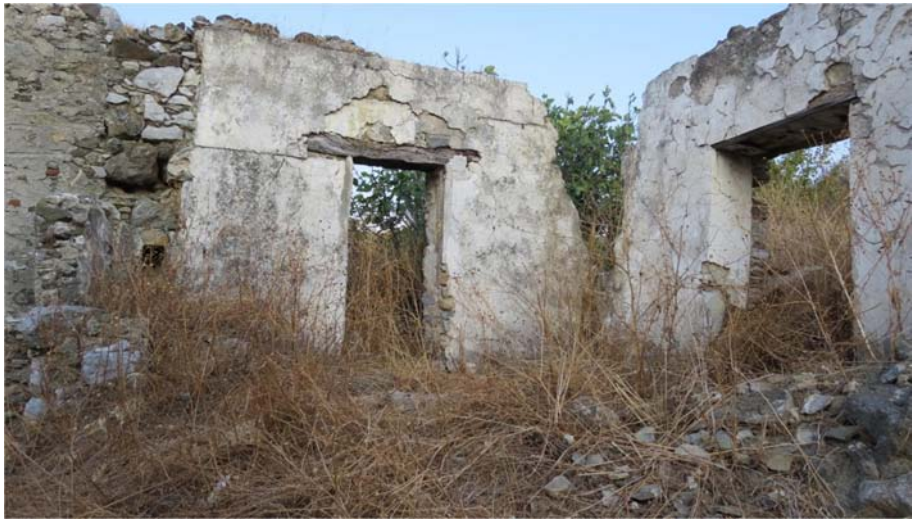
Şekil G.158 : Yıkılan duvarlar.
