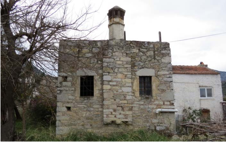
Şekil F.23 : Geleneksel tek katlı bir yapı, 36 Env. No'lu yapı.
