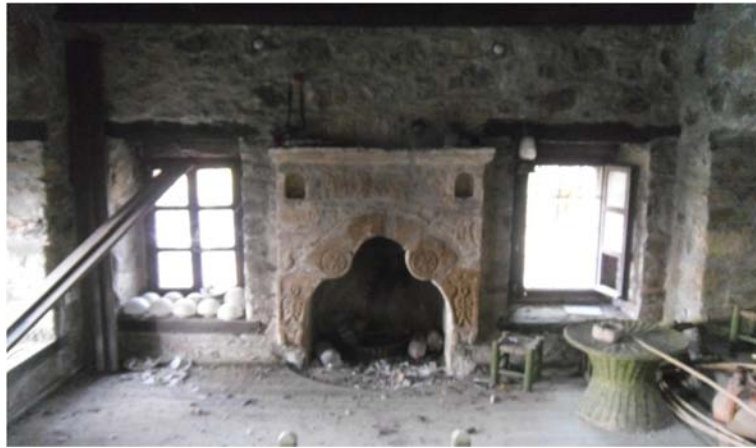
Şekil I.13 : İç mekanda sıvasız duvarlar.
