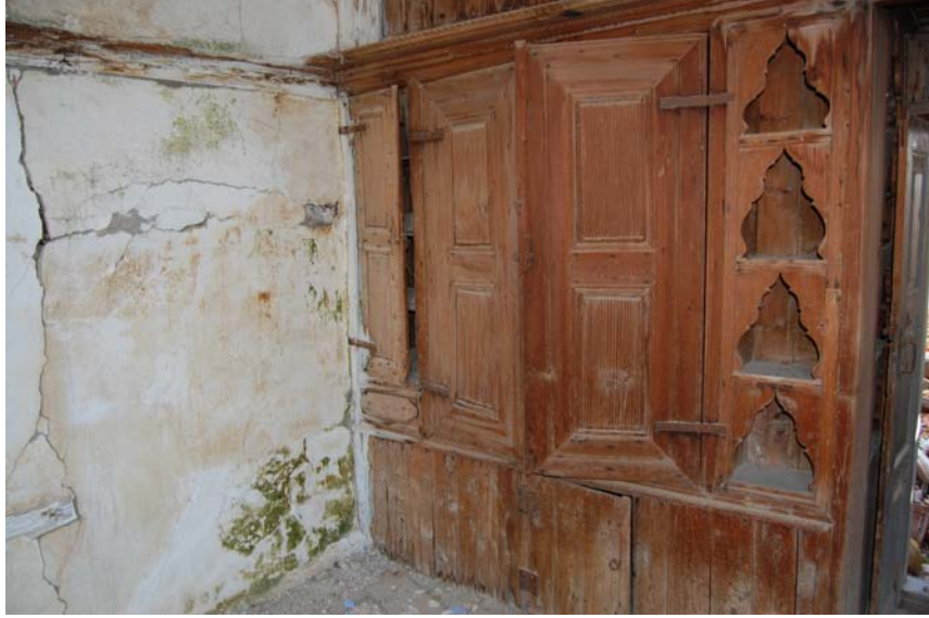
Şekil A.29 : Reşadiye Mahallesi’ndeki bir konutun yüküğü ve ahşap işçiliği.
