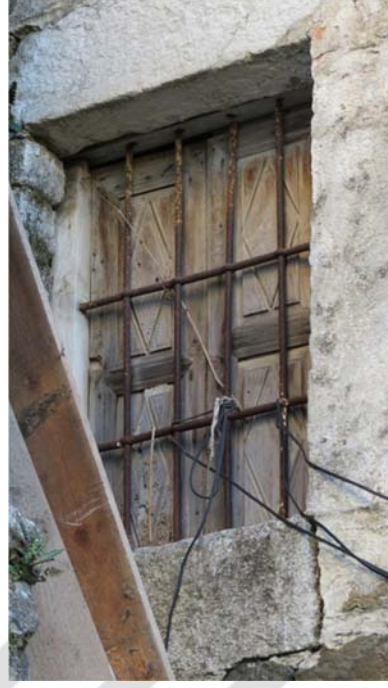
Şekil I.8 : Demir parmaklıklı ahşap pencere örnekleri.
