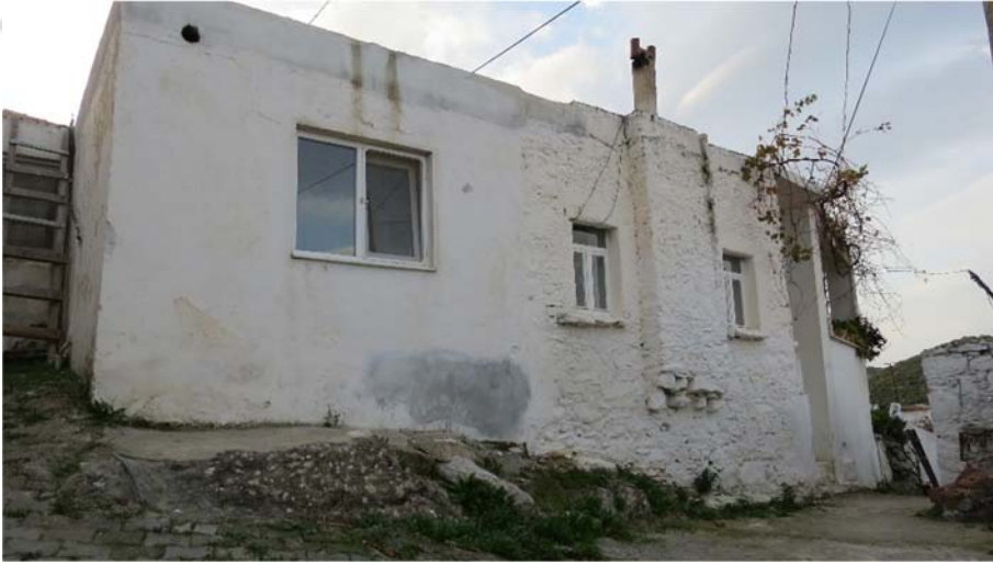
Şekil K.5 : 17 Env. No'lu yapı ve niteliksiz ekleri.
