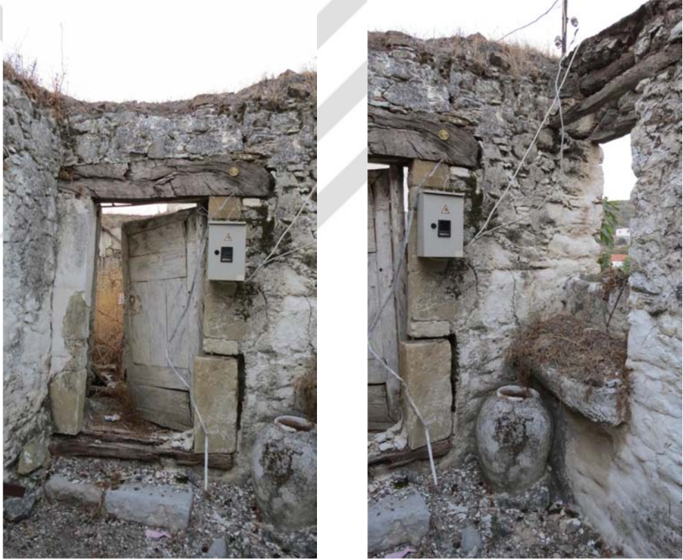
Şekil G.82 : A odasının söveli giriş kapısı.
