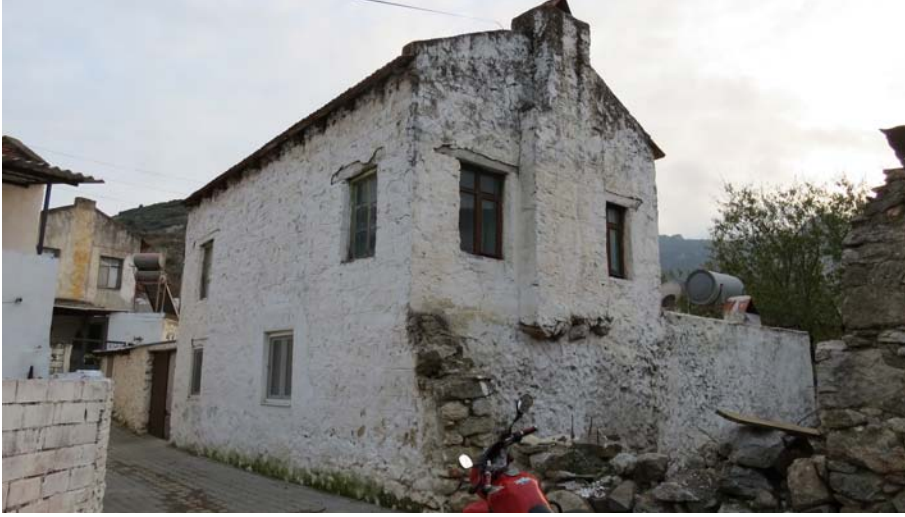
Şekil F.16 : 213 Env. No'lu yapı.
