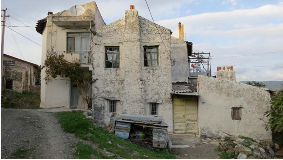
Şekil K.4 : 20, 21 Env. No'lu yapı ve niteliksiz ekleri.
