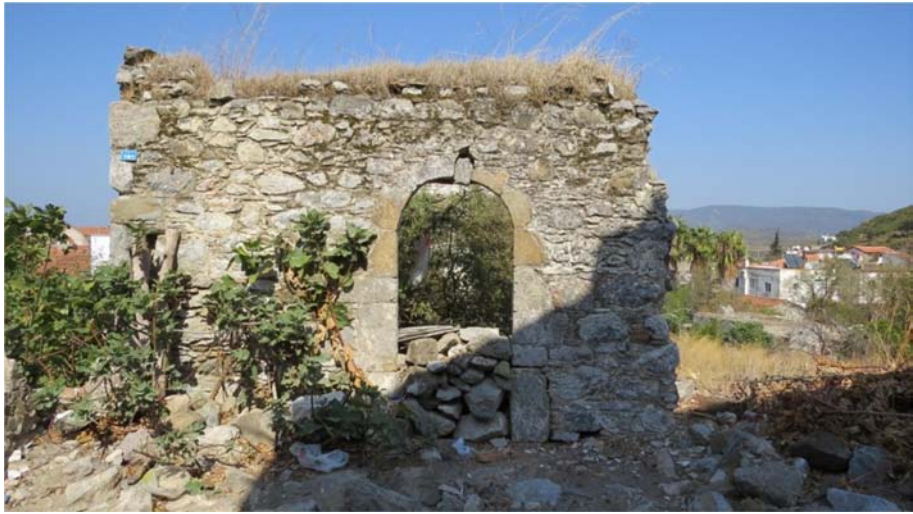
Şekil G.135 : Yapının zemin kat girişi.
