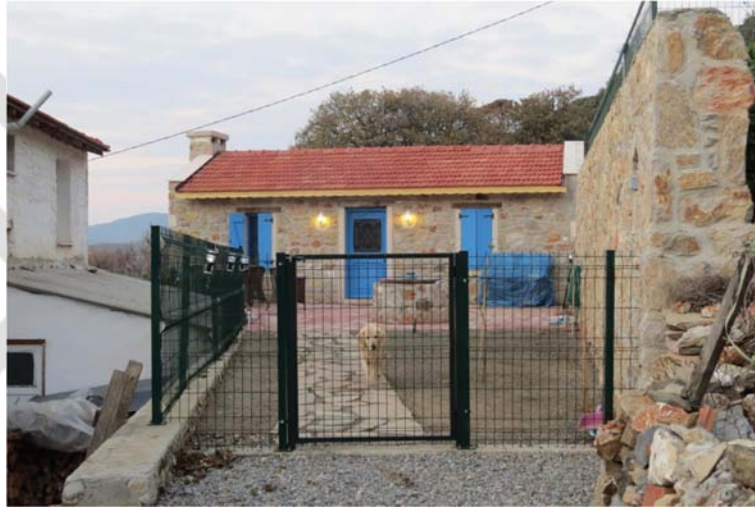
Şekil K.23 : 274 Env.no'lu yapının onarım sonrası durumu (2016).
