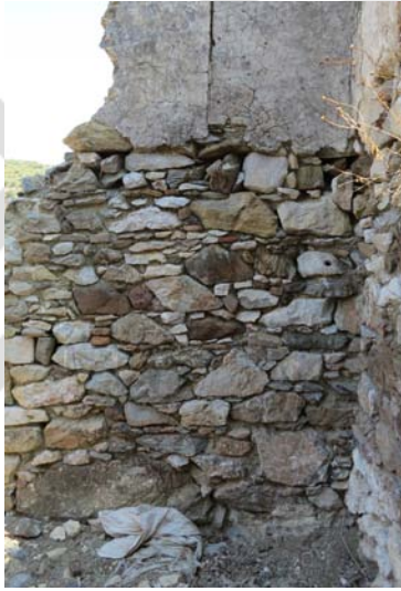
Şekil G.166 : Taş duvar örgüsü.
