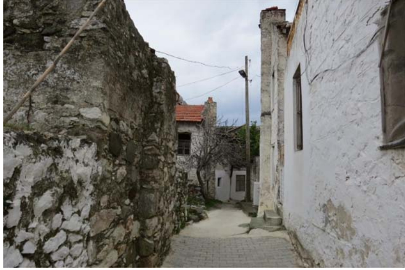
Şekil G.110 : 114 ve 115 Env. No'lu yapıların sokağı.
