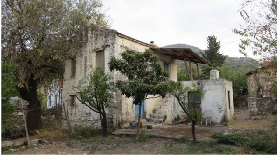
Şekil G.170 : 24 Env. No'lu yapının Kuzeydoğu cephesi.
