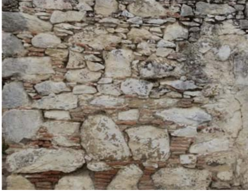
Şekil I.49 : Tuğla Kırıklı Duvar Örgü Örneği.
