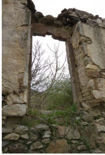
Şekil G.165 : Taş söveli oda giriş kapısı.
