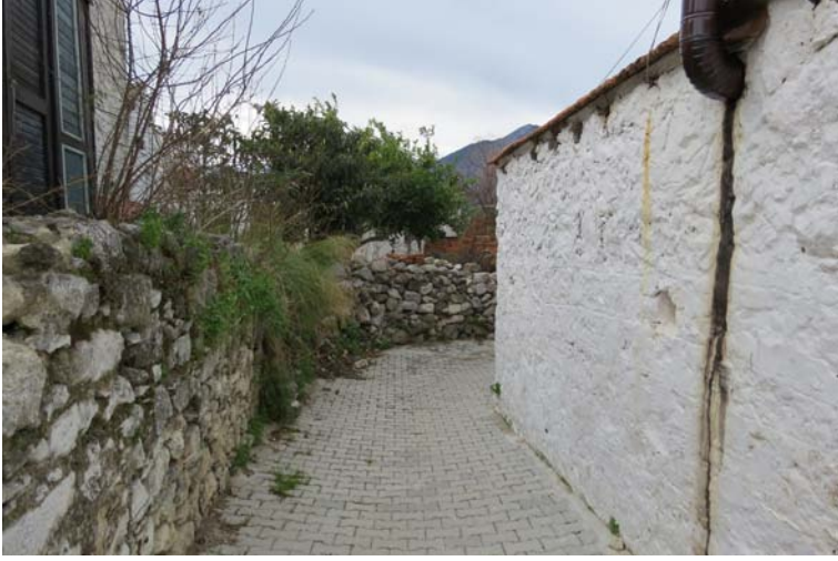
Şekil D.63 : 83 Env. No'lu yapının taş duvarlarla sınırlanan sokağı.
