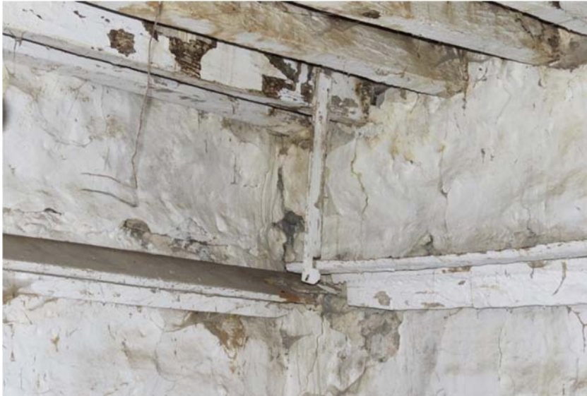
Şekil G.34 : Odayı çevreleyen ahşap raf detayı.
