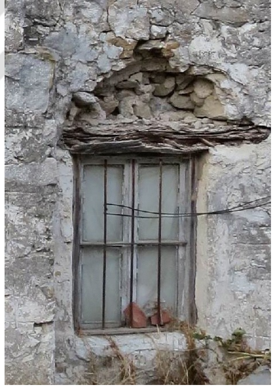
Şekil G.183 : 1.kat ve Zemin kat pencere doğrama detayları.
