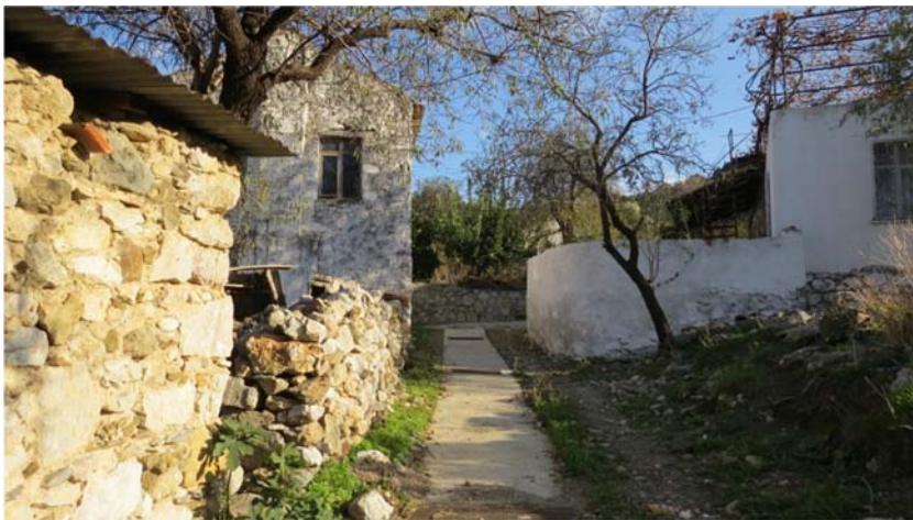
Şekil D.11 : Doğu Dere yolu.
