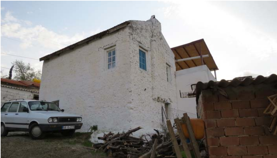
Şekil F.12 : 189 Env. No'lu yapı.
