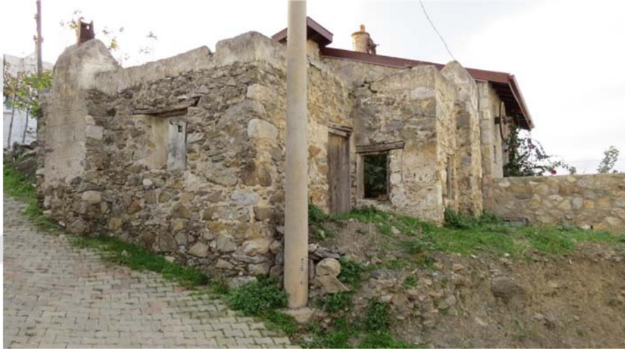
Şekil G.53 : Eğimli araziye oturan yapının güneydoğu cephesi.
