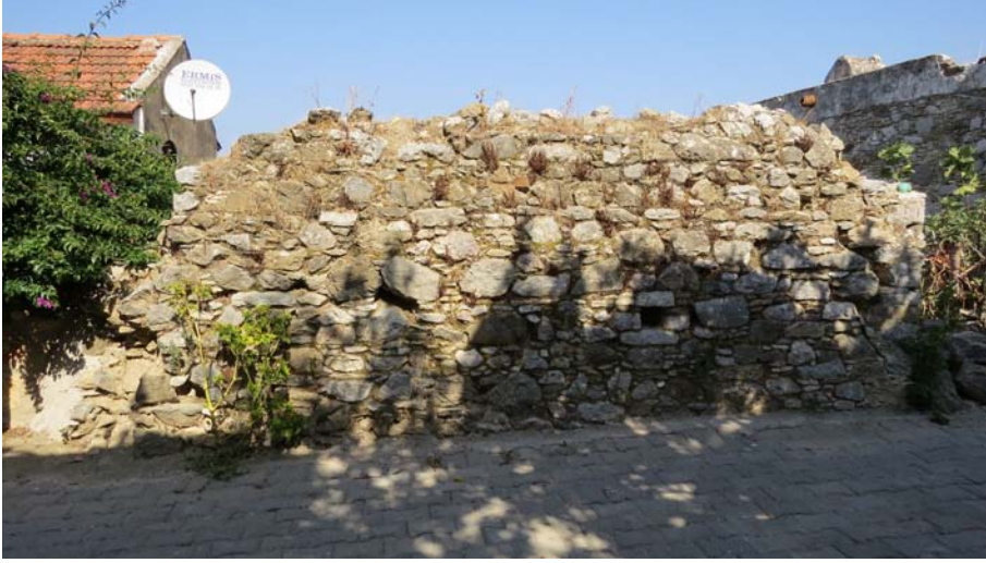
Şekil G.20 : Yol cephesi.
