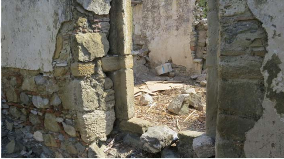
Şekil G.100 : Odanın giriş kapısının söve detayı.
