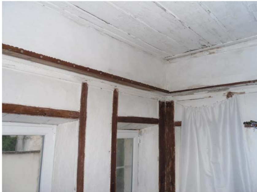
Şekil I.29 : Ahşap rafın pencere ve tavanla ilişkisi.
