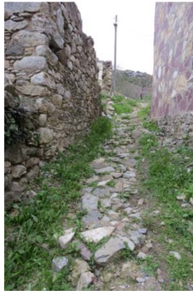
Şekil G.152 : Yapının güney avlu duvarları.
