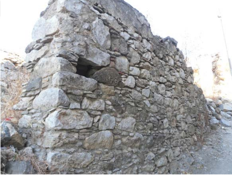
Şekil G.160 : Güney avlu duvaları.
