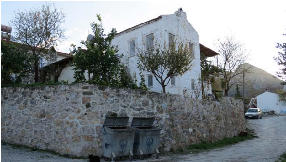
Şekil F.9 : 179 Env. No'lu yapı.
