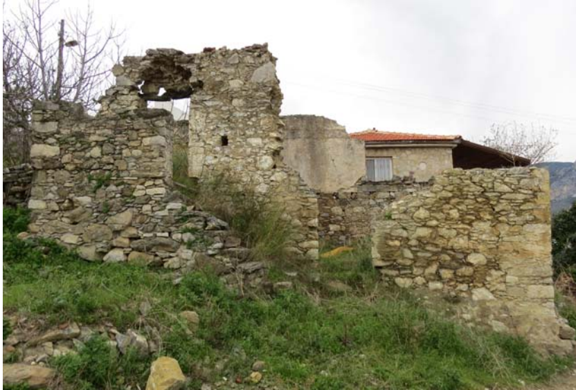
Şekil G.154 : Kuzeydoğu cephesi.
