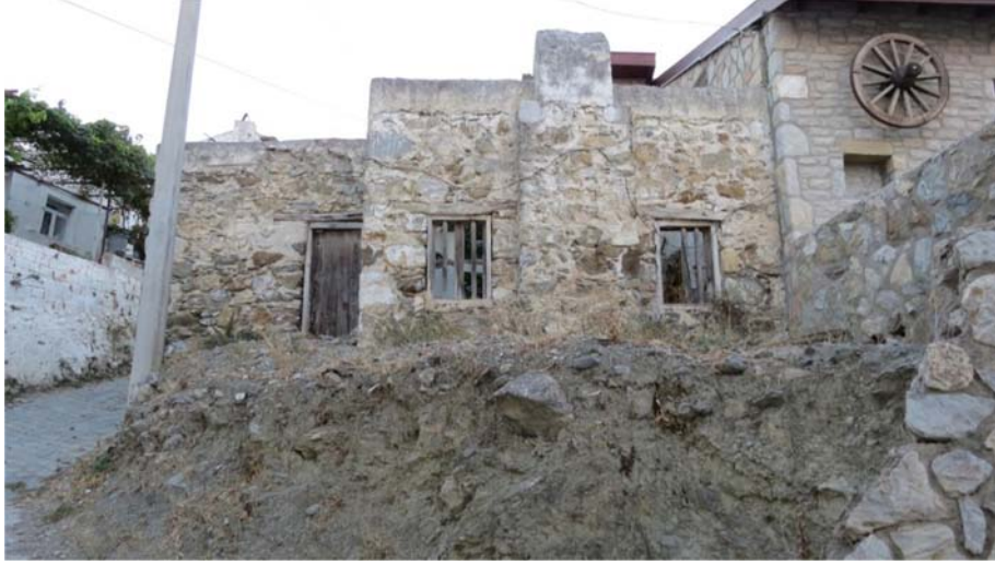
Şekil G.52 : 16 Env.No'lu yapının Kuzeydoğu cephesi.
