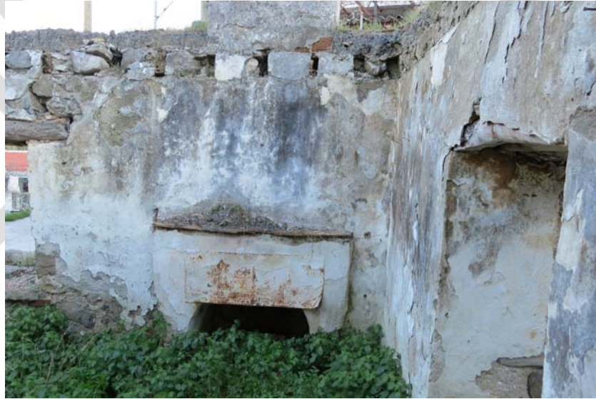
Şekil G.59 : Kiriş saplama boşlukları ve ocak (B odası).
