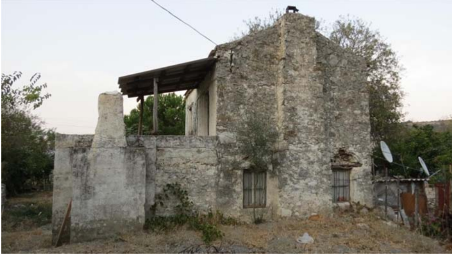
Şekil G.173 : Güneybatı cephesi.
