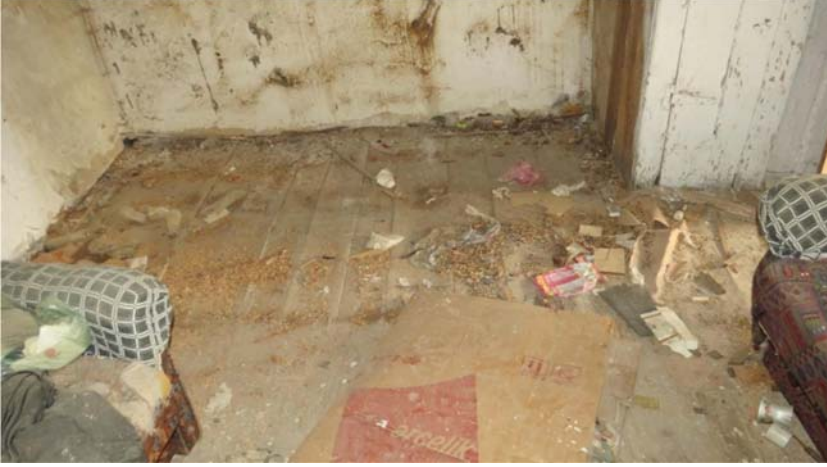
Şekil G.48 : Zemin ahşap kaplaması.
