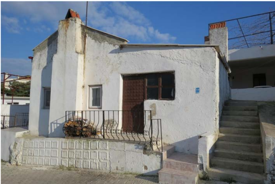
Şekil K.9 : 60 Env. No'lu yapıya eklenen niteliksiz ekler.
