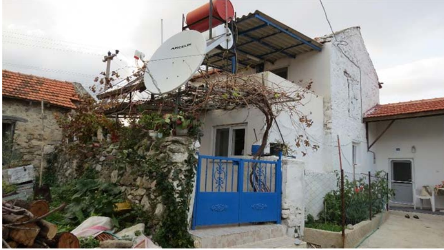
Şekil K.7 : 106 Env. No'lu yapı ve niteliksiz ekleri.
