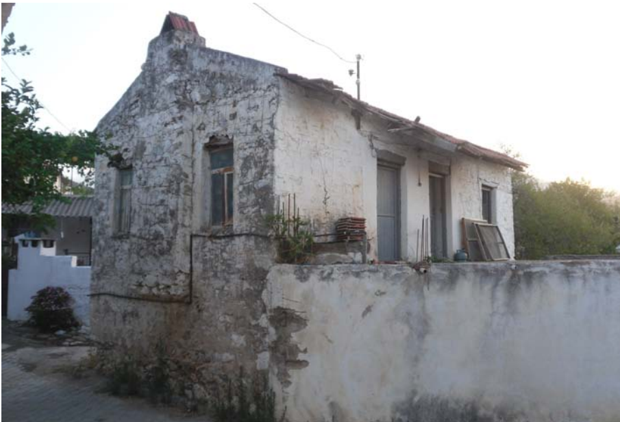
Şekil F.18 : 211 Env. No'lu yapı.
