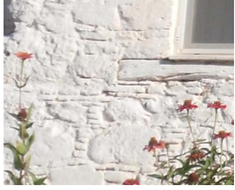
Şekil I.49 : Tuğla Kırıklı Duvar Örgü Örneği.
