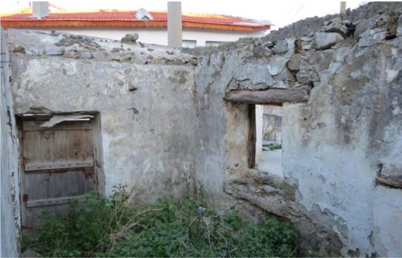
Şekil G.57 : Sıvalı duvarlar.
