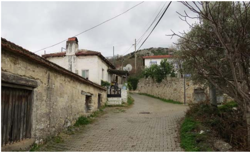
Şekil D.44 : 151 Env. No'lu yapı.
