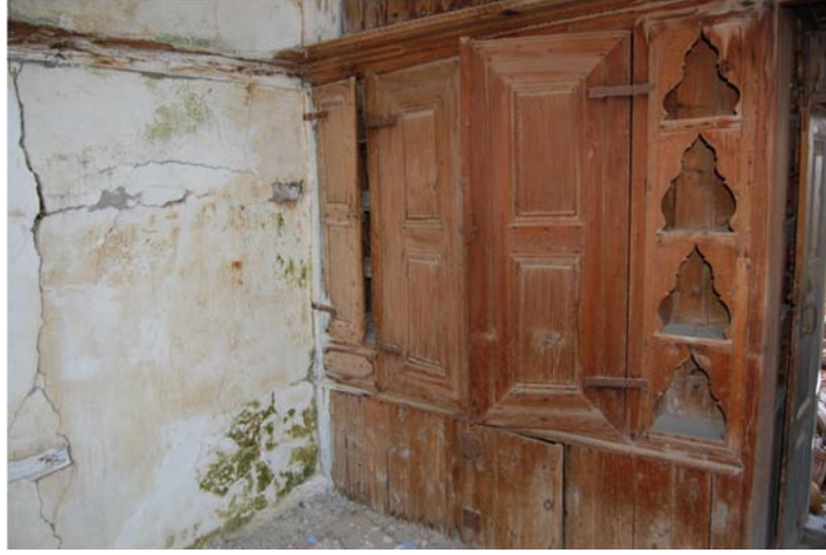
Şekil I.43 : Reşadiye Mahallesi'nde kapı kanadının yanında yüklük örneği.
