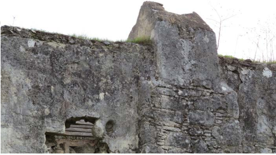
Şekil G.13 : Baca-dam birleşimi.
