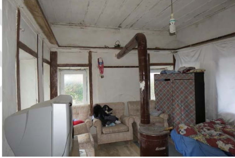
Şekil I.18 : Kapatılan ocağın ateş bacasının kullanılması, Env. No.161.
