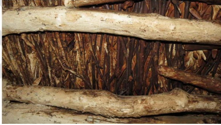
Şekil I.33 : Düz dam detayının iç mekandan görünüşü.
