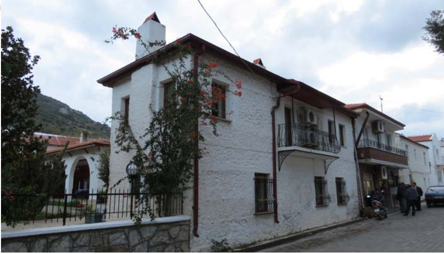
Şekil F.17 : 159 Env. No'lu yapı.
