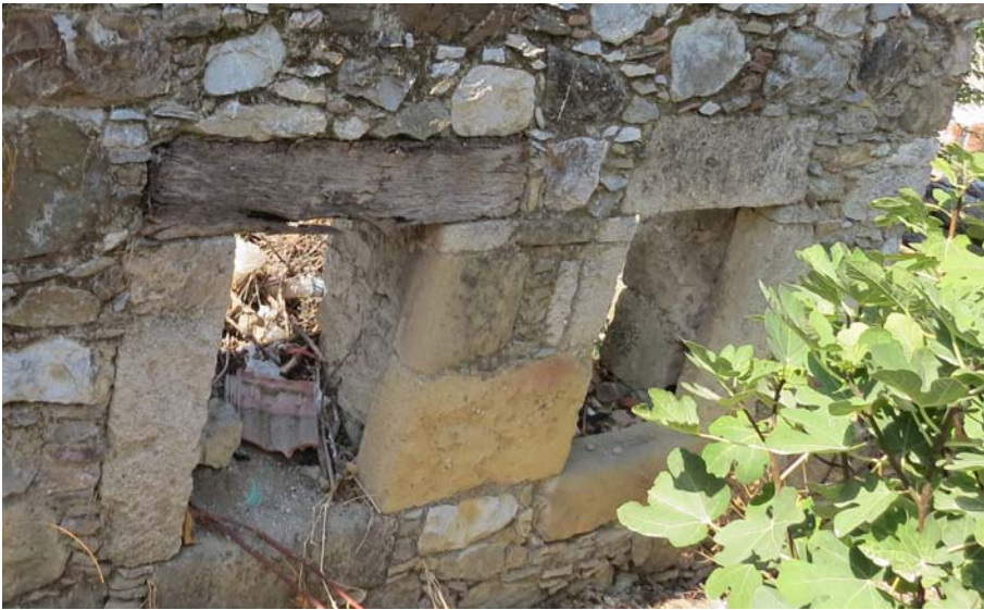
Şekil G.22 : Taş söveli ve ahşap lentolu pencereler.
