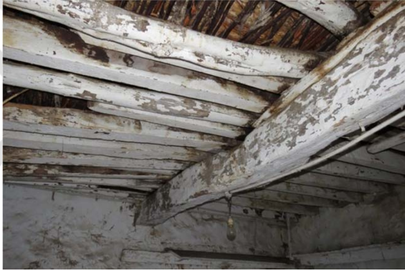
Şekil G.36 : Özgün toprak dam katmanları.
