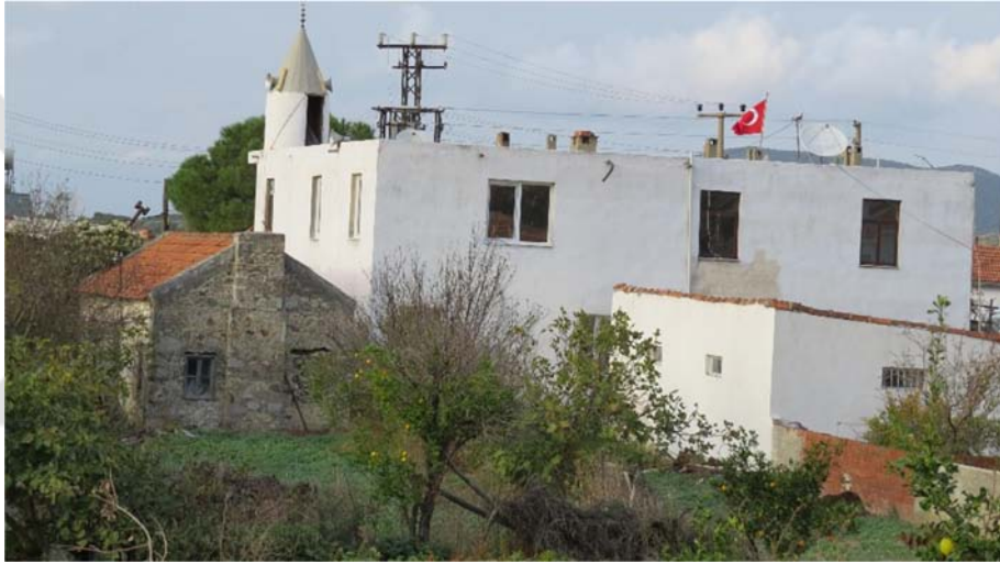
Şekil K.14 : 92 Env. No'lu yapının yanına eklenen 91 Env. No'lu yapı.
