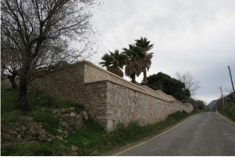
Şekil B.31 : Doğu Hızırşah bağlantı yolundan Hızırşah Cami'nin avlu duvarları.
