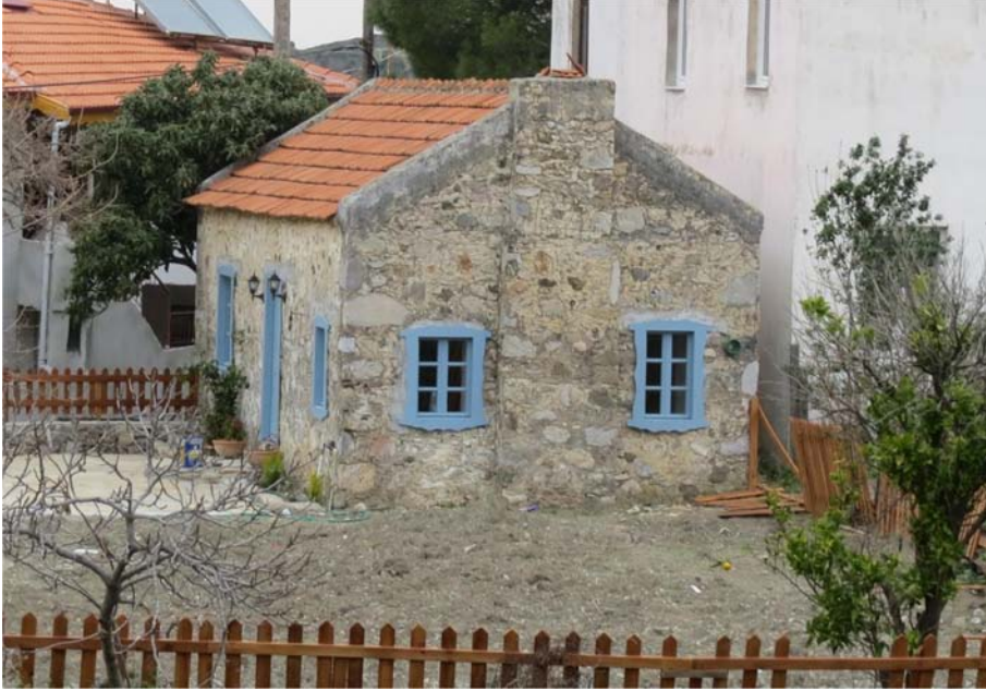
Şekil K.17 : 92 Env.no'lu yapının onarım sonrası durumu (2016).
