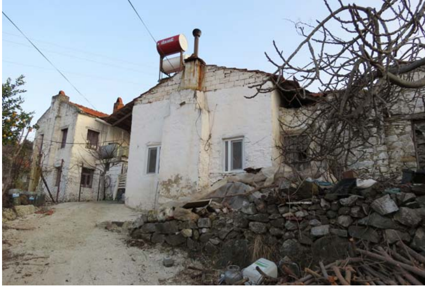
Şekil D.51 : 195 Env. No'lu yapıya eklenen beşik çatı.
