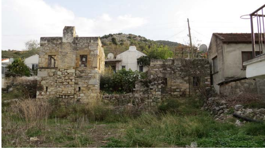
Şekil G.130 : 164 Env. No'lu yapı ve batıda ortak kullanılan avlu.
