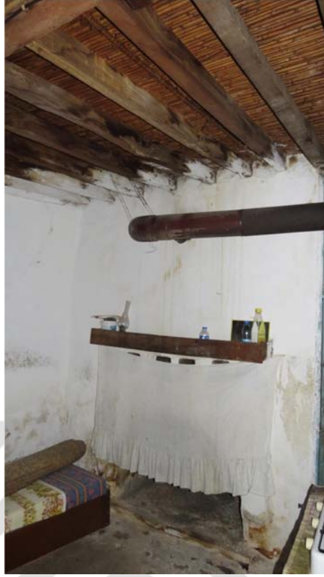
Şekil I.35 : Üst kat döşemesi ve ocağın ilişkisi.
