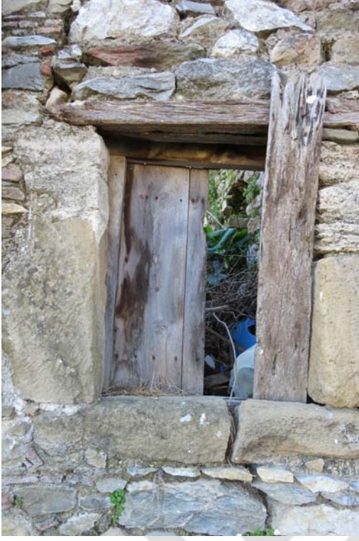
Şekil G.26 : Taş sövenin iç ve dış görünüşü.
