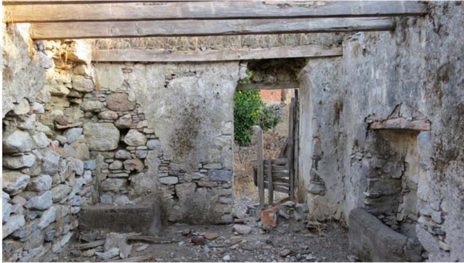
Şekil G.10 : Girişin bulunduğu kısa cephe.
