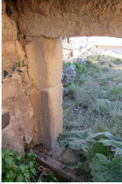
Şekil G.26 : Taş sövenin iç ve dış görünüşü.
