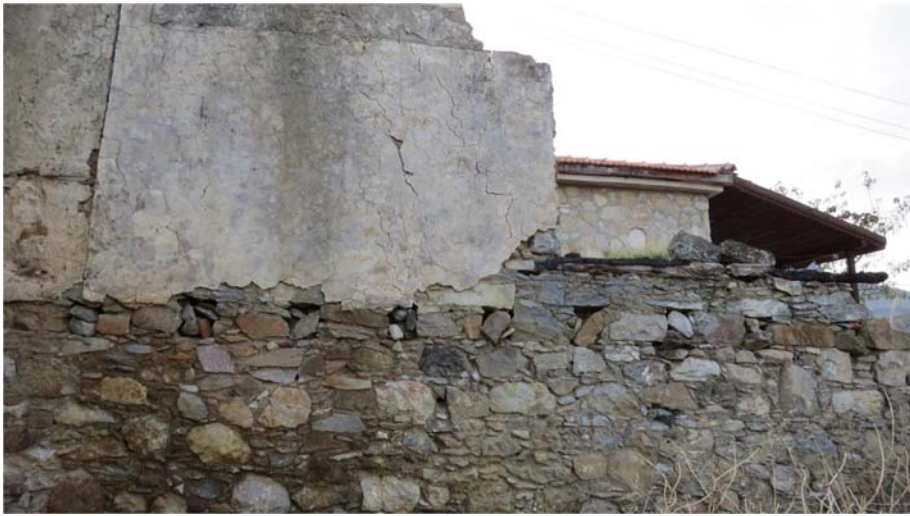
Şekil G.164 : Nişlerin bulunduğu duvar.
