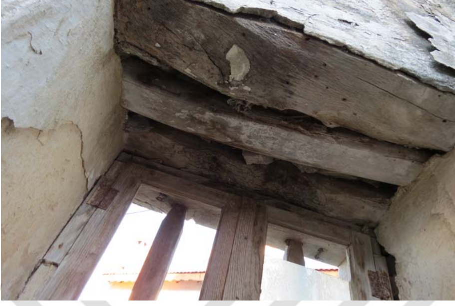
Şekil G.66 : Pencere ahşap lentosu.
