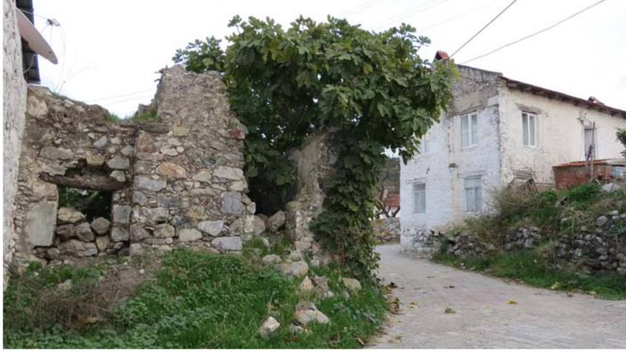
Şekil K.1 : İçinde incir ağacı çıkan ve yıkılan 138 Env. No'lu yapı.
