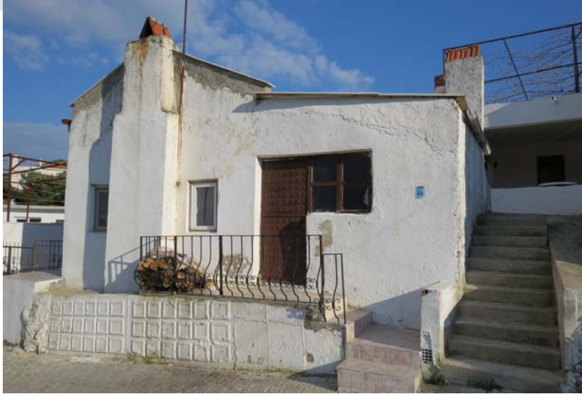
Şekil F.29 : 60 Env. No'lu yapı.
