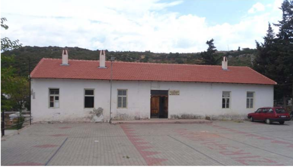
Şekil D.2 : Köyün eski İlköğretim okulu, günümüzdeki İpek Dokuma Atölyesi.
