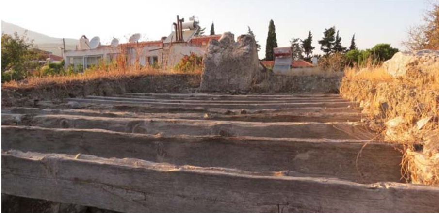
Şekil G.12 : Düz damı taşıyan ahşap kirişler.
