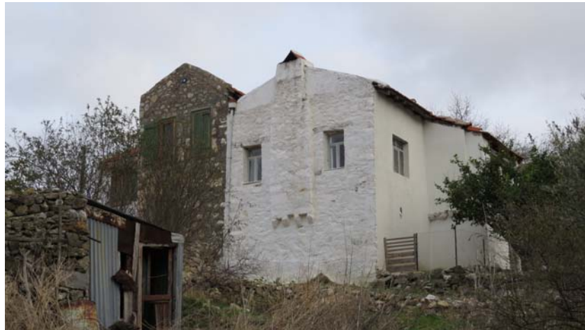
Şekil F.27 : Eğime oturan bodrum katlı yapı örneği, 178 ve 178a Env. No'lu yapılar.
