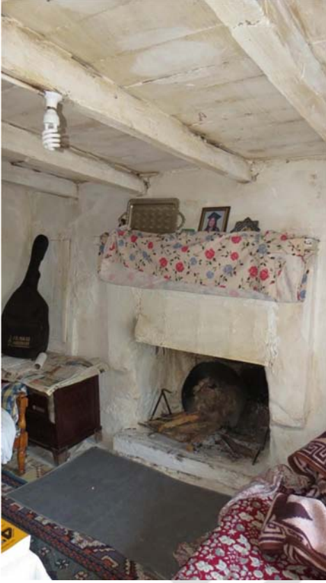
Şekil I.35 : Üst kat döşemesi ve ocağın ilişkisi.
