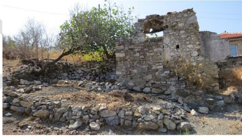
Şekil G.151 : Yapının doğu avlusu ve bahçesi.
