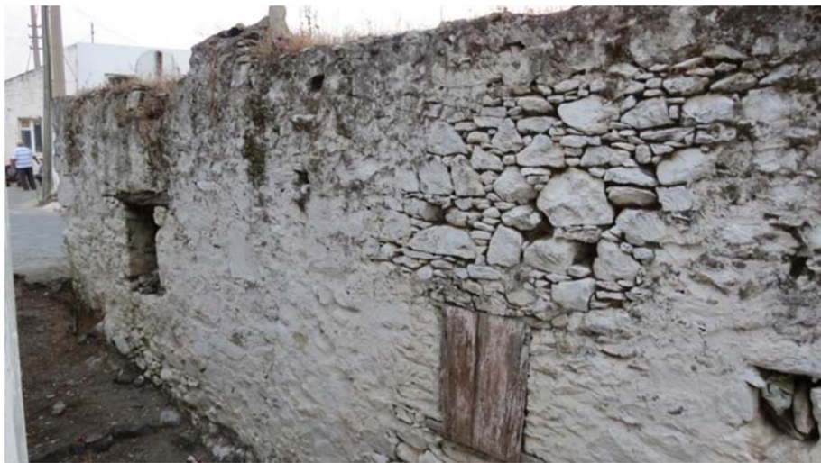
Şekil G.77 : Güneybatı cephesi.
