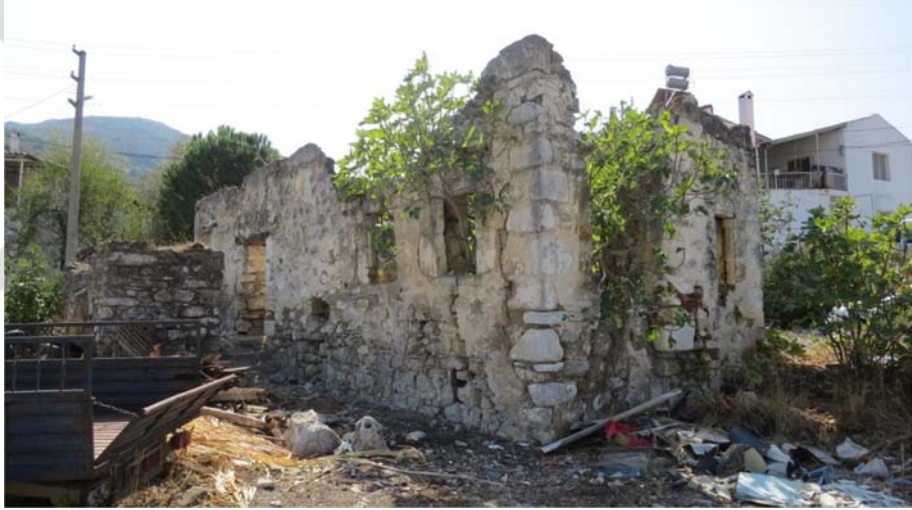
Şekil G.88 : Kuzeydoğu cephesi.
