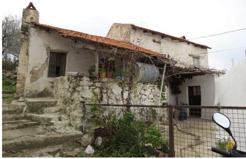
Şekil G.40 : 19 Env. No'lu yapının Kuzeydoğu cephesi.
