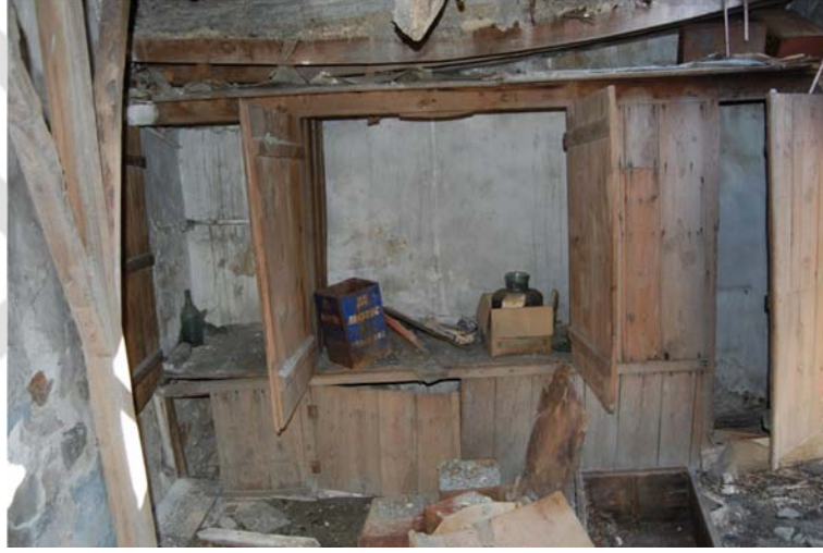
Şekil I.44 : Reşadiye Mahallesi'nde kapı kanadının arkasında yüklük örneği.
