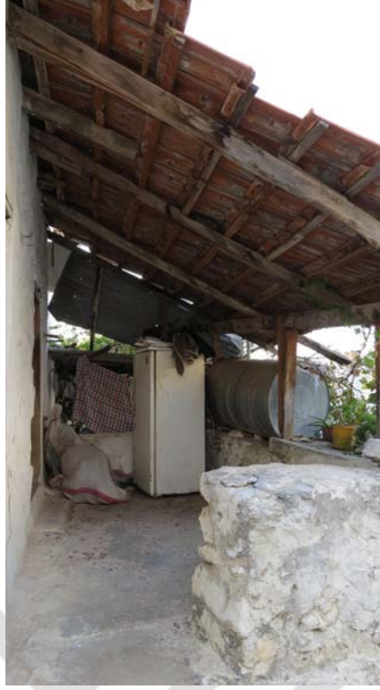
Şekil G.43 : Dış avluyu örten sundurma çatı.
