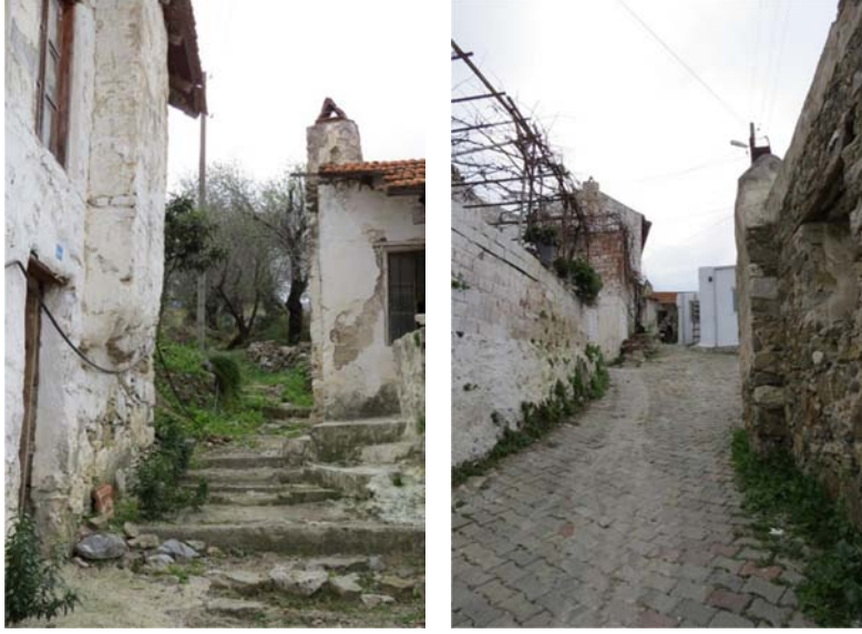
Şekil D.33 : 006 Env. No'lu yapının parke kaplı ve merdivenli sokağı.
