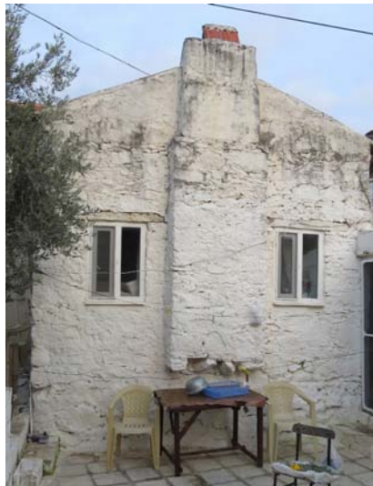
Şekil K.12 : 217 Env. No'lu yapıya beşik çatı eklenmesi.
