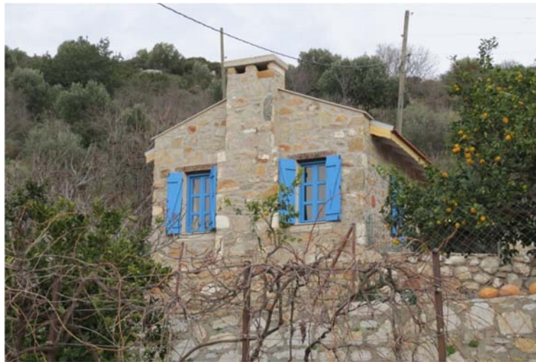
Şekil K.24 : 274 Env.no'lu yapının onarım sonrası ocaklı cephe (2016).
