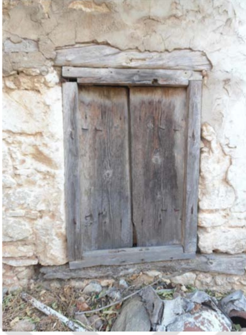
Şekil I.6 : Kapaklı ve ahşap parmaklıklı pencere örnekleri.
