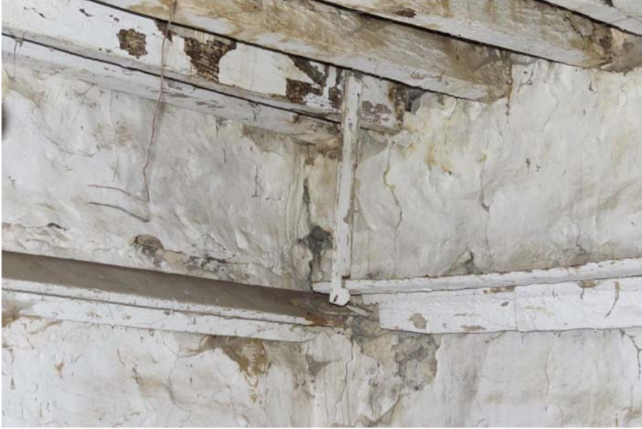
Şekil I.31 : Ahşap raf-düver bağlantısı.
