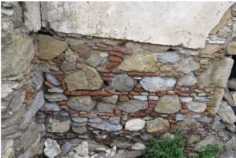
Şekil G.101 : Yatay tuğla istifli taş örgü.
