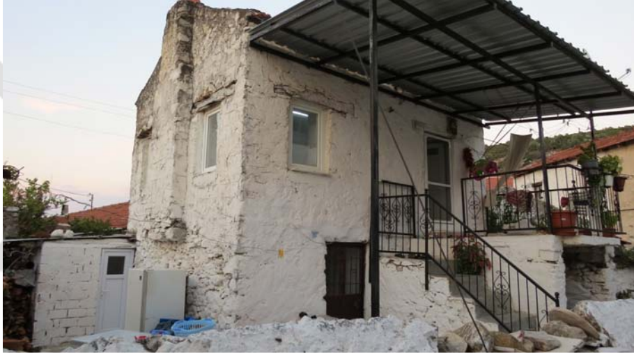
Şekil F.2 : Dış merdivenli geleneksel konut, 226 Env. No'lu yapı.
