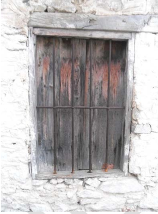
Şekil I.8 : Demir parmaklıklı ahşap pencere örnekleri.
