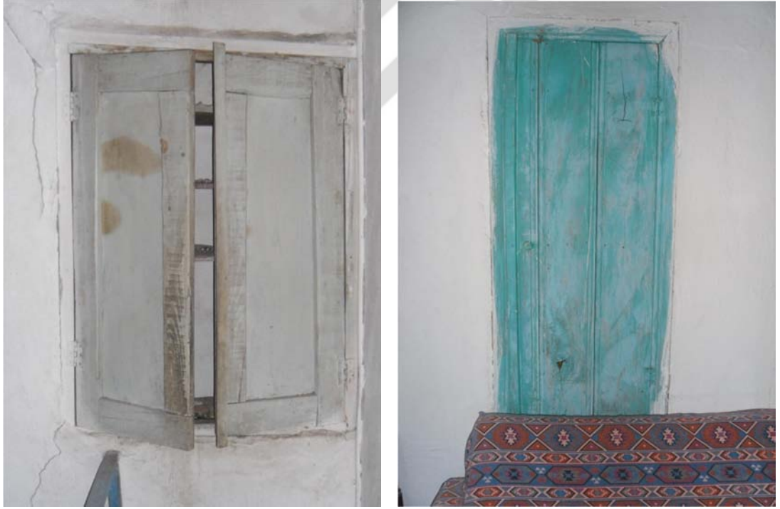
Şekil I.39 : Çift ve tek kapaklı ahşap dolap örnekleri.
