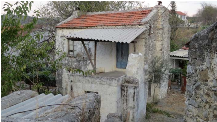
Şekil G.172 : Kuzeydoğu cephesi.
