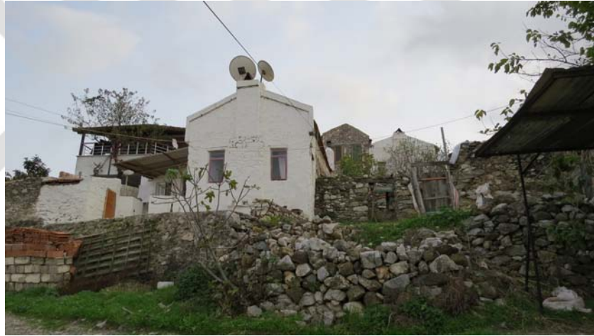
Şekil F.26 : 173 Env. No'lu yapı.
