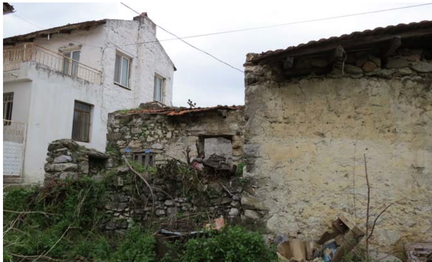
Şekil G.112 : Kuzeydoğu cephesi.
