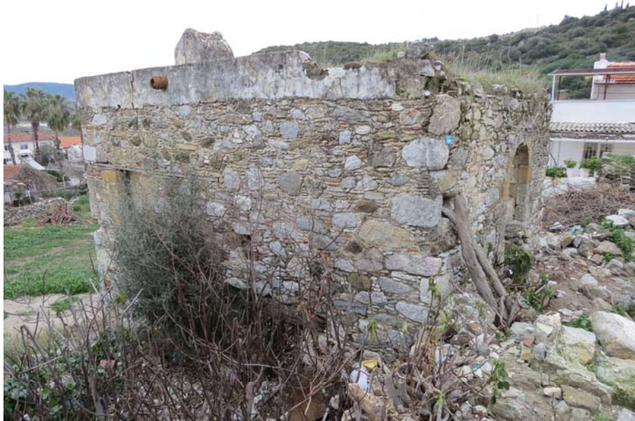
Şekil G.132 : Özgün toprak dam parapet duvarları.
