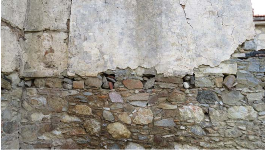
Şekil G.163 : Yok olan döşeme kirişlerinin yuvası.
