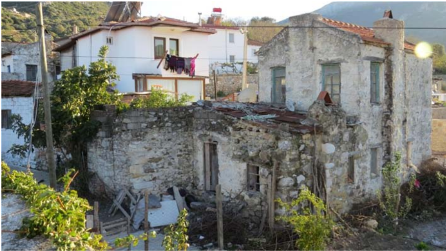
Şekil K.15 : 33 ve 34 Env. No'lu yapıların arkasına eklenen yeni yapı.
