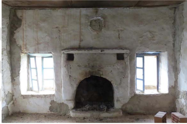
Şekil I.12 : Ocağın simetrik düzende yerleştirilmesi.
