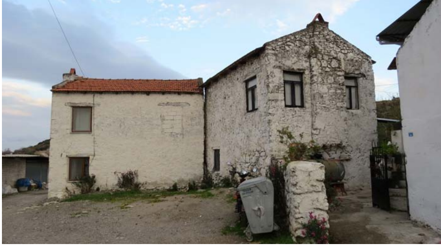
Şekil F.1 : İki katlı geleneksel konut örneği, 140 ve 141 Env. No'lu yapılar.
