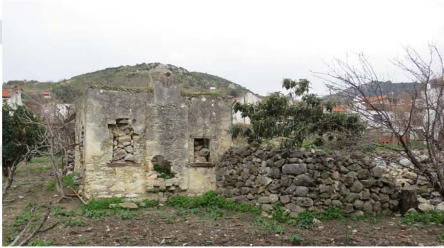
Şekil G.4 : Kuzeybatı cephesi.
