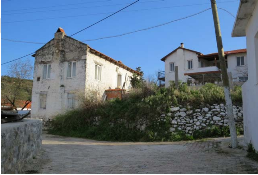
Şekil D.58 : 112 Env. No'lu yapının çevresindeki sokaklar.
