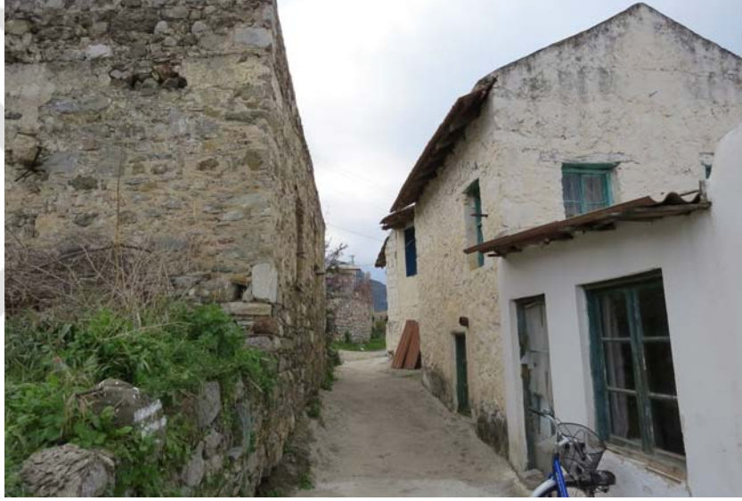
Şekil D.31 : 28 Env. No'lu yapı ve çevresi.
