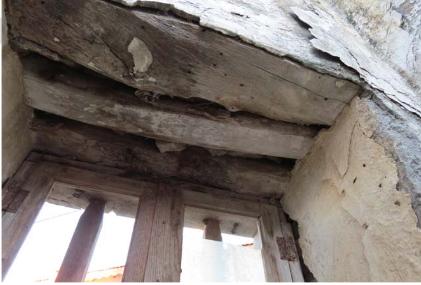
Şekil G.62 : Pencere ahşap lentoları.
