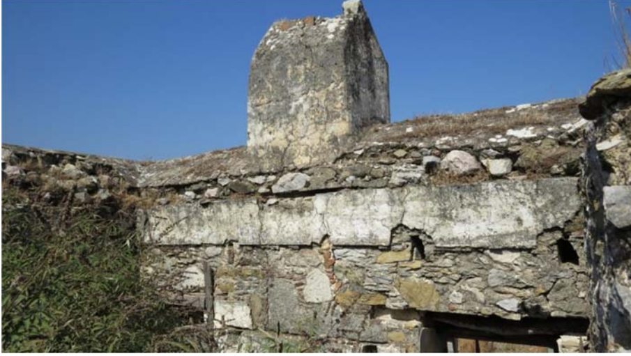
Şekil G.139 : Özgün baca ve toprak dam hizası.
