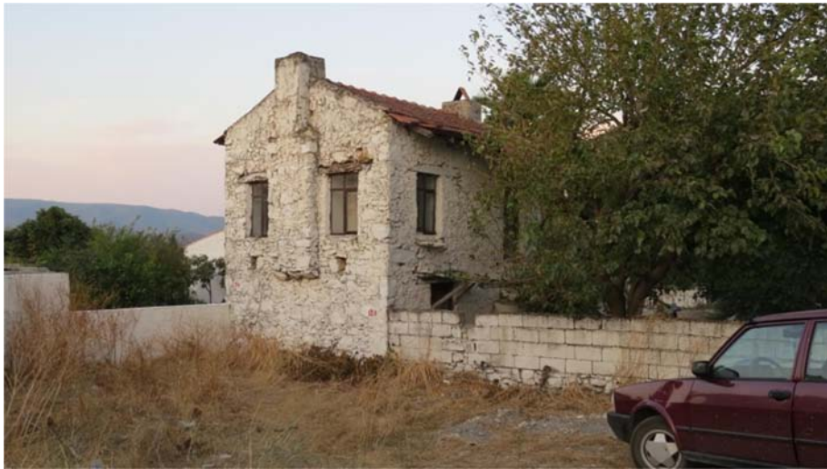
Şekil F.3 : 147 Env. No'lu yapı.
