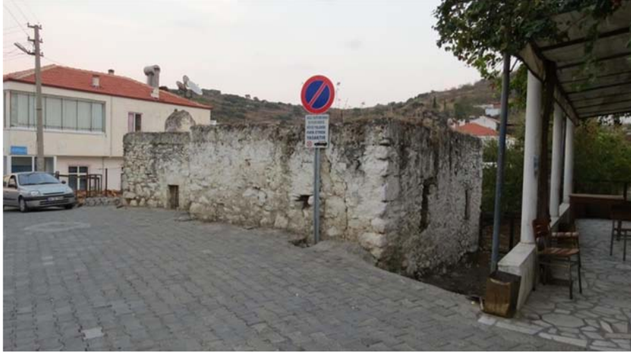
Şekil G.75 : Kuzeybatı cephesi.
