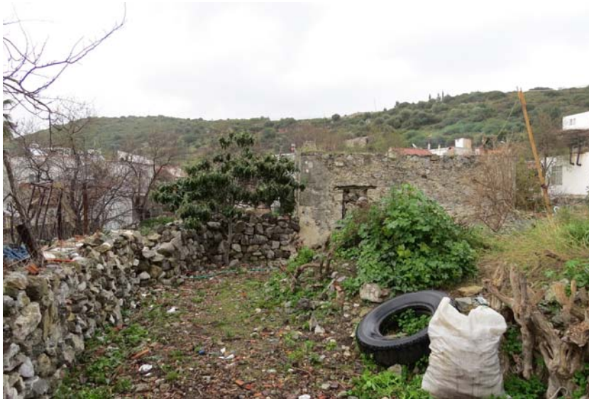
Şekil D.47 : 163 Env. No'lu yapının çıkmaz yolu.
