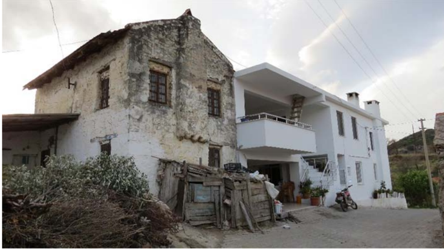
Şekil K.13 : 46 Env. No'lu yapının yanına eklenen yeni yapı.
