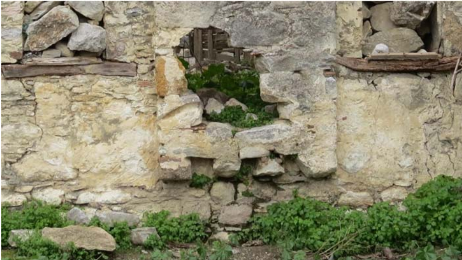
Şekil G.14 : Konsol taşlar üzerinde taşınan baca duvarları.
