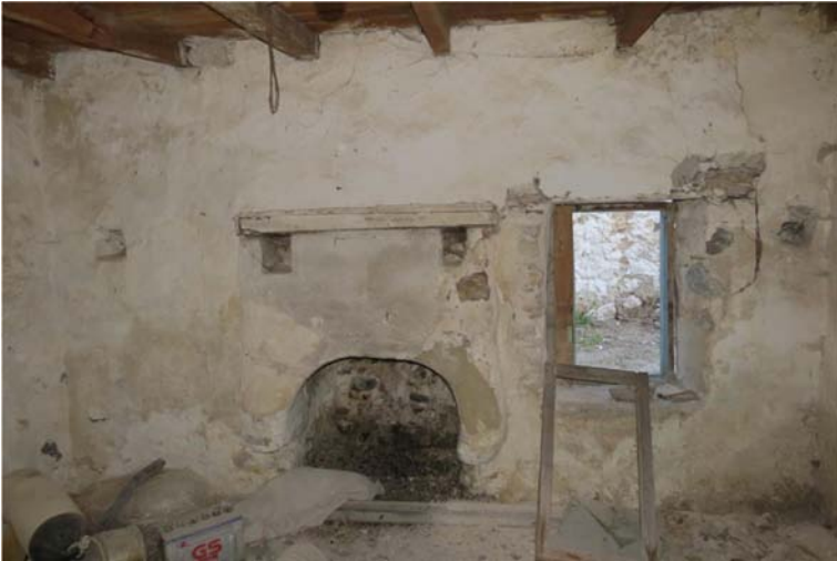
Şekil I.22 : Ocağın yanında tek pencere örneği, Env. No.113.
