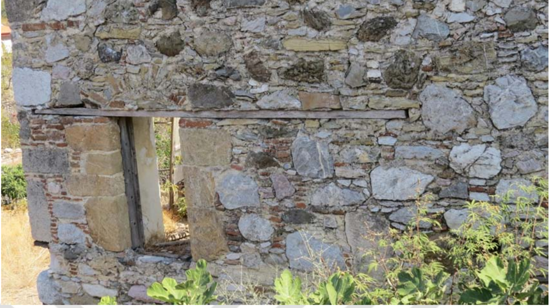
Şekil G.142 : Ahşap lento ve boşaltma kemeri.
