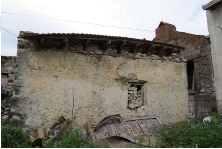
Şekil G.120 : Kuzeydoğu cephesi.
