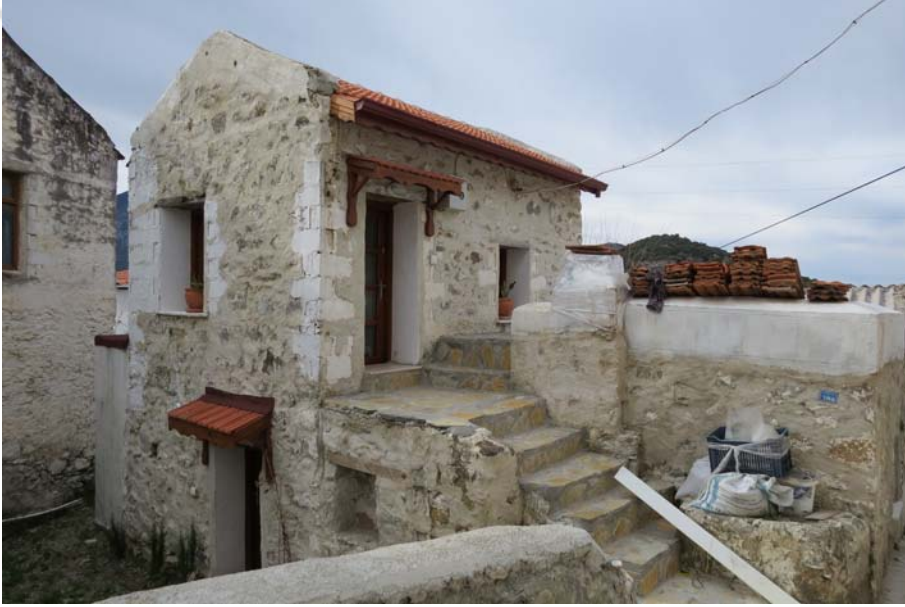
Şekil K.21 : 79 Env.no'lu yapının onarım sonrası durumu (2016).
