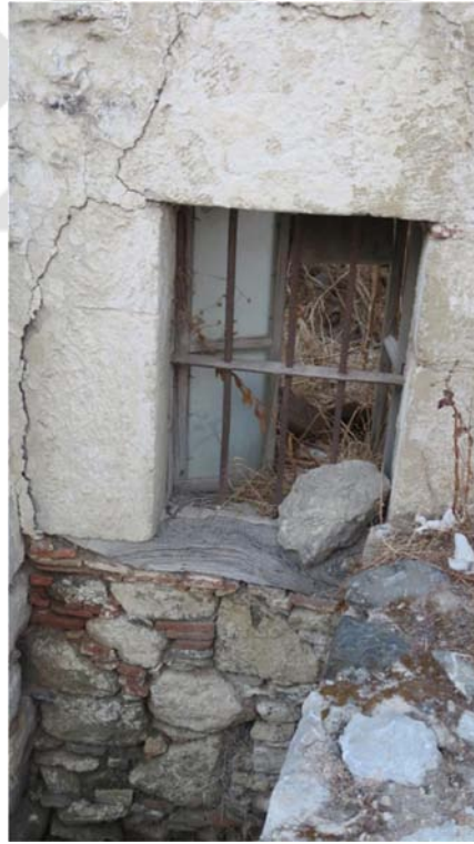
Şekil G.84 : Taş söveli demir parmaklıklı pencere (A odası).
