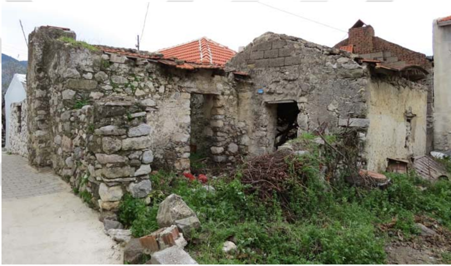
Şekil G.111 : Doğu avlu ve yapı girişleri.
