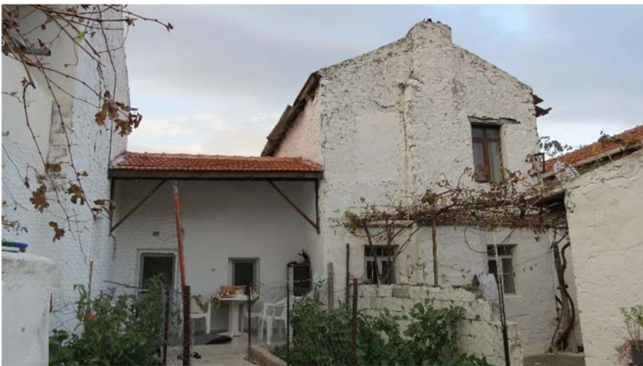
Şekil K.6 : 107 Env. No'lu yapının kapatılan penceresi ve ek yapılar.
