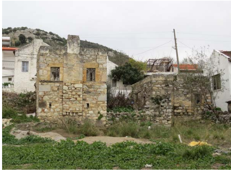
Şekil G.19 : Doğusunda bodrum katlı yapı.
