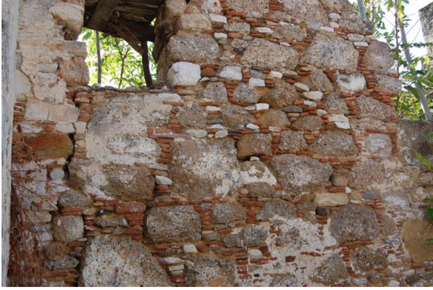
Şekil A.28 : Reşadiye Mahallesi’nde geleneksel bir konutun tuğla istifli taş duvar örgüsü.
