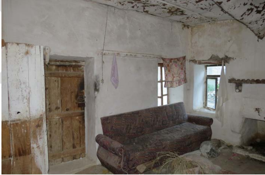
Şekil G.46 : Giriş kapısının bulunduğu kısa cephe.
