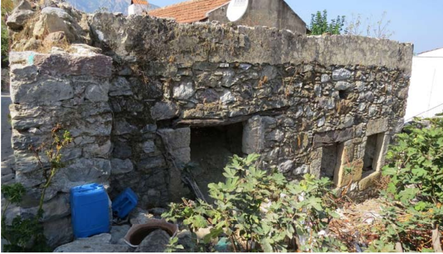
Şekil G.21 : Dış avlu cephesi.
