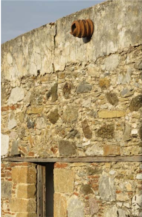
Şekil G.145 : Özgün çörtten ve pencere doğraması.
