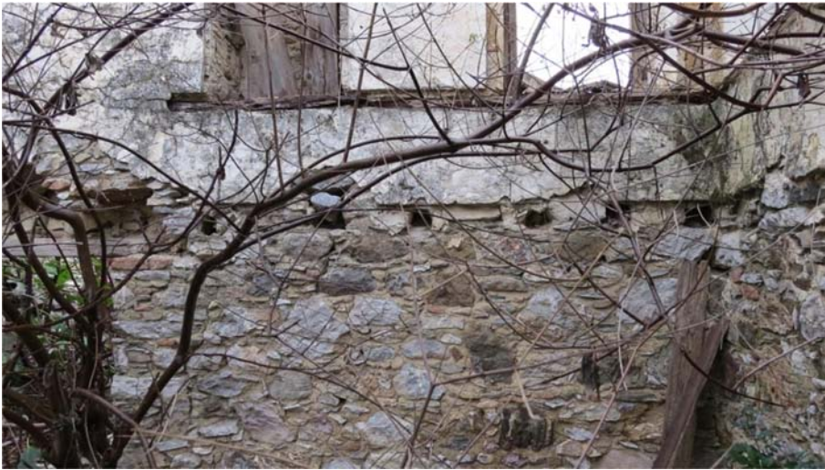
Şekil G.141 : Yok olan döşeme kirişlerinin yuvaları.
