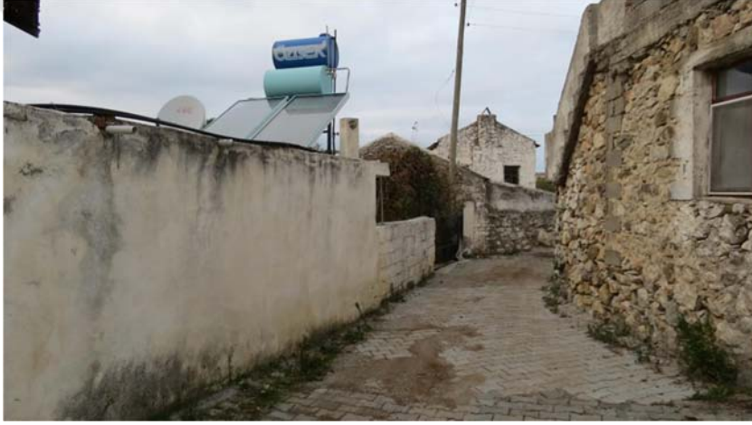
Şekil D.52 : 205a Env. No'lu yapının yer aldığı sokak.
