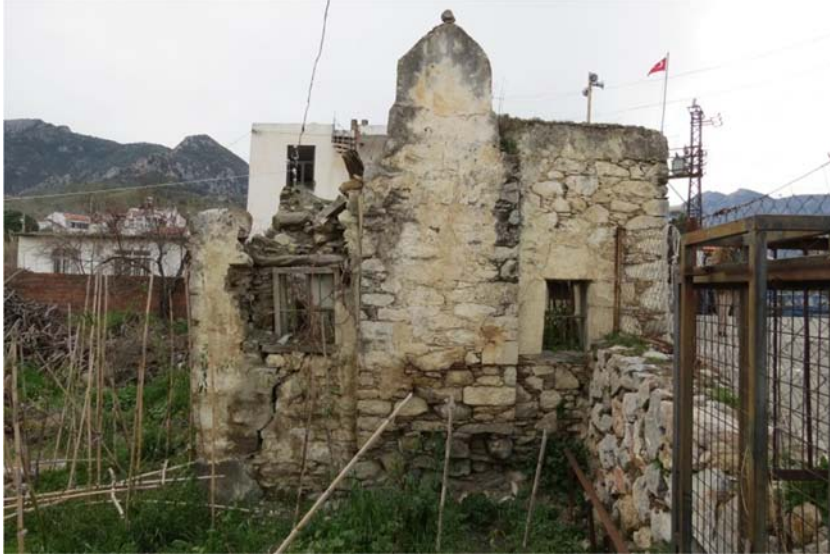
Şekil G.72 : Kuzeydoğu cephesi.
