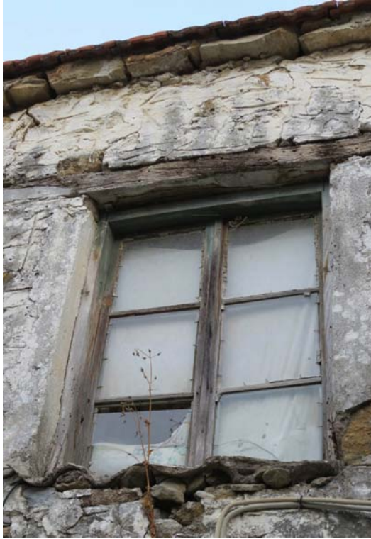
Şekil G.183 : 1.kat ve Zemin kat pencere doğrama detayları.
