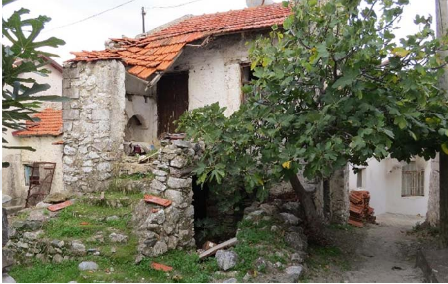
Şekil K.2 : Terk edilen 113 Env. No'lu yapı.
