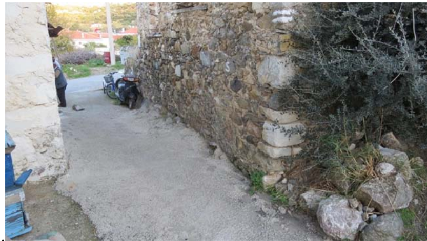
Şekil D.26 : Asfaltlanan sokak örneği, 28 Env. No'lu yapı sokağı.
