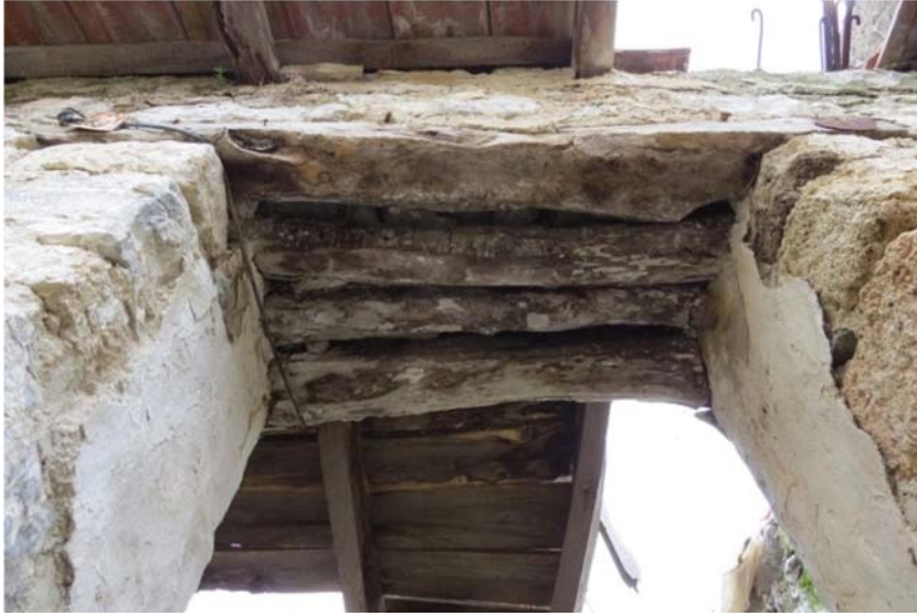
Şekil G.126 : Ahşap lentoyla geçilen giriş kapısı.
