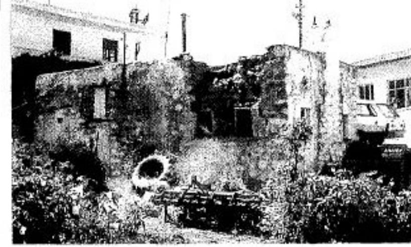
Şekil G.73 : Güneydoğu cephesi 2001 fotoğrafı (Başoğlu, 2001,s.95).
