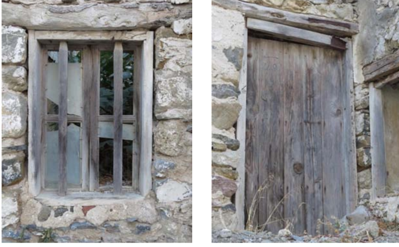
Şekil G.61 : Ahşap pencere ve bahçe kapısı.
