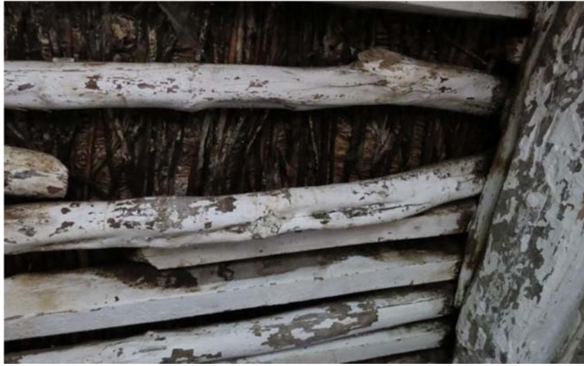
Şekil G.37 : Ahşap düver ve safran.
