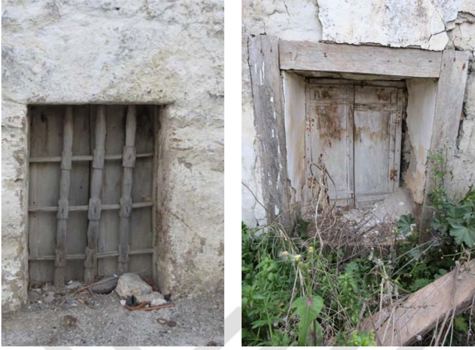
Şekil G.83 : Özgün ahşap kepenk ve parmaklık detayları.
