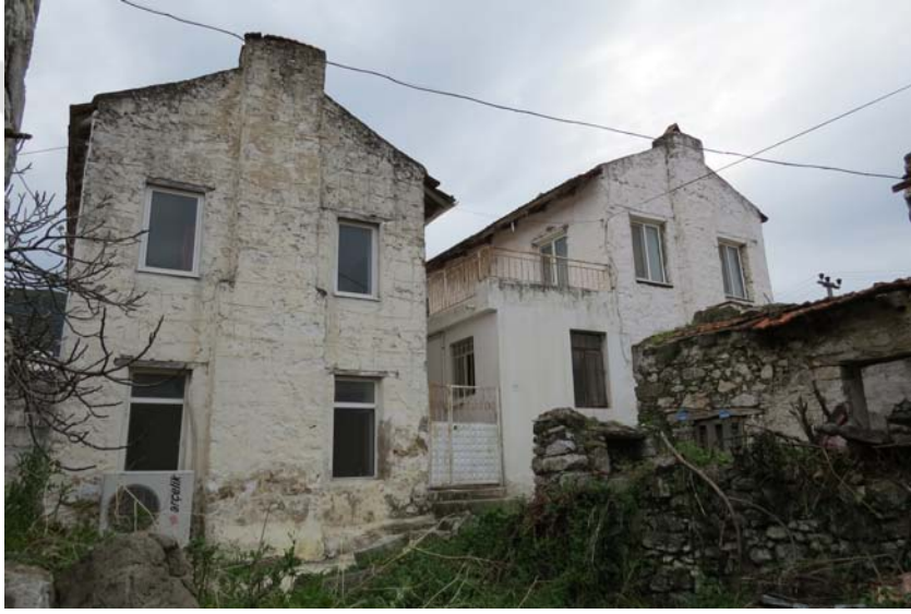
Şekil F.5 : İki katlı geleneksel konut örneği, 107 ve 108 Env. No'lu yapılar.
