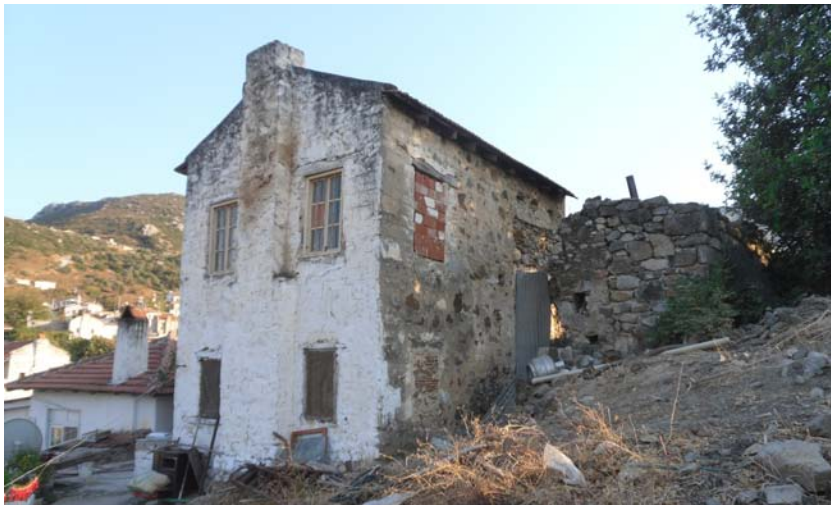
Şekil F.30 : 52 Env. No'lu yapı.
