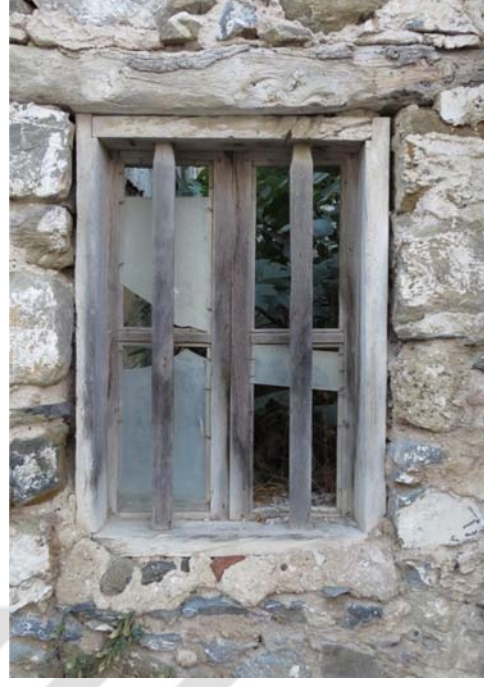
Şekil I.6 : Kapaklı ve ahşap parmaklıklı pencere örnekleri.
