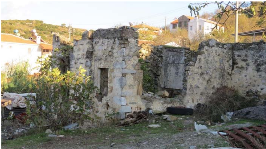
Şekil G.89 : Güneybatı cephesi.
