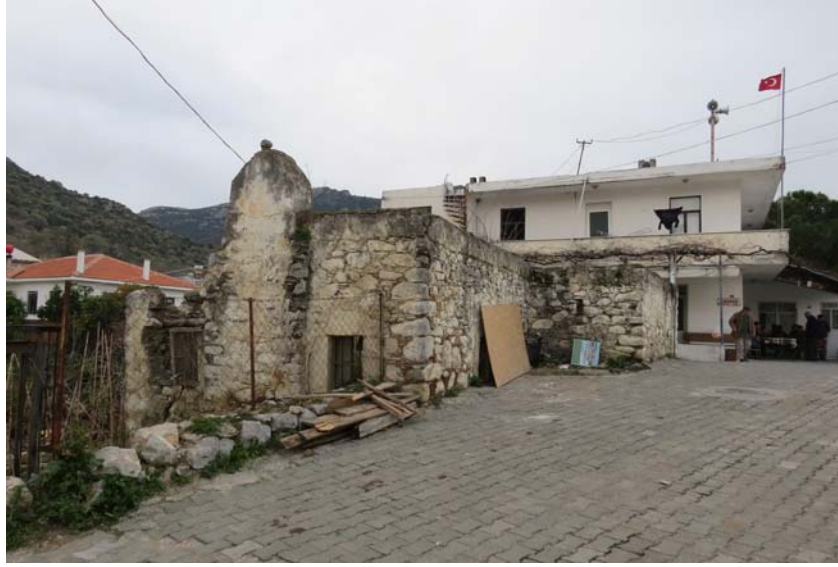
Şekil G.69 : Köyiçi yoluna bitişik yapı 101 Env. No'lu yapı.
