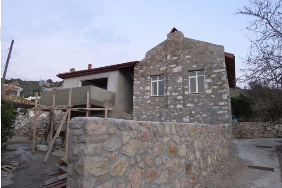
Şekil K.19 : 211 Env.no'lu yapının onarım sonrası durumu (2016).
