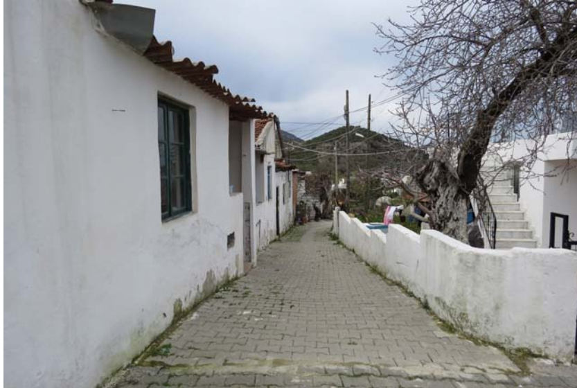
Şekil D.32 : 28a Env. No'lu yapının sokağı.
