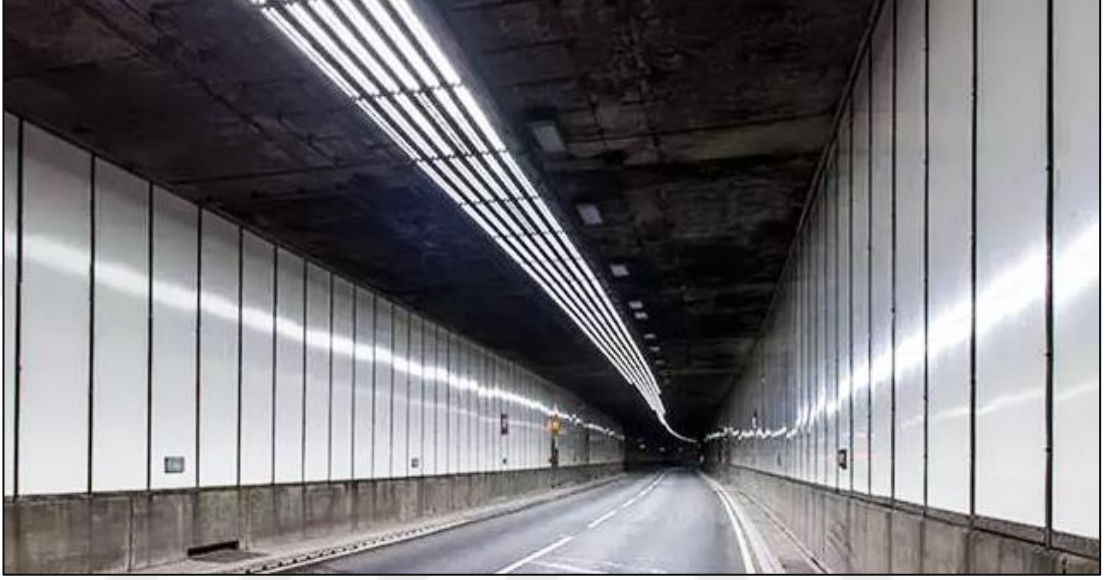
Şekil 3.8. LED şerit ile tünel aydınlatması
