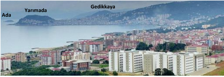
Kentte yoğun yapılaşma
