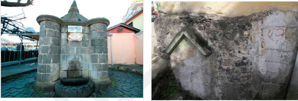
Resim 4.49. Alman Çeşmesi ve yapı dış duvarıyla hemiyüz bir sokak çeşmesi
