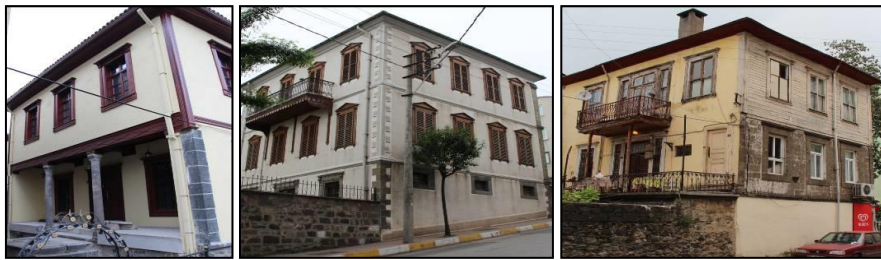
Resim 4.25. Zeytinlik Konutlarında çıkmalı ve düz cephe tipleri
