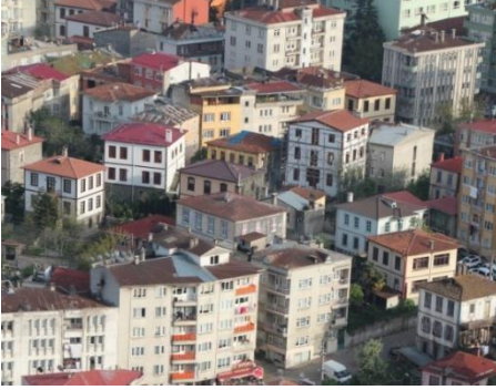
Tescilli yapıları saran çok katlı yapılaşma
