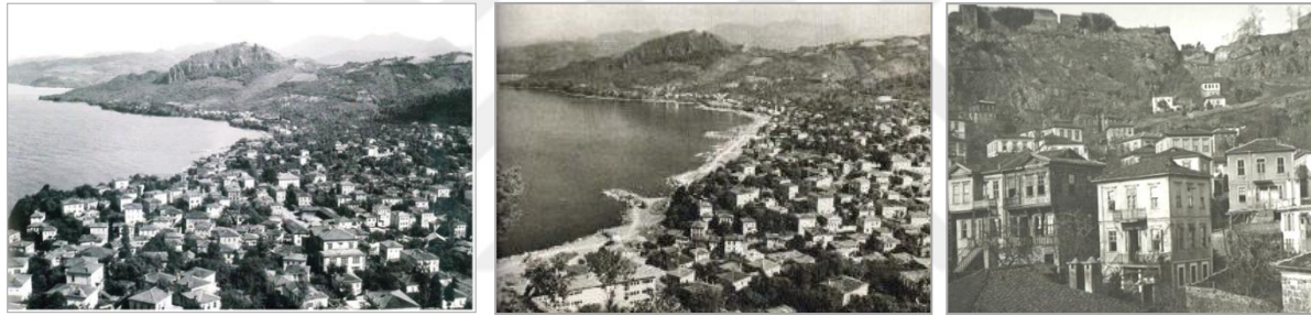
Resim 5.12. 1960 lardan 1970 lede Zeytinlik Mahallesi ve Kaleye doğru yapılaşma biçimi (Eski Giresun Kartpostaları, Giresun Eski Resimleri)
