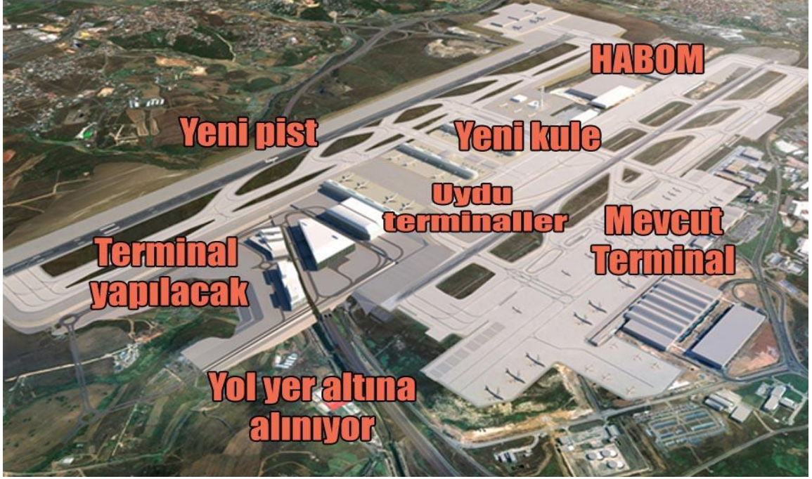
Şekil 4.19: İSG Havalimanı 2.Pist ve Kule Projesi
