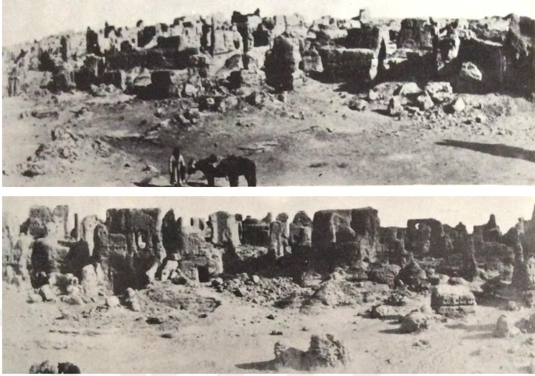
Şekil 3.3 Kara koço şehri kalıntıları (Cezar, 1977)
