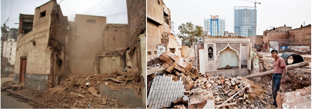
Şekil 3.16 Yıkılan kerpiç yapılar (URL-26, 2016)
