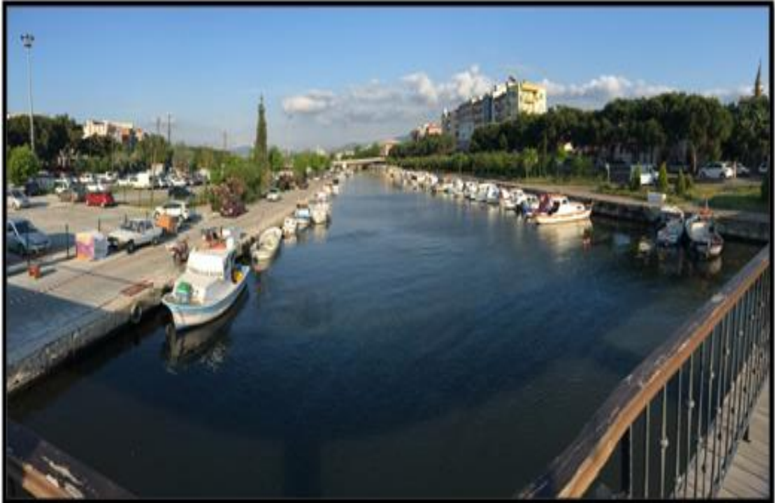
Şekil 4.32. Sarıçay Parki rıhtım düzenlemesi
