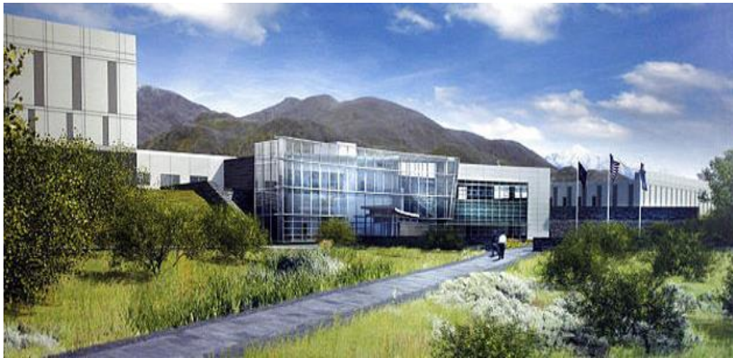
Şekil 2.36. NSA Veri Merkezi. (NSA, 2015)
