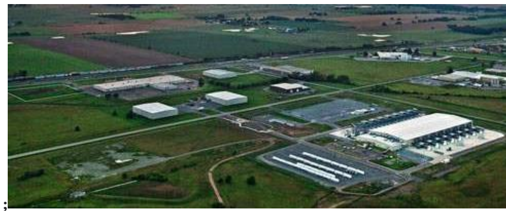
Şekil 2.37. Google Veri Merkezi. (Google Inc., 2014)
