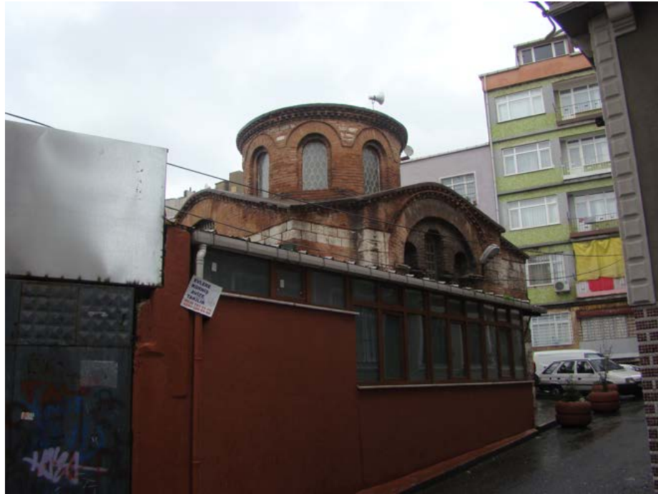
Şekil A.83 : Hırami Ahmet Paşa Mescidi'nin güney cephesi (2015).
