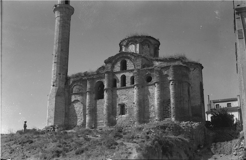
Şekil A.17 : Bodrum Camii (Mirelaion Manastırı Kilisesi)'nin güney cephesi (Artamonoff, Nisan 1935).
