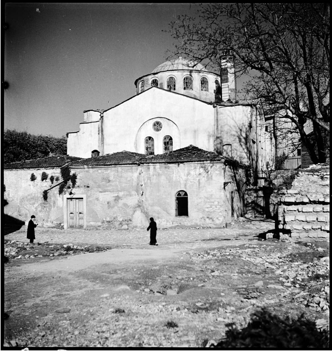
Şekil A.90 : Kalenderhane Camii (Kyriotissa Meryem Kilisesi)'nin batı cephesi (Artamonoff, Haziran 1935).
