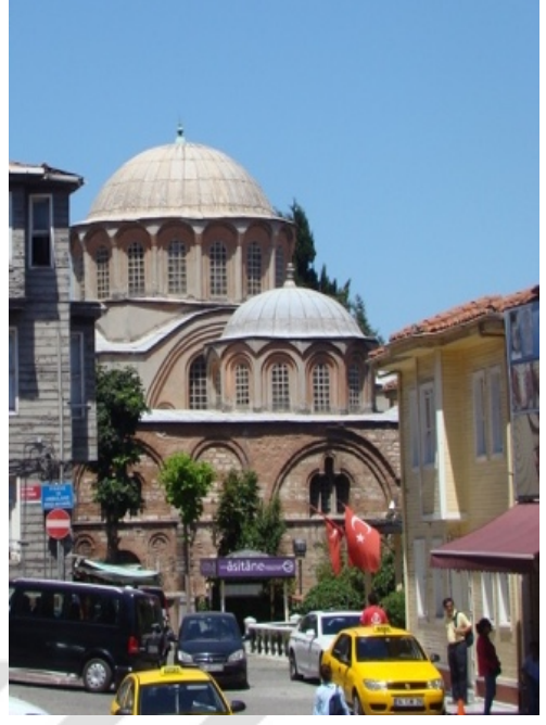
Şekil 4.282 : Kariye Müzesi (Khora Manastırı Kilisesi)’nin güney cephesi (2013).
