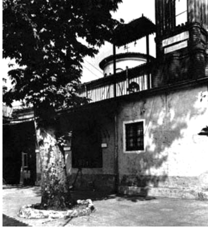
Şekil 4.401 : Meryem Ana Kilisesi (Panayia Muhliotissa Kilisesi)’nin iç avlusundan batı cephesi (Mathews, 1968-73).
