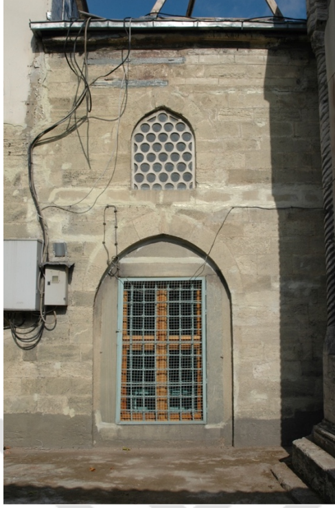
Şekil 4.330 : Koca Mustafa Paşa Camii (Ayias Andreas en te Krisei Manastırı Kilisesi)'nin güneydoğu cephesi pencere detayı (Yeşim Güngör, 2015).
