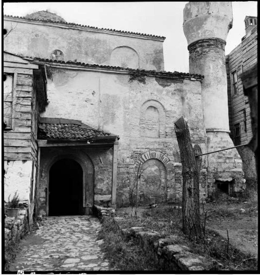
Şekil A.24 : Eski İmaret Camii (Pantepoptes Manastırı Kilisesi)'nin batı cephesi (Artamonoff, Şubat 1937).
