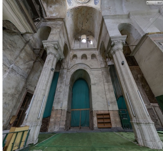
Şekil 4.489 : Zeyrek Kilise Camii (Pantakrotor Manastırı Kilisesi) Güney Kilise'den Parekklesion'a geçiş (Nuran Nar, 2011).
