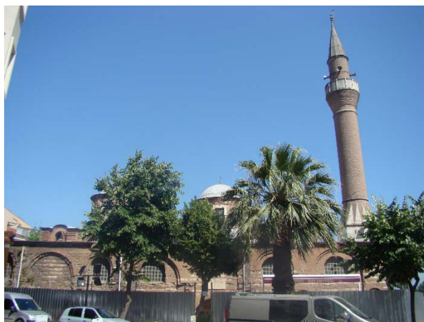
Şekil 4.119 : Fenari İsa Camii (Lips Manastırı Kilisesi)'nin kuzeybatı cephesi (2013).
