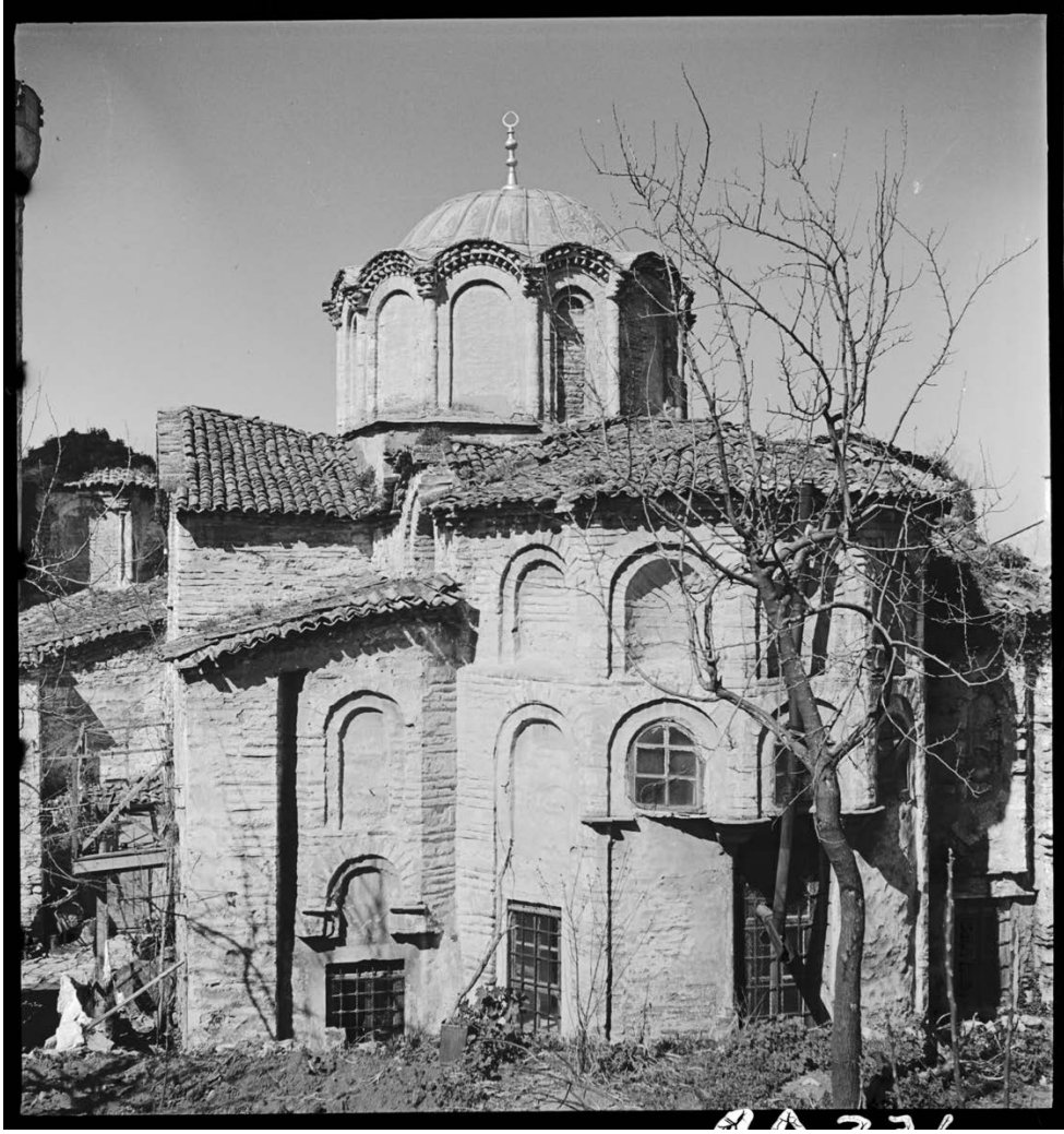
Şekil A.156 : Vefa Kilise Camii'nin doğu cephesi (Artamonoff, Mart 1937).
