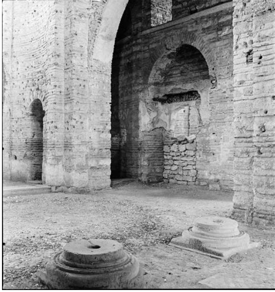
Şekil 4.132 : Fenari İsa Camii (Lips Manastırı Kilisesi) Güney Kilise’den Eksonarteks bölümüne geçiş (Artamonoff, Aralık 1935)
