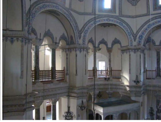
Şekil 4.367 : Küçük Ayasofya Camii (Sergios ve Bakkhos Kilisesi)'nin galeri katının güneydoğudan görünümü (2013).
