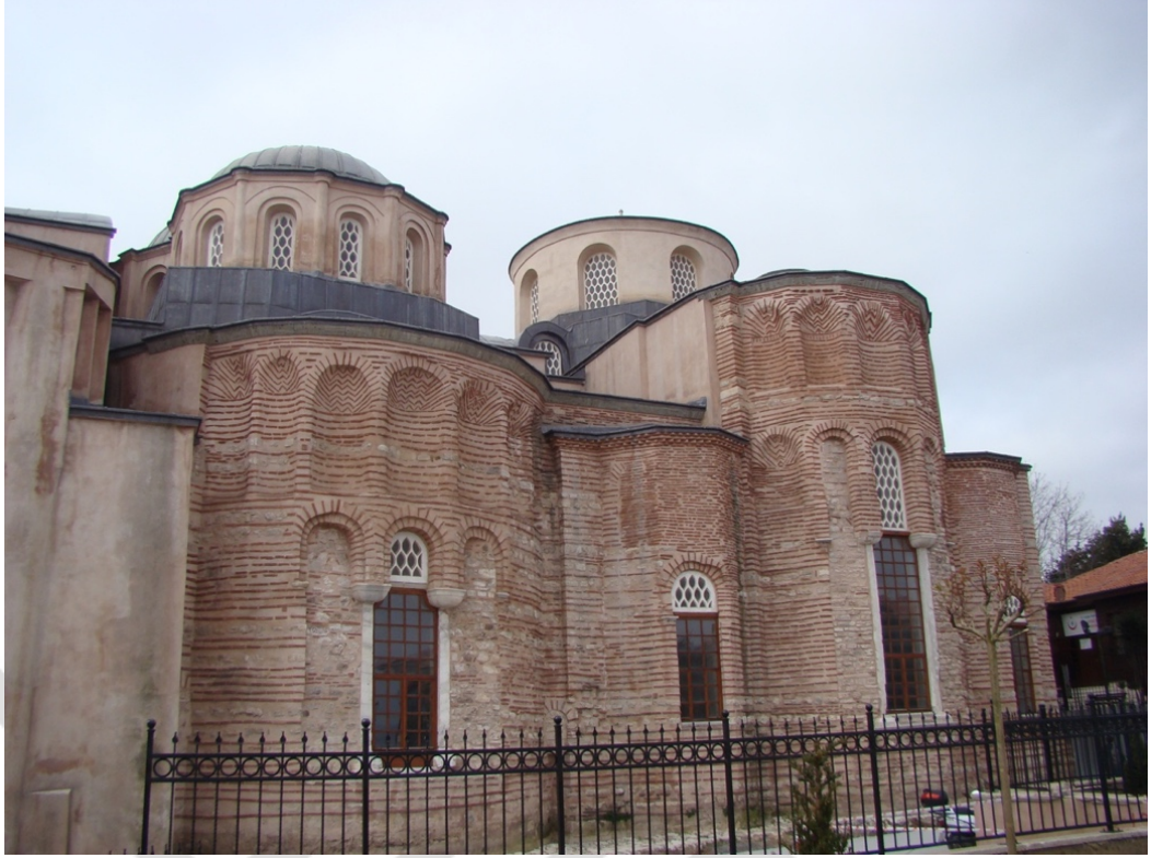
Şekil 4.462 : Zeyrek Kilise Camii (Pantakrotor Manastırı Kilisesi)'nin mezar şapeli ve Kuzey Kilise'nin apsisi (2016).
