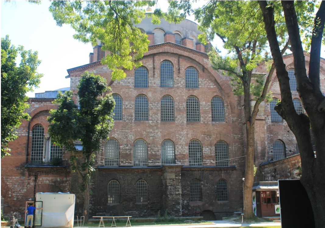
Şekil A.7 : Aya İrini Müzesi (Ayia İrene Kilisesi)'nin kuzeydoğu cephesi (2013).
