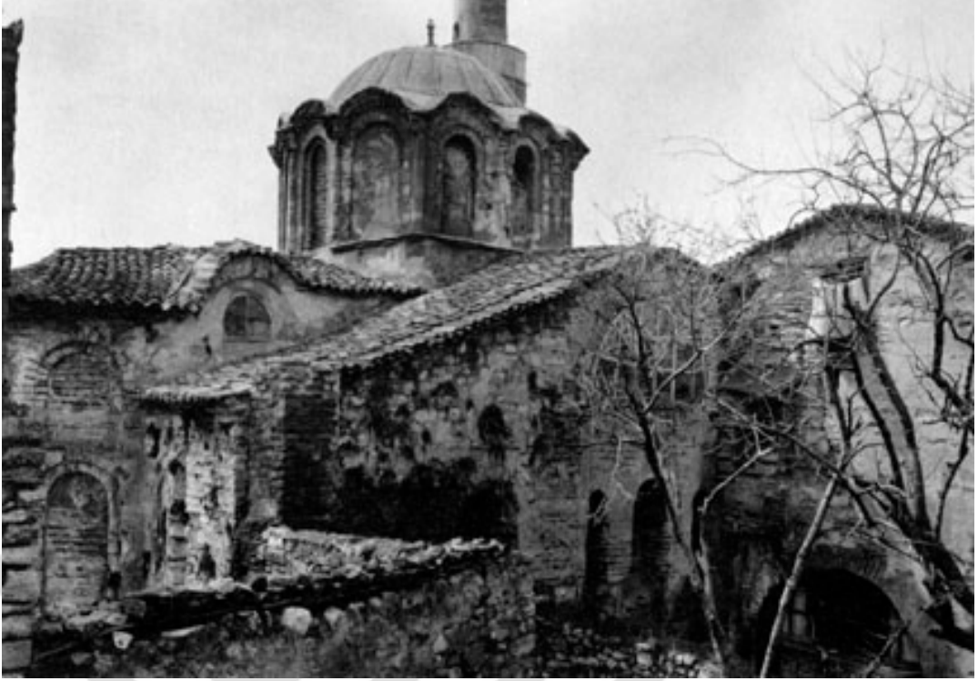
Şekil A.162 : Vefa Kilise Camii'nin kuzey cephesi (Porter, 1920).
