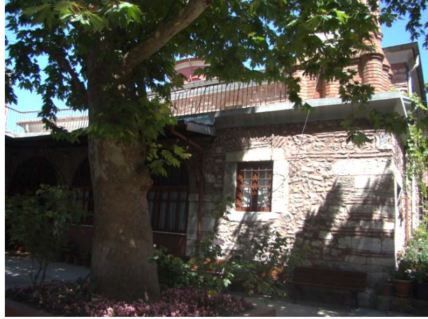
Şekil 4.402 : Meryem Ana Kilisesi (Panayia Muhliotissa Kilisesi)’nin iç avlusundan batı cephesi (2013).
