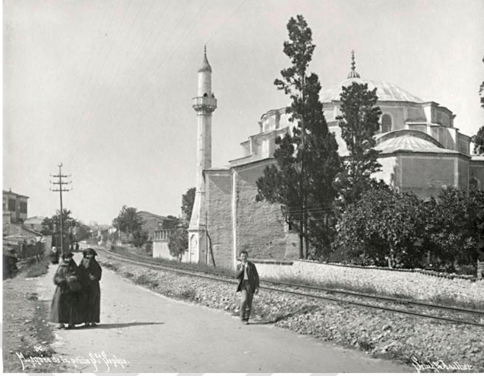
Şekil 4.344 : Küçük Ayasofya Camii (Sergios ve Bakkhos Kilisesi)'nin doğu cephesi (Sébah & Joaillier, 19.yy sonu).
