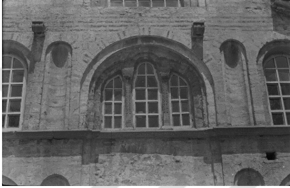
Şekil 4.146: Fethiye Camii ve Müzesi (Pammakaristu Manastırı Kilisesi) Parekklesion'un güney cephesi pencere detayı (Artamonoff, Mayıs 1938).
