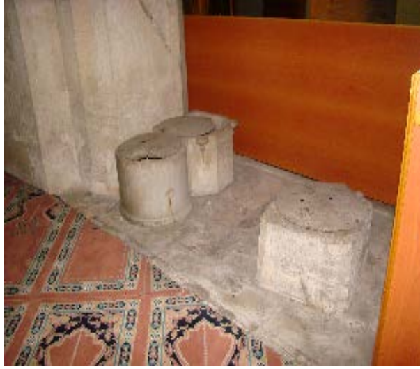
Şekil 4.171 : Fethiye Camii ve Müzesi (Pammakaristu Manastırı Kilisesi)'nin kuzeybatıdaki ayağın altındaki sarnıç (2015).
