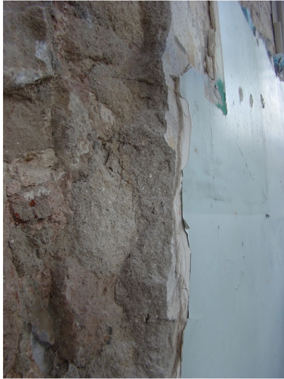
Şekil 4.329 : Koca Mustafa Paşa Camii (Ayias Andreas en te Krisei Manastırı Kilisesi)'nin son cemaat yerindeki çimento sıva detayı (2016).
