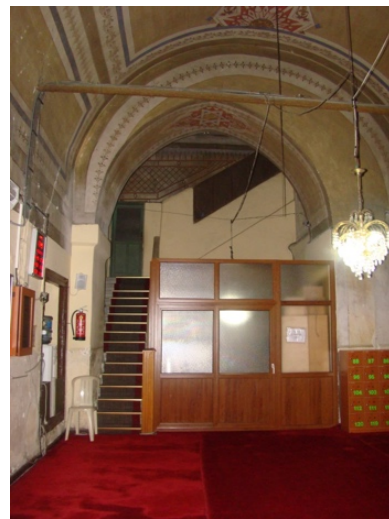
Şekil 4.213 : Gül Camii (Azize Theodosia Kilisesi)'nin kuzeydoğusundaki merdiven kovası (2015).
