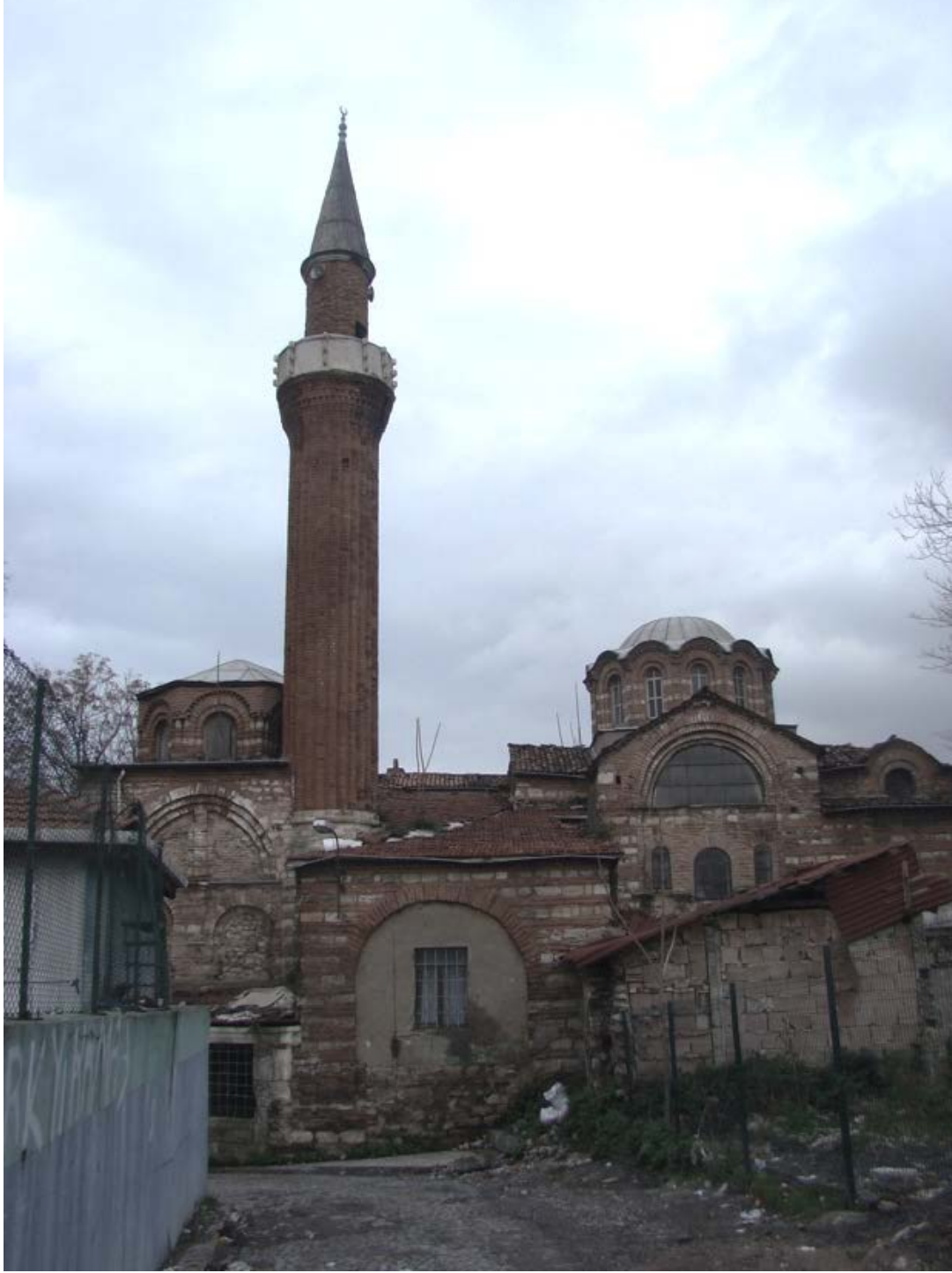
Şekil A.159 : Vefa Kilise Camii'nin güney cephesi (2015).
