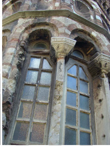
Şekil 4.156 : Fethiye Camii ve Müzesi (Pammakaristu Manastırı Kilisesi) Parekklesion'un apsisi pencere detayı (2013).
