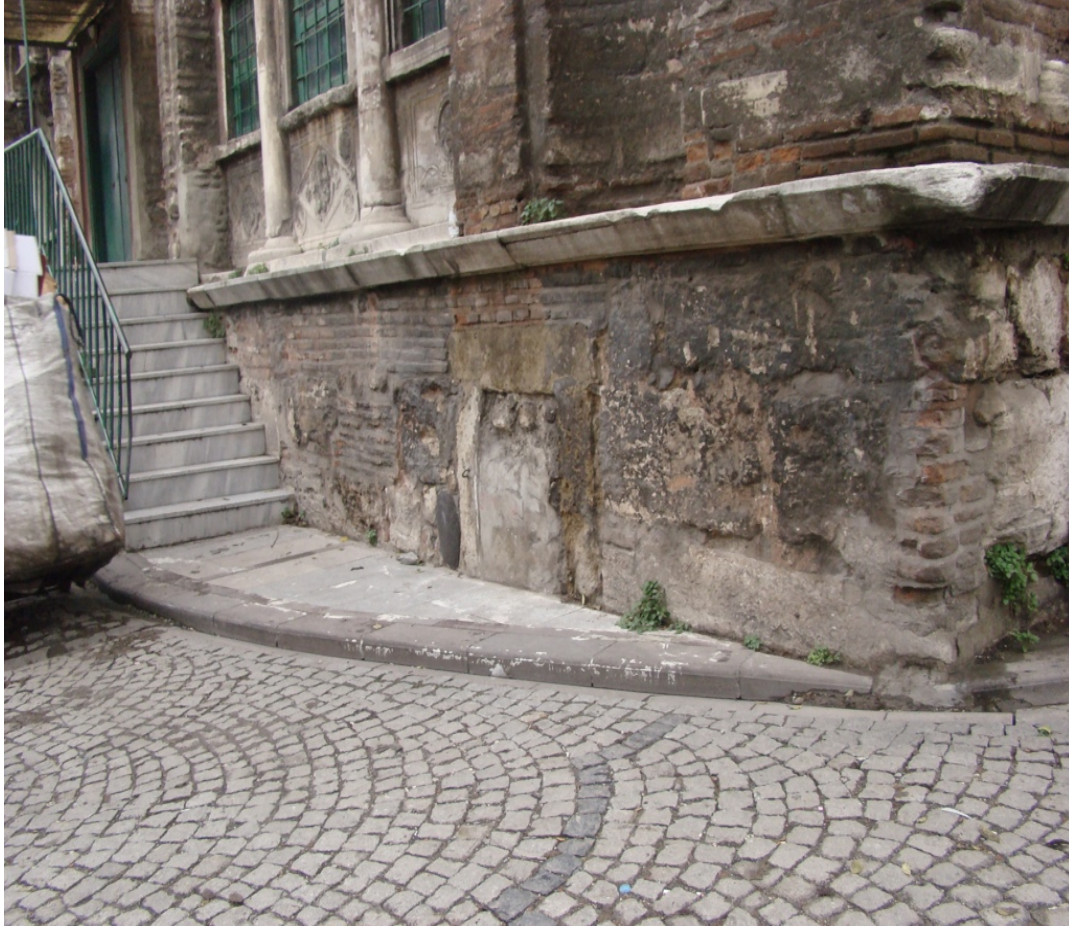
Şekil 4.434 : Vefa Kilise Camii'nin batı cephesinde kapatılan açıklık (2015).
