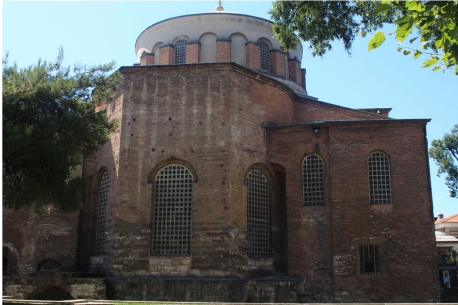
Şekil 4.11 : Aya İrini Müzesi (Ayia İrene Kilisesi)’nin güneydoğu cephesi (2013).
