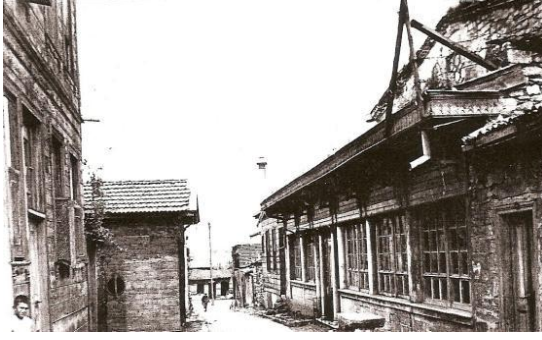
Şekil 4.50 : Atik Mustafa Paşa Camii'nin kuzeybatı cephesi (Encümen Arşivleri, 1940?).
