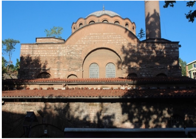
Şekil 4.240 : Kalenderhane Camii (Kyriotissa Meryem Kilisesi)'nin batı cephesi (2013).
