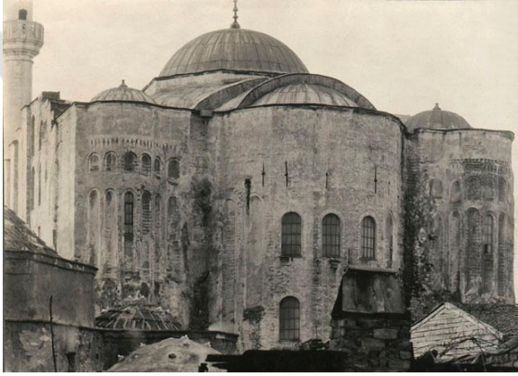
Şekil 4.188 : Gül Camii (Azize Theodosia Kilisesi)'nin güneydoğu cephesi (Porter, 20.yy başı).
