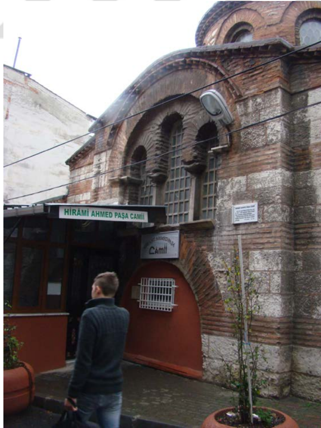
Şekil 4.222 : Hırami Ahmet Paşa Mescidi'nin doğu cephesindeki cami girişi (2015).
