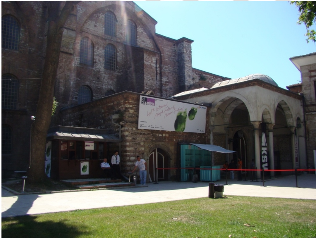
Şekil 4.19 : Aya İrini Müzesi (Ayia İrene Kilisesi)’nin kuzeydoğu cephesi (2013).
