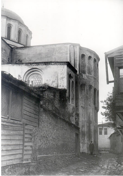
Şekil 4.454 : Zeyrek Kilise Camii (Pantakrotor Manastırı Kilisesi)'nin doğu cephesi (Sender, 1930).
