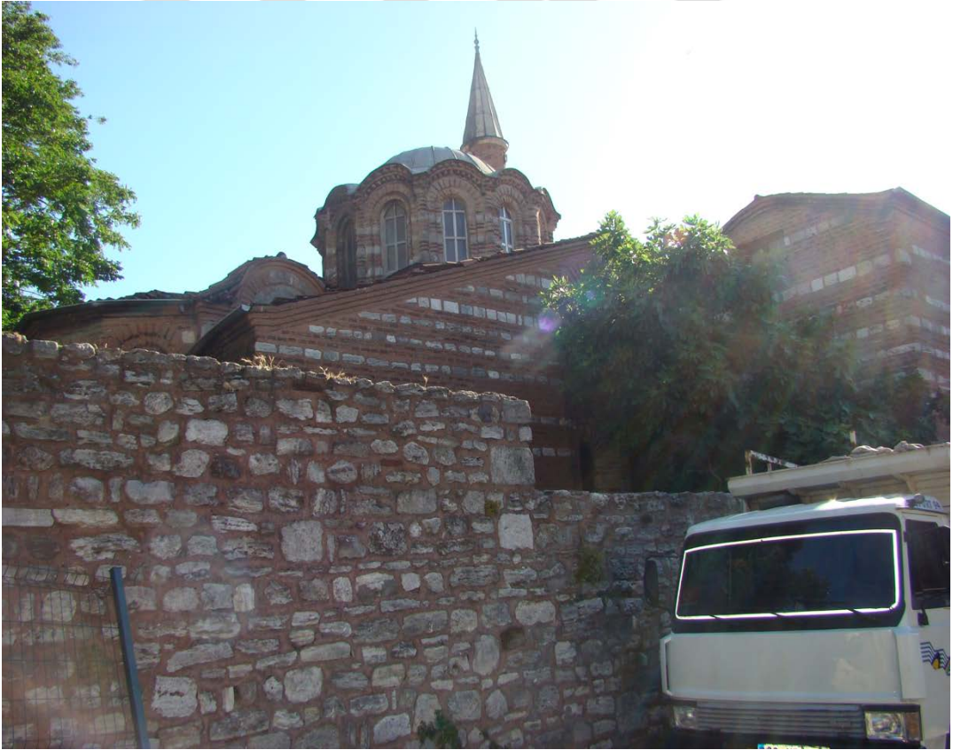
Şekil A.163 : Vefa Kilise Camii'nin kuzey cephesi (2013).
