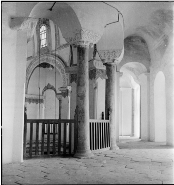
    l 4.364 : K    k Ayasofya Camii (Sergios ve Bakkhos Kilisesi)'nin galeri katındaki s  t  nlar (Artamonoff, Kasım 1935).
