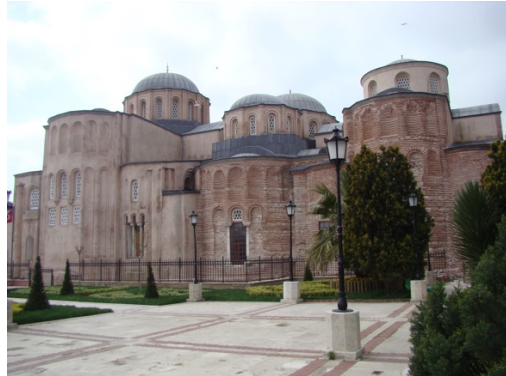
Şekil 4.461 : Zeyrek Kilise Camii (Pantakrotor Manastırı Kilisesi)'nin doğu cephesi (2016).
