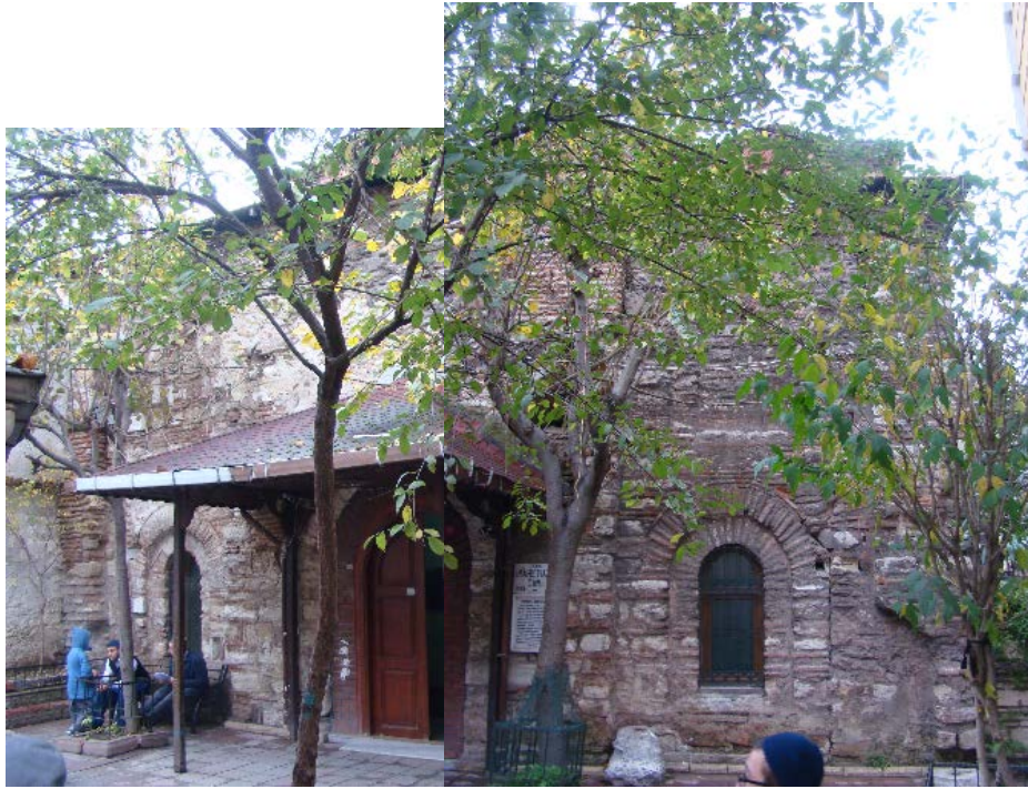
Şekil A.25 : Eski İmaret Camii (Pantepoptes Manastırı Kilisesi)'nin batı cephesi (2015).
