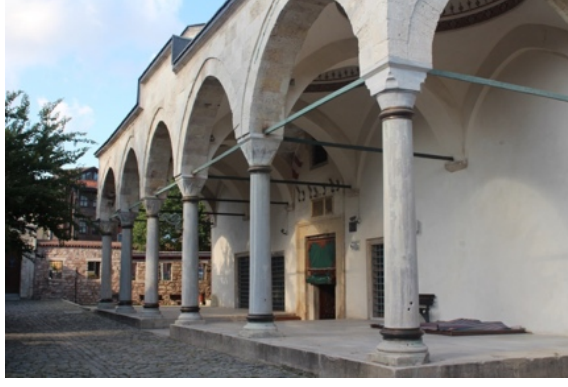
Şekil 4.350 : Küçük Ayasofya Camii (Sergios ve Bakkhos Kilisesi)'nin batı cephesi (2013).
