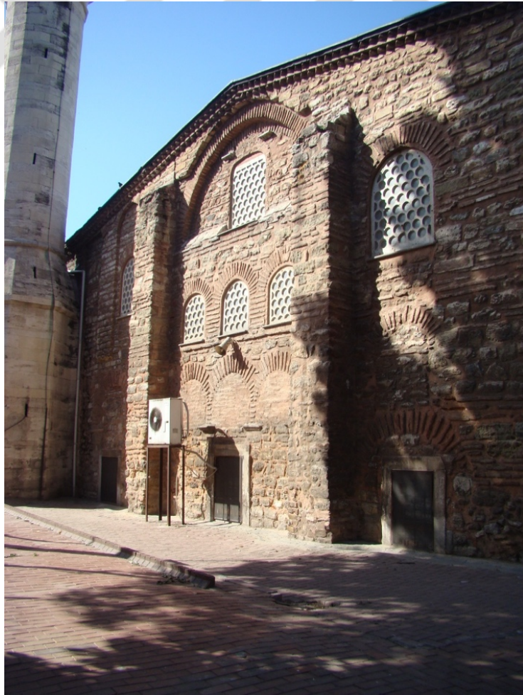
Şekil 4.44 : Atik Mustafa Paşa Camii'nin güneybatı cephesi (2013).
