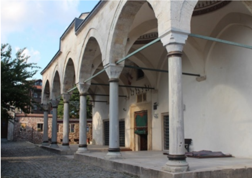
  kil A.131 : K    k Ayasofya Camii (Sergios ve Bakkhos Kilisesi)'nin batı cephesi (2013).
