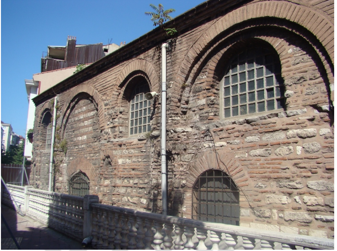
Şekil 4.120 : Fenari İsa Camii (Lips Manastırı Kilisesi)'nin kuzeybatı cephesindeki kapatılmış pencere (2013).
