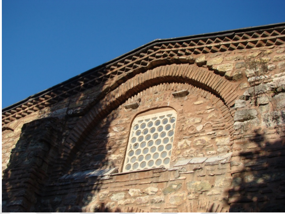
Şekil 4.43 : Atik Mustafa Paşa Camii'nin güneybatı cephesindeki değişmiş pencere (2015).
