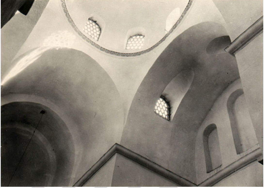
Şekil A.172 : Zeyrek Kilise Camii (Pantakrotor Manastırı Kilisesi) Kuzey Kilise'nin güney haçının kolu ve kubbe (Porter, 20.yy başı).
