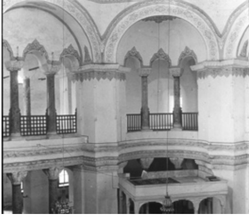
Şekil 4.366 : Küçük Ayasofya Camii (Sergios ve Bakkhos Kilisesi)'nin galeri katının güneydoğudan görünümü (Artamonoff, Kasım 1935).
