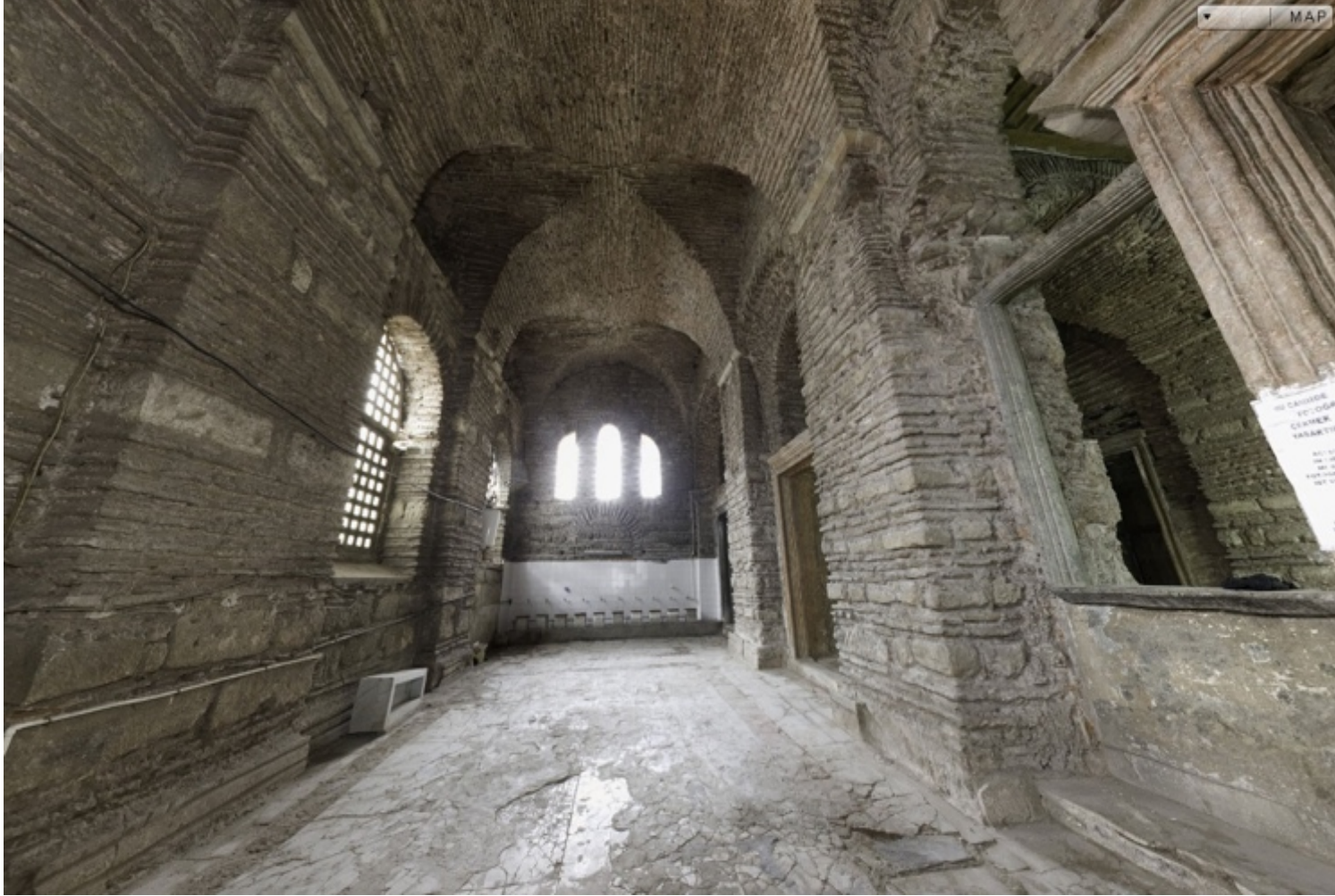
Şekil A.179 : Zeyrek Kilise Camii (Pantakrotor Manastırı Kilisesi) Güney Kilise'nin dış narteksi (Nuran Nar, 2011
