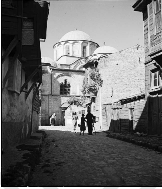
Şekil 4.281 : Kariye Müzesi (Khora Manastırı Kilisesi)’nin güney cephesi (Artamonoff, Mayıs 1937).
