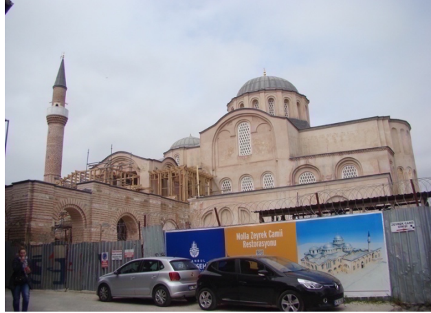
Şekil 4.453 : Zeyrek Kilise Camii (Pantakrotor Manastırı Kilisesi)'nin güney cephesi (2016).
