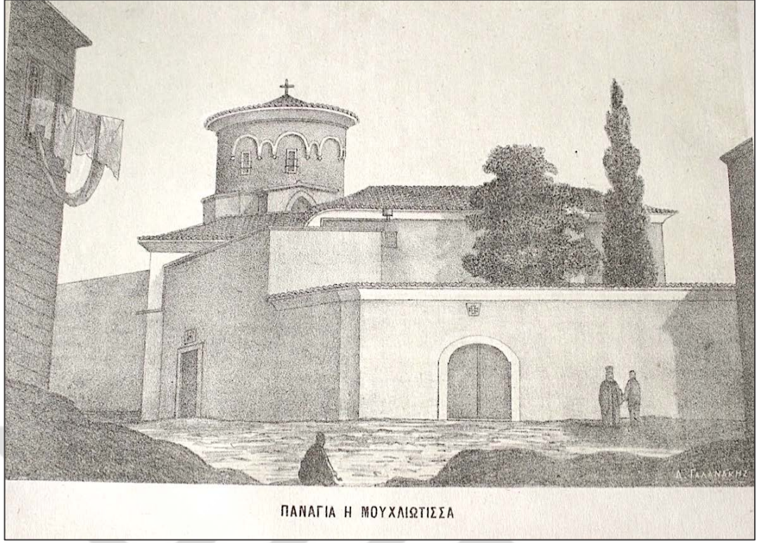
Şekil 4.396 : Meryem Ana Kilisesi (Panayia Muhliotissa Kilisesi)’nin batı cephesi (Galanakis, 1877).
