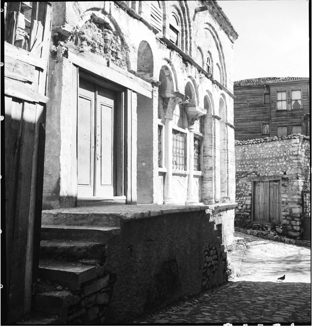
Şekil A.160 : Vefa Kilise Camii'nin batı cephesi (Artamonoff, Nisan 1935).
