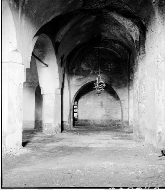
Şekil 4.172 : Fethiye Camii ve Müzesi (Pammakaristu Manastırı Kilisesi) narteksin güneyi (Artamonoff, Mayıs 1937).
