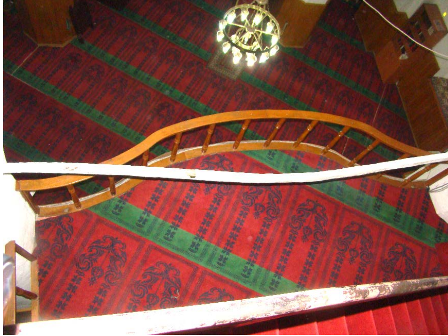
Şekil 4.111 : Eski İmaret Camii (Pantepoptes Manastırı Kilisesi)’nin gergilerindeki eğrilikler (2015).
