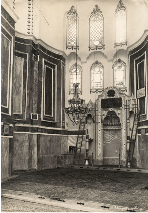
Şekil 4.480 : Zeyrek Kilise Camii (Pantakrotor Manastırı Kilisesi) Güney Kilise’nin apsisi (Abdullah Frères, 1880).
