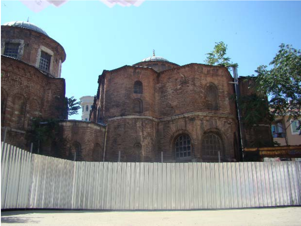
Şekil A.37 : Fenari İsa Camii (Lips Manastırı Kilisesi)'nin güneydoğu cephesi (2013).
