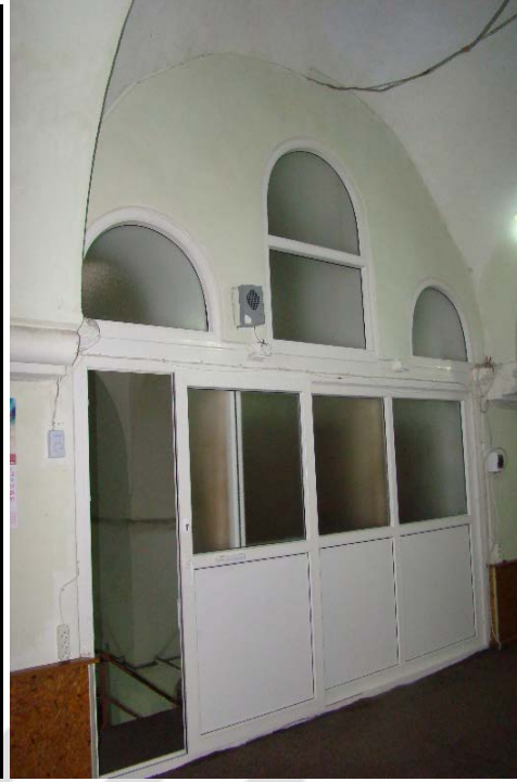
Şekil 4.107 : Eski İmaret Camii (Pantepoptes Manastırı Kilisesi)'nin galeri katından bakış (2015).
