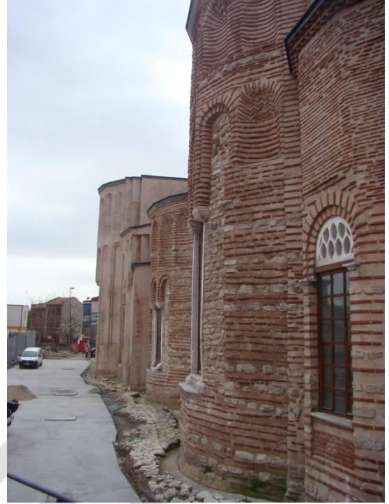
Şekil 4.457 : Zeyrek Kilise Camii (Pantakrotor Manastırı Kilisesi)'nin doğu cephesi (2016).
