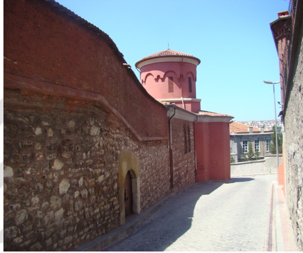
Şekil 4.395 : Meryem Ana Kilisesi (Panayia Muhliotissa Kilisesi)'ne güneydoğudan bakış (2013).
