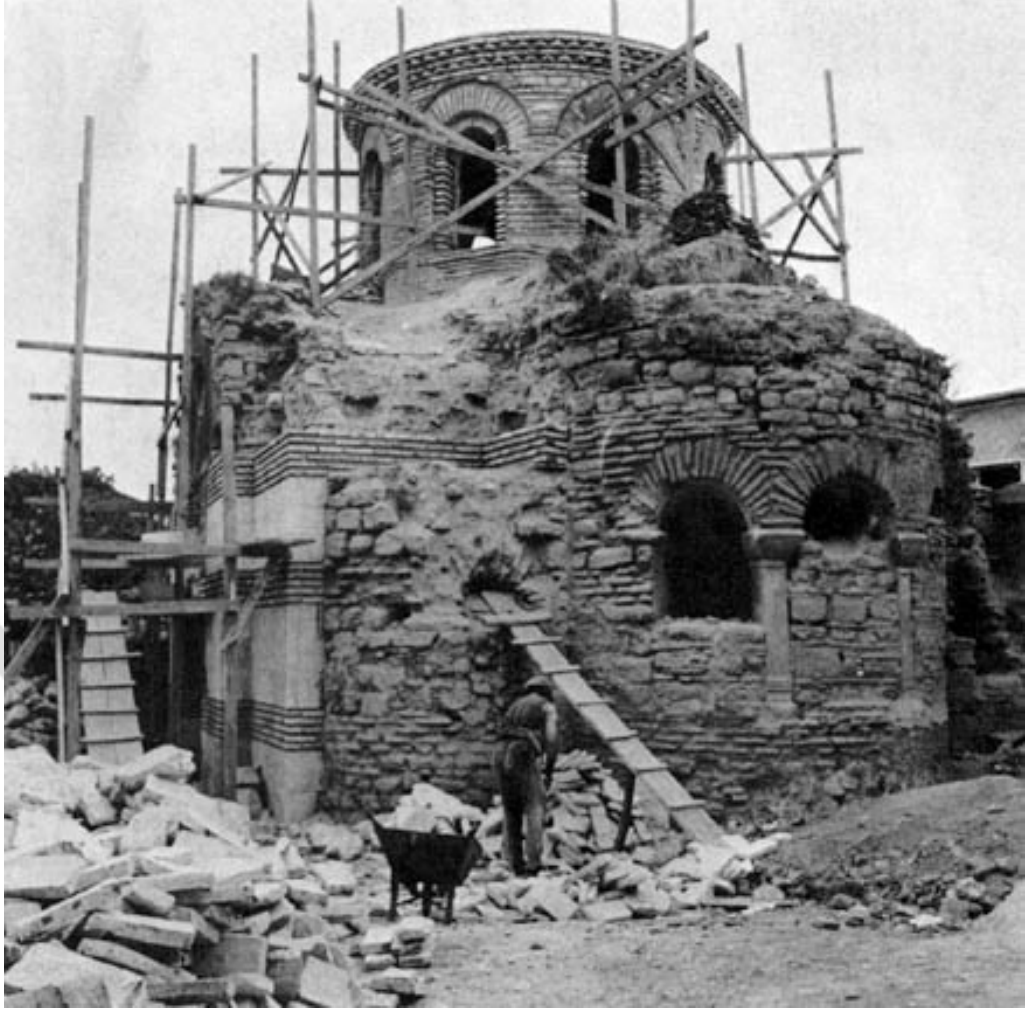
Şekil A.85 : Hırami Ahmet Paşa Mescidi'nin apsisi restorasyon sırasında (Dumberton Oaks, 1960).
