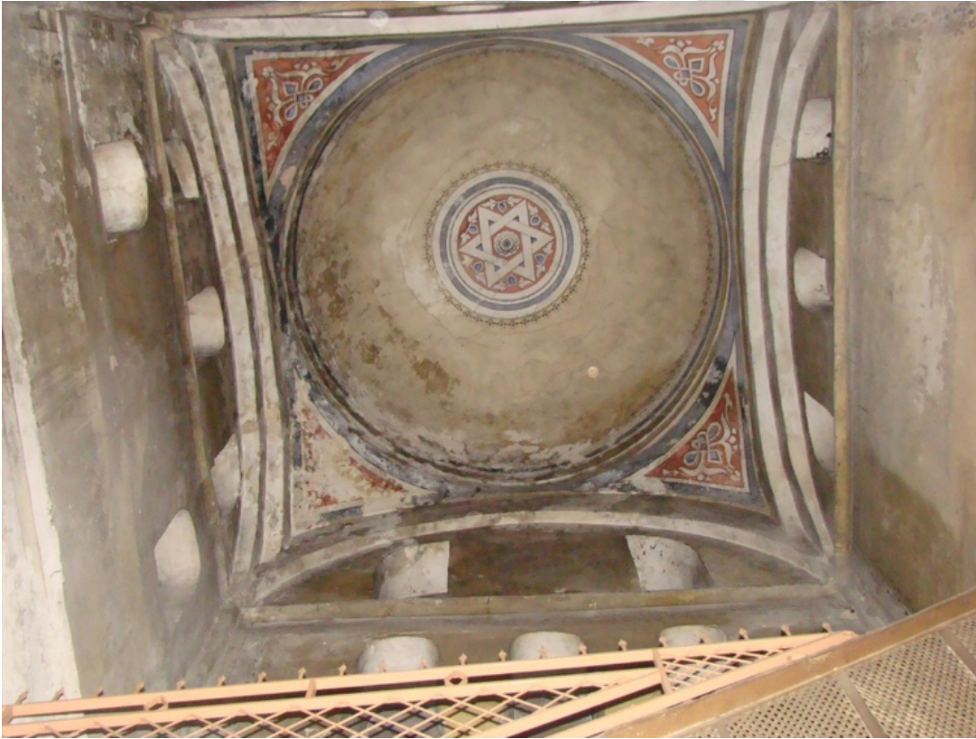
Şekil A.79 : Gül Camii (Azize Theodosia Kilisesi)'nin kuzeyindeki köşe kubbe (2013).
