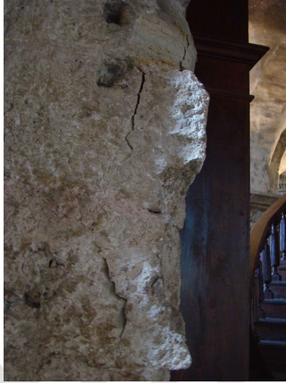
Şekil 4.32 : Aya İrini Müzesi (Ayia İrene Kilisesi)'nin taş yüzeylerinde kopmalar (2015).
