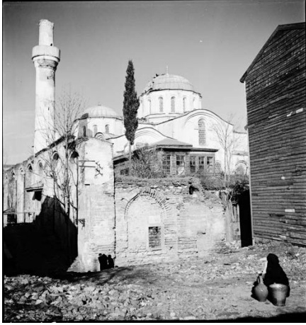
Şekil 4.452 : Zeyrek Kilise Camii (Pantakrotor Manastırı Kilisesi)'nin güney cephesi (Artamonoff, Mart 1936).
