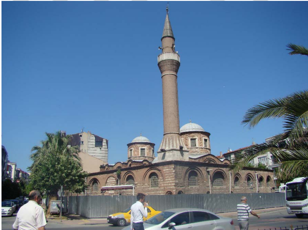
Şekil 4.117 : Fenari İsa Camii (Lips Manastırı Kilisesi)'nin kuzeybatı ve güneybatı cephesi (2013).
