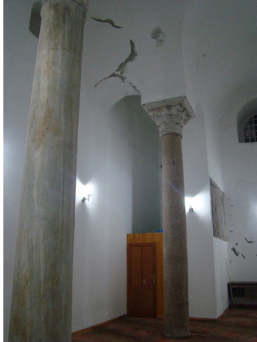
Şekil 4.85 : Bodrum Camii (Mirelaion Manastırı Kilisesi)’nin bodrum katındaki sütunlar (2015).
