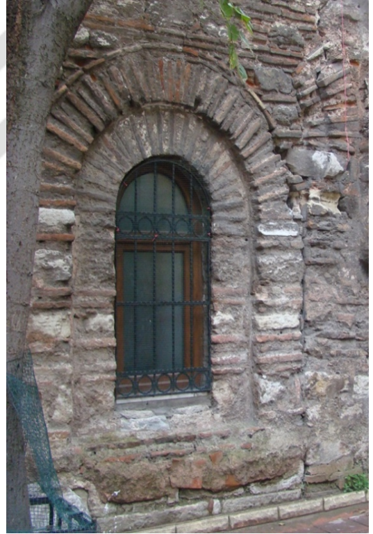
Şekil 4.95 : Eski İmaret Camii (Pantepoptes Manastırı Kilisesi)'nin batı cephesindeki alt pencere (2015).
