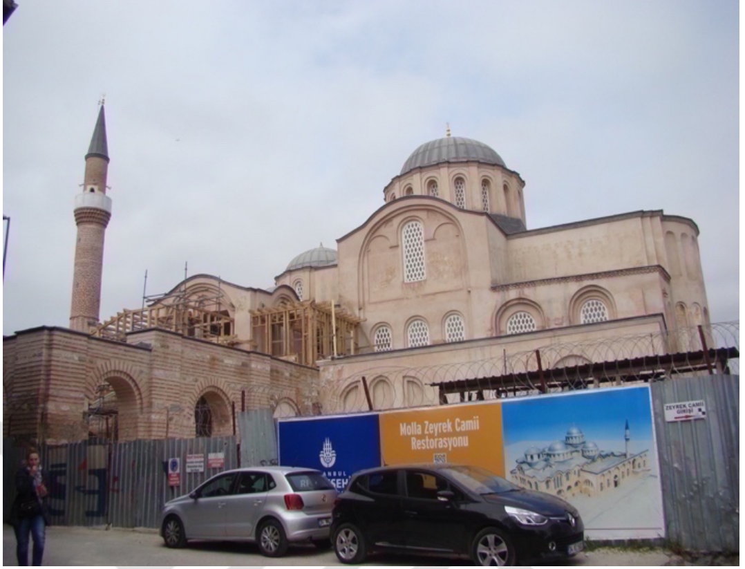
Şekil A.165 : Zeyrek Kilise Camii (Pantakrotor Manastırı Kilisesi)'nin güney cephesi (2016).
