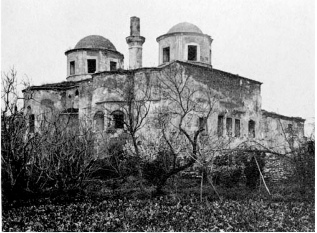
Şekil 4.125 : Fenari İsa Camii (Lips Manastırı Kilisesi)'nin güneydoğu cephesi (Porter, 1925).
