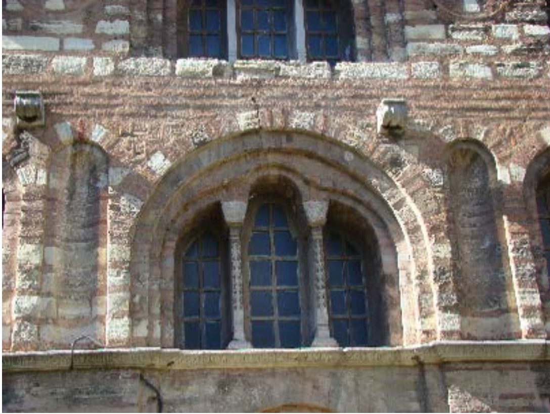
Şekil A.49 : Fethiye Camii ve Müzesi (Pammakaristu Manastırı Kilisesi) Parekklesion'un güney cephesi pencere detayı (2013).
