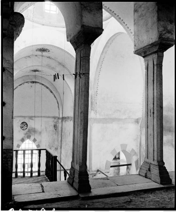
Şekil 4.106 : Eski İmaret Camii (Pantepoptes Manastırı Kilisesi)'nin galeri katından bakış (Artamonoff, Şubat 1937).
