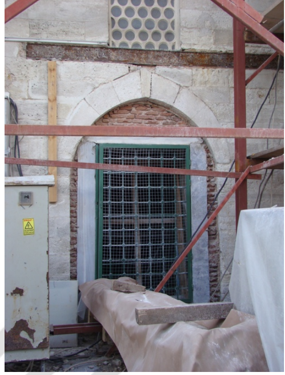
Şekil 4.331 : Koca Mustafa Paşa Camii (Ayias Andreas en te Krisei Manastırı Kilisesi)'nin güneydoğu cephesi pencere detayı (2016).
