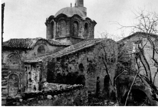
Şekil 4.437 : Vefa Kilise Camii'nin kuzey cephesi (Porter, 1920)
