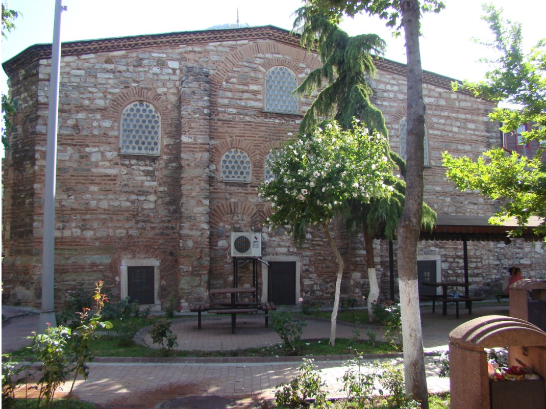
Şekil A.13 : Atik Mustafa Paşa Camii'nin kuzeydoğu cephesi (2013).
