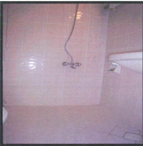
Şekil 3.4. Banyoda tutunma barı yokluğu ve kaygan zemin
