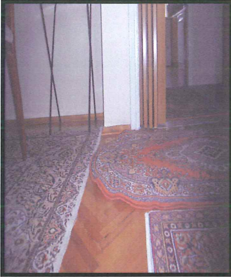
Şekil 3.3: Zeminde takılmaya yol açabilecek bükülü halı kenarları
