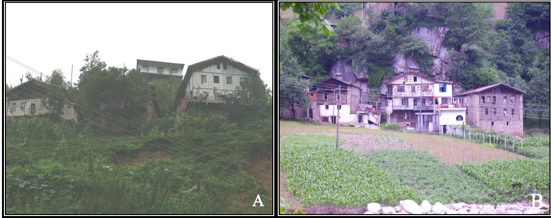
Fotoğraf 2.20. Ayvalık köyü (A) ve Dereköy’de (B) çakatura dolma tarzda inşa edilmiş köy meskenleri.
