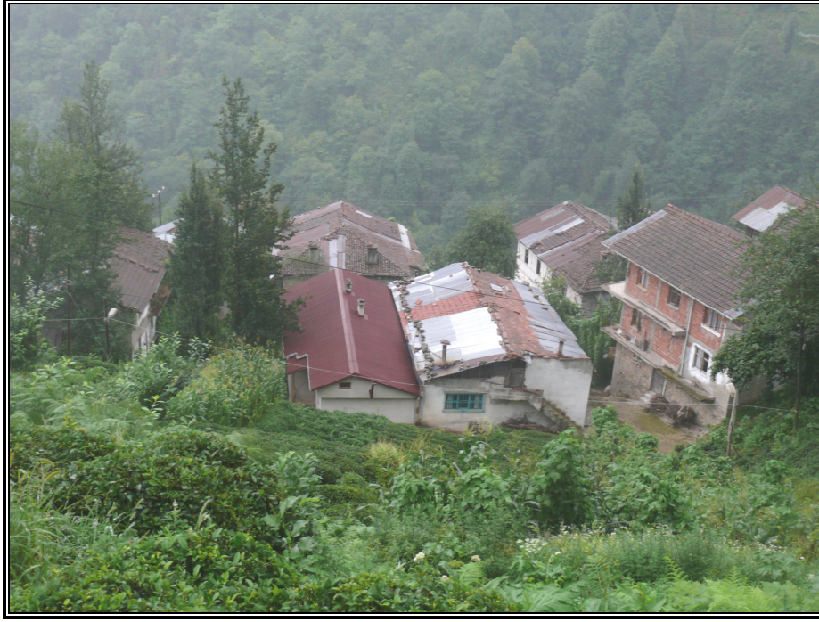
Fotoğraf 2.21. Köy meskenlerinde çatı örtü malzemesi olarak kiremit ve sac-eternit en fazla tercih edilen örtü malzemeleridir.
