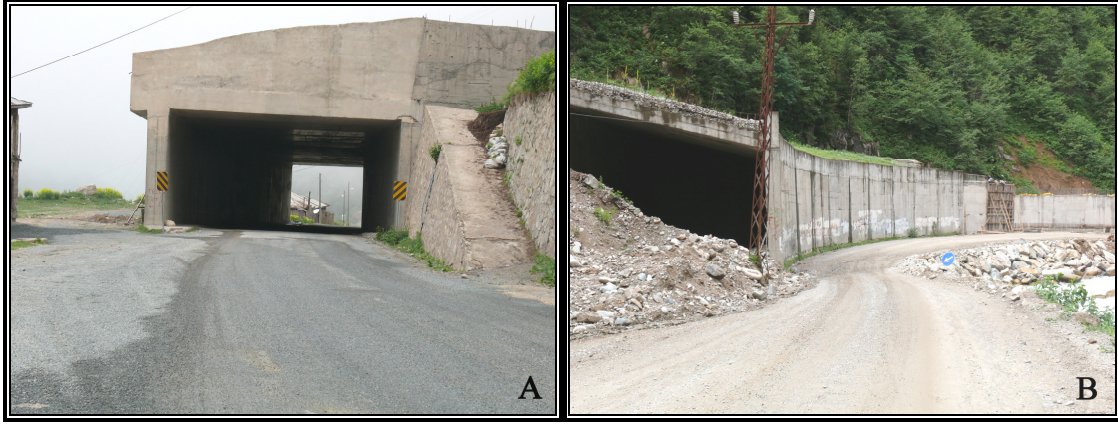
Fotoğraf 3.24. Bazıları tamamlanan çığ (kar) tünellerinin yapımına devam edilmektedir (Fotoğraflar, D-925 Karayolunun Sivrikaya köyü (A) ve Çamlık mevkiindeki (B) tünelleri göstermektedir).
