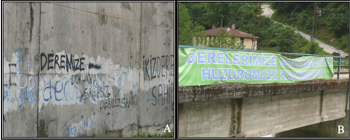
Fotoğraf 3.20. Yapımı devam eden bir çığ tüneli (A) ile köprü (B) üzerinde, ilçede plânlanan HES'lere yönelik protesto ifadeleri (2007 –Temmuz ayında çekilmiştir).
