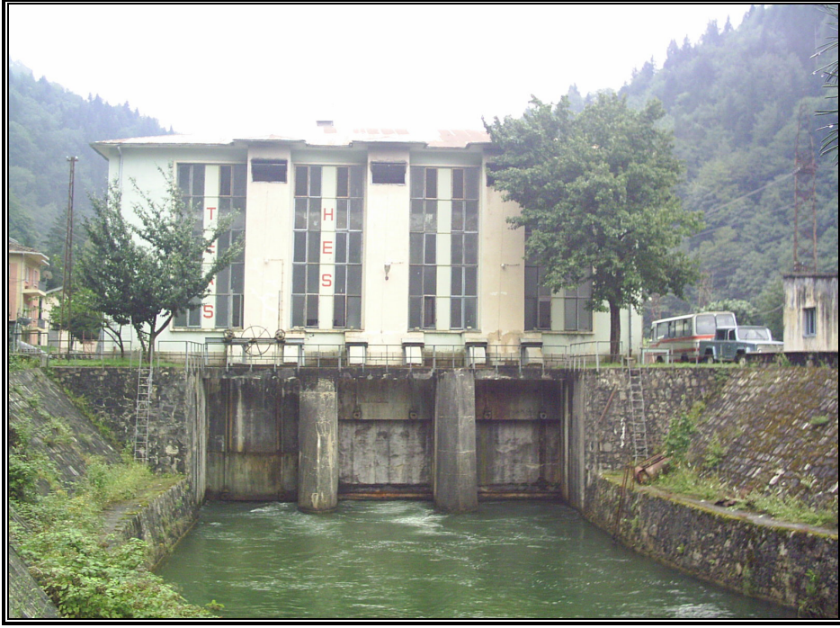
Fotoğraf 3.16. EÜAŞ İkizdere Hidroelektrik Santrali.
