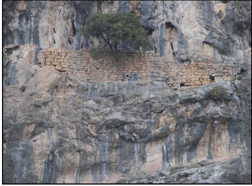
Şekil 2.37 Arykanda kanalın yarık yeri geçişi.
