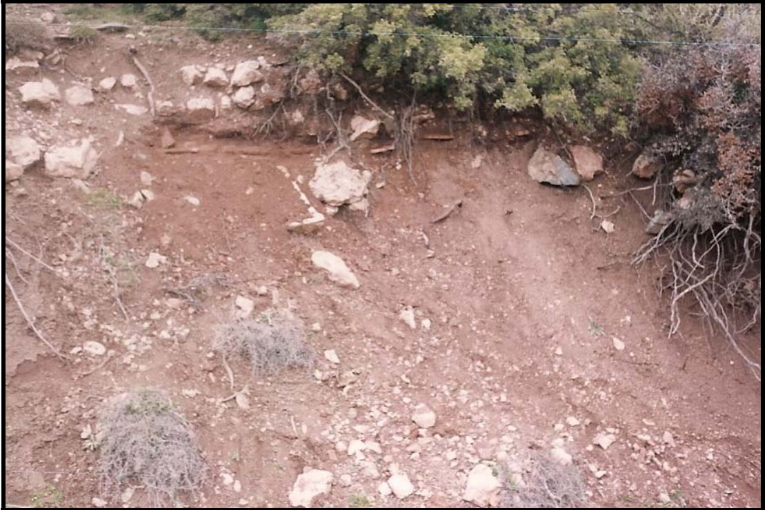
Şekil 2.94 Kibyra iletim hattındaki pişmiş toprak borular.
