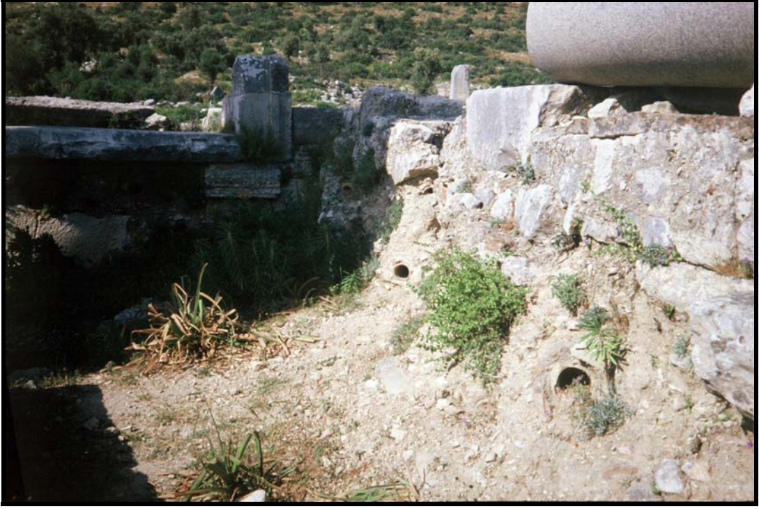
Şekil 2.151 Patara taşa oyulmuş borular.
