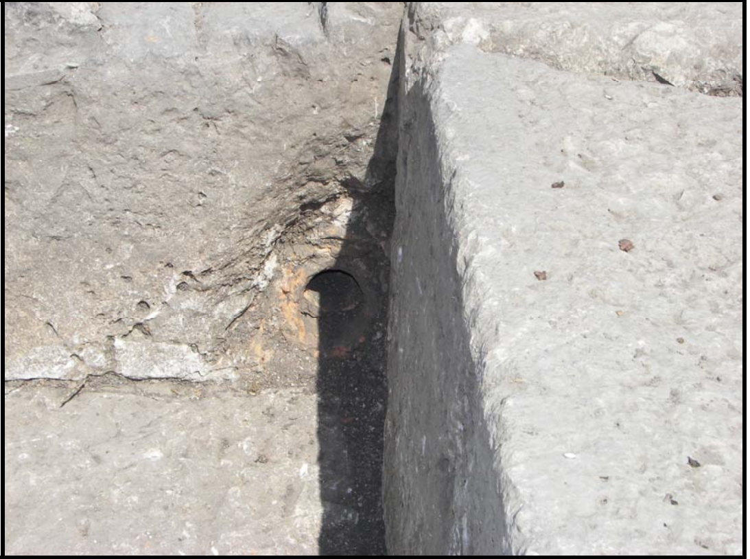
Şekil 2.244 Tlawa/Tlos stadion yanındaki ss havuzuna su getiren pişmiş toprak boru.
