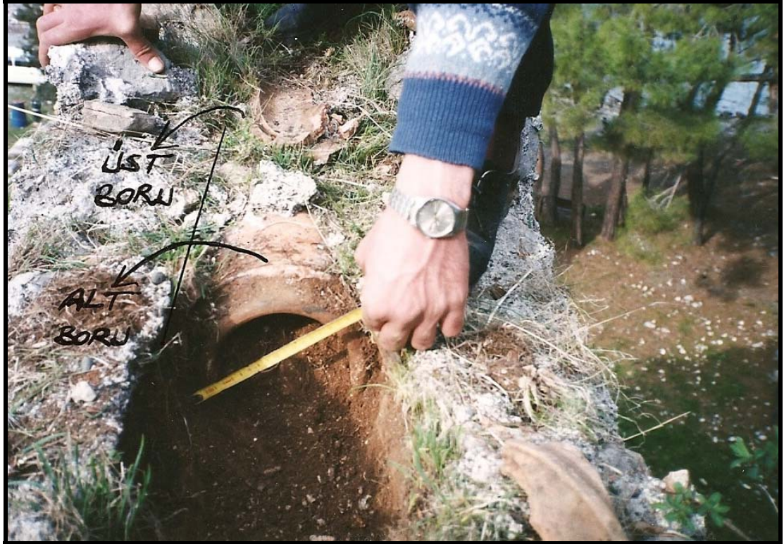
Şekil 2.179 Phaselis su kemeri üstündeki altlı üstlü pişmiş toprak borular.
