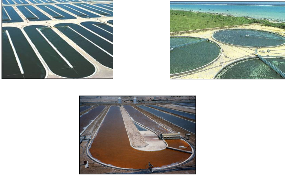
Şekil 2.11. Raceway ve sirküler havuzlarında (Ark şeklinde 100 m boyunda 1-10 m genişliğinde, 1/2-1 1/2 m derinliğinde olup içerisinden bol miktarda su akan ve yetiştiricilikte kullanılan beton ya da diğer malzemeden yapılmış havuza denmektedir.) Chlorella , Arthrospira , Dunaliella ve Haematococcus mikroalglerin ticari üretimi. (Tredici, 2007)
