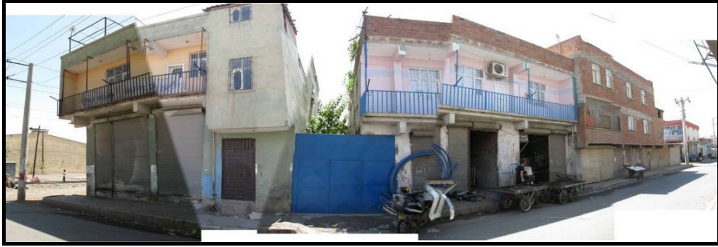
Resim 4.10. 2.adanın kuzeybatısından bir görünüm [Özen, 2007]
