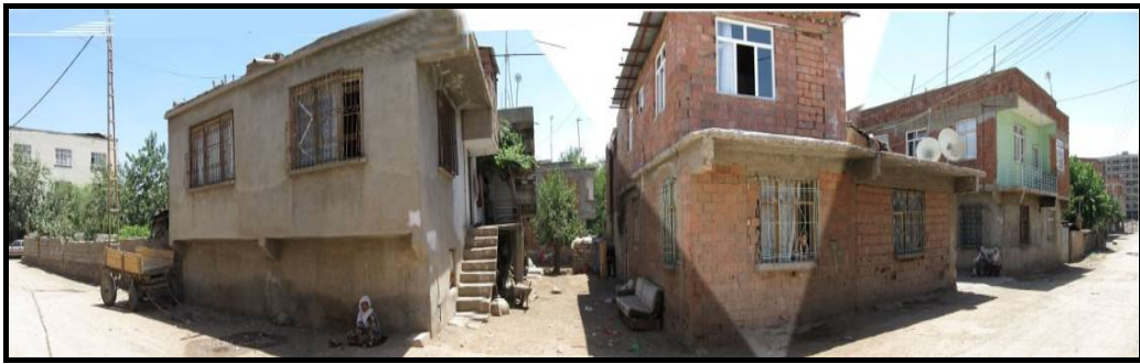
Resim 4.26. 4.adanın kuzeybatısından bir görünüm [Özen, 2007]
