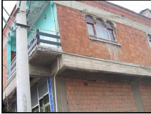
Resim 5.4. Dış duvarlarda tuğla kullanımı [ Özen, 2007]
