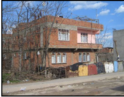
Resim:5.7. Bahçe duvarının yapımında kullanılan malzemeler [Özen, N., 2007]
