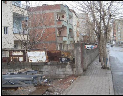
Resim 5.9. Bahçe duvarında karışık malzeme kullanımı [Özen, N., 2007]
