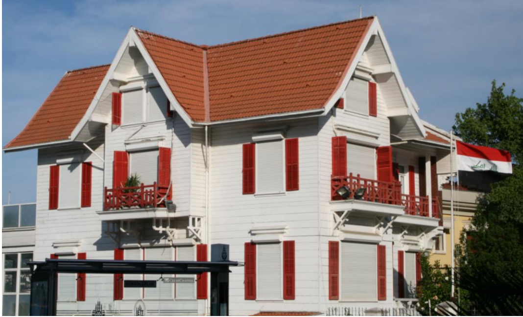
Şekil 3.15 : Damatyan Yalısı kuzeybatı cephesi.
