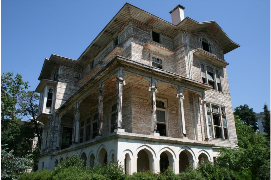
Şekil 3.35 : Cemil Topuzlu Köşkü güney cephesi.
