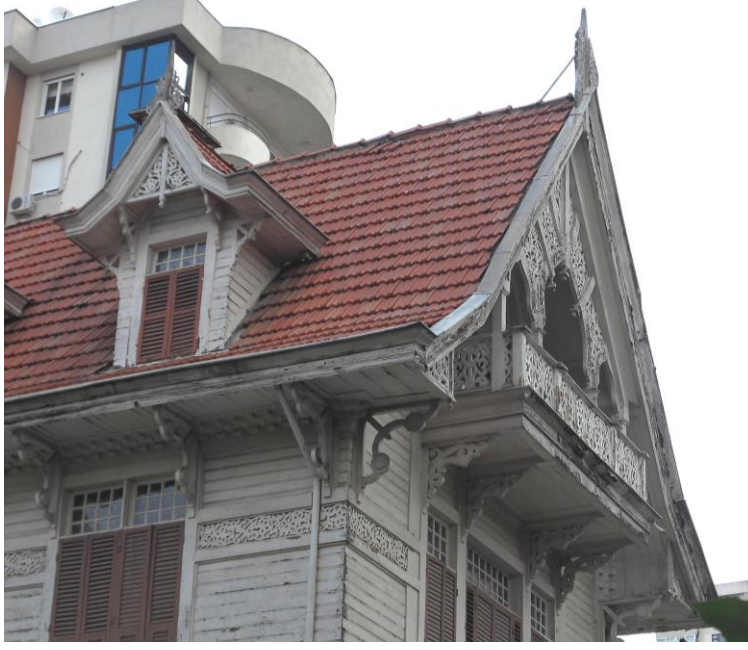
Şekil 3.20 : Arif Hikmet Paşa Köşkü Çatı Görünüşü.
