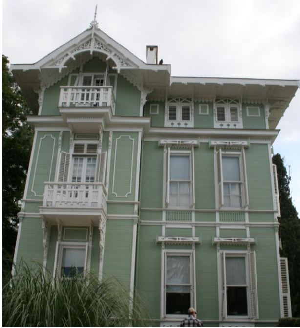
Şekil 3.31 : Tahsin Paşa Köşkü güneybatı cephesi.
