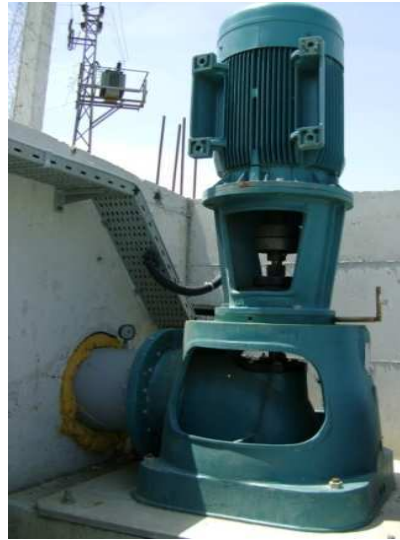
Resim 3.5 Pompa-Motor Birimi
