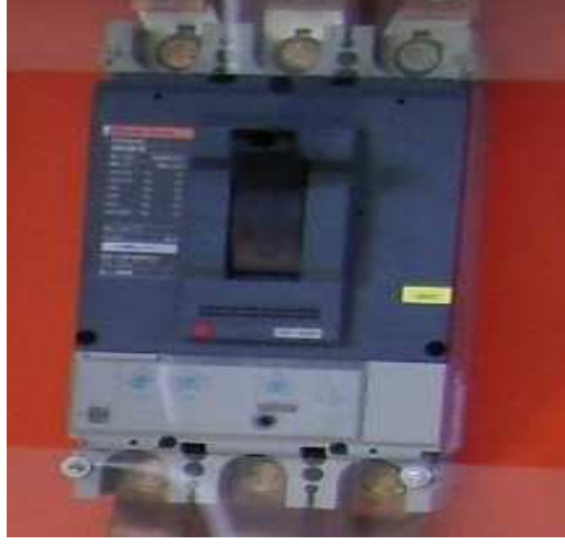
Resim 3.7 3x250 A Termik Manyetik Şalter
