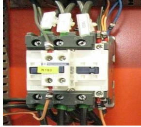
Resim 3.16. 3x63 A Motor Kontaktörü
