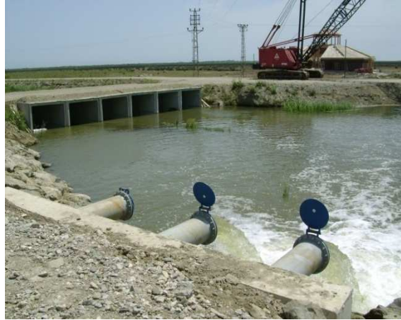
Resim 3.2. Ana Kanal ve Kanala Su Aktarımı
