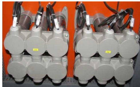
Resim 3.22. 20 kVAr Güç Kondansatörleri
