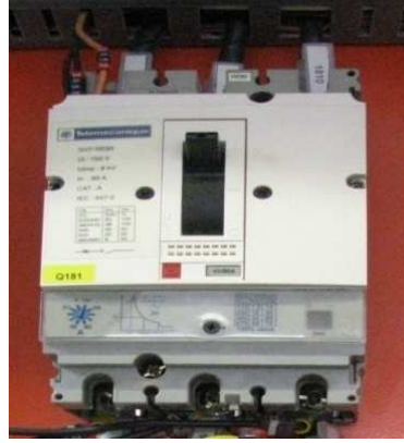
Resim 3.10 3x80 A Termik Manyetik Motor Koruma Şalteri
