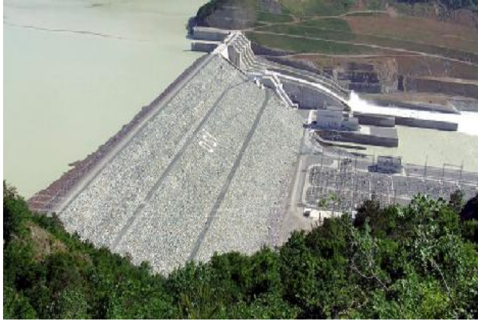
Şekil 1.5. Borçka Barajı ( www.yukselinsaat.com.tr ).
