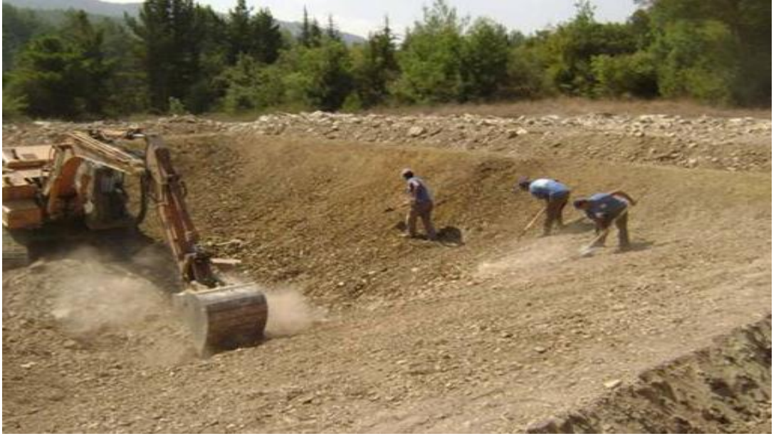
Şekil 4.13. Havuzun kazılması ( www.jettihavuz.com )
