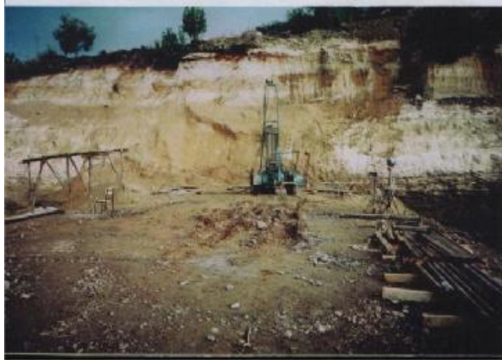
Şekil 4.9. Gövde üzerinde yapılan bir sondaj
