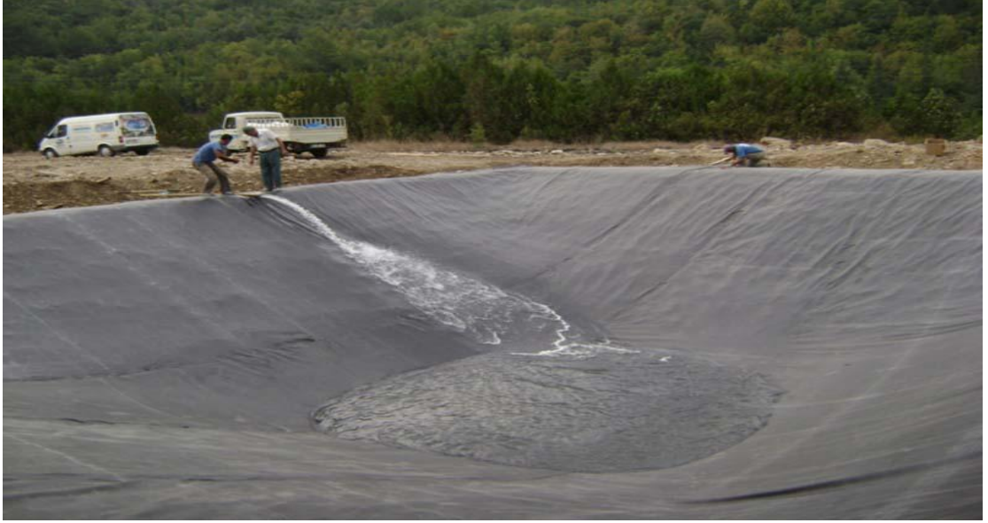
Şekil 4.17. Havuz içine su doldurulması ( www.jettihavuz.com )
