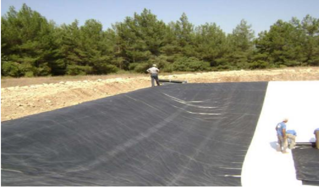
Şekil 4.15. Jeomembran malzemesinin serilmesi ( www.jettihavuz.com )
