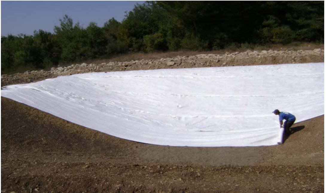
Şekil 4.14. Geçirimsiz malzemenin serilmesi ( www.jettihavuz.com )
