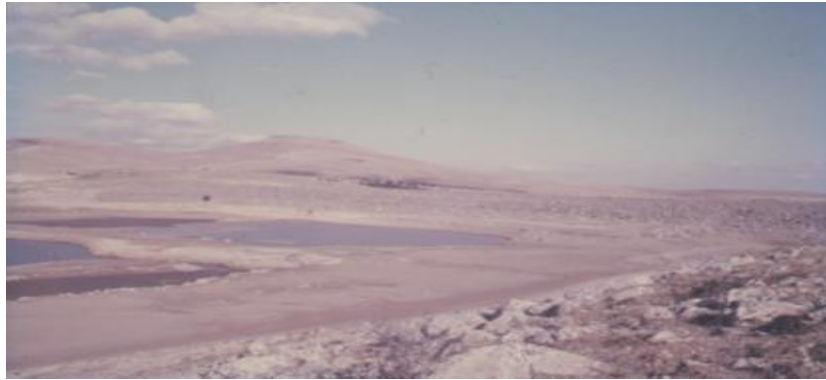
Şekil 1.7. May Barajı'nın su tutmayan rezervuarı (Ertunç, 2003).
