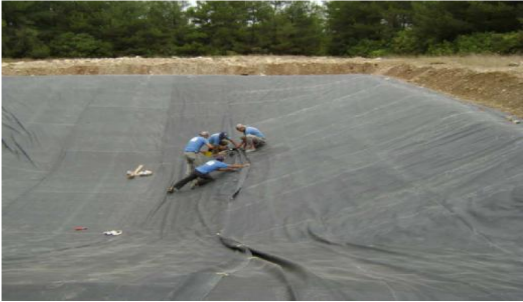
Şekil 4.16. Jeomembran kaplamasının son aşaması ( www.jettihavuz.com )
