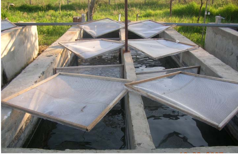
Resim 3.3. Deneysel Havuzların Genel Görünüşü.
