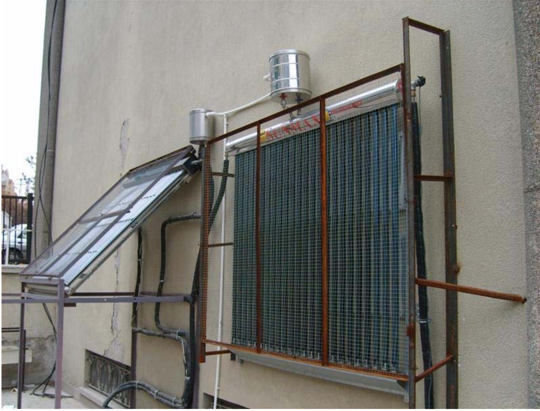
Resim 8.1. Eğimli ve dik olarak yerleştirilmiş vakum borulu kolektörler
