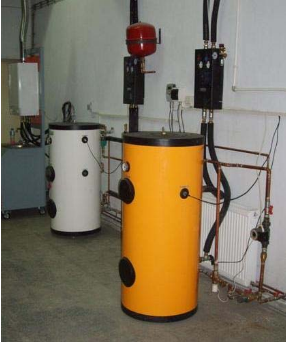
Resim 8.2. Sistemdeki mevcut iki adet boyler kazanı
