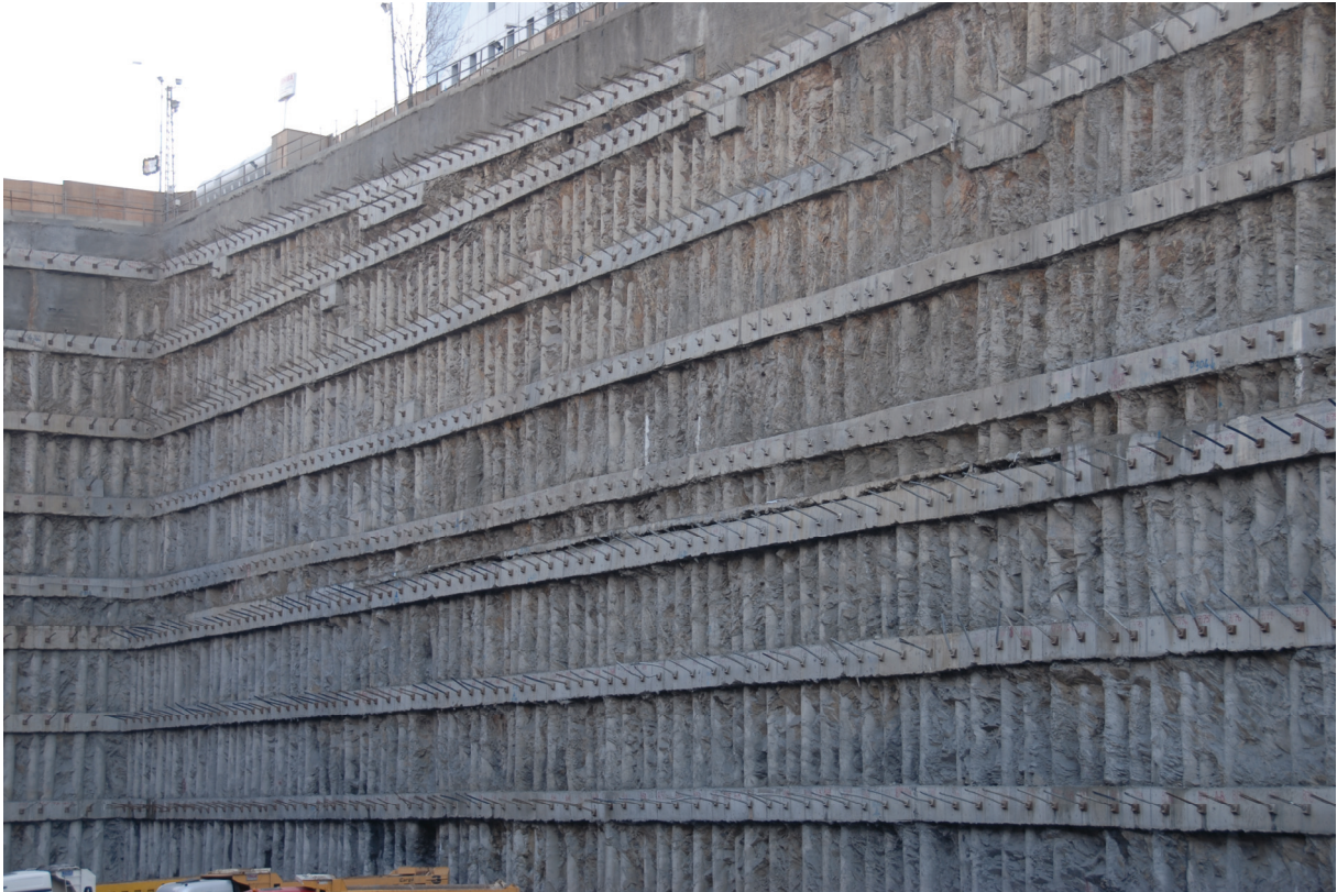
Şekil 2.13 İstanbul’da ankrajlı perde ile desteklenen H = 42.0m derinlikte kazı çukuru (Taşyapı, 2007)
