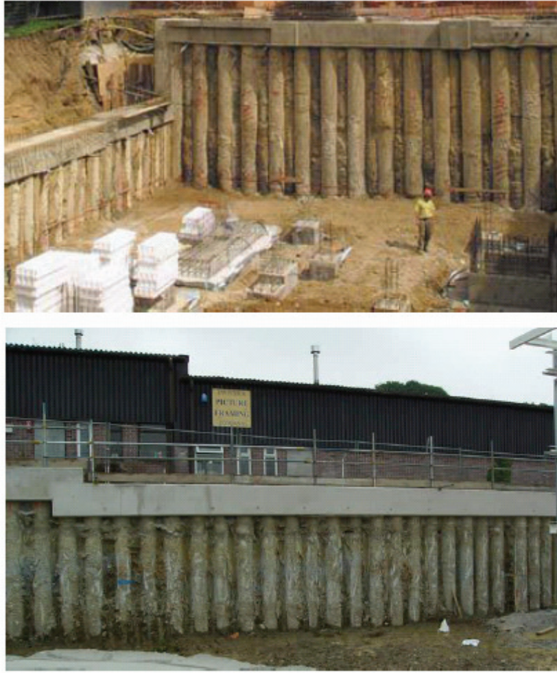
Şekil 2.11 Konsol fore kazıklardan teşkil edilmiş iksa sistemleri
