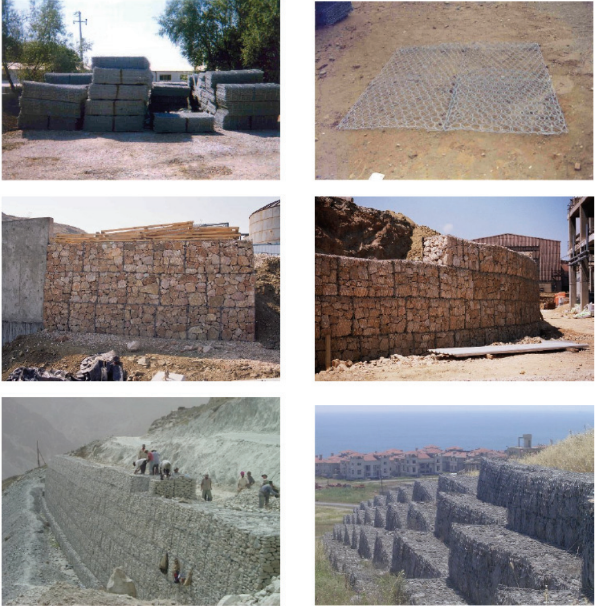
Şekil 2.6 Gabyon duvarlara ait malzeme ve duvar tiplerine ilişkin farklı fotoğraflar (Phi Yapı, 2006)
