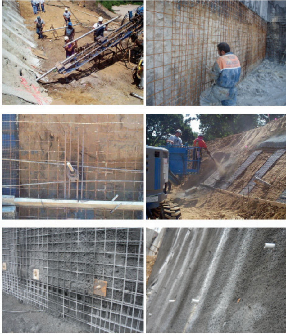
Şekil 2.9 Zemin çivili duvar imalatının değişik aşamalarına ait fotoğraflar
