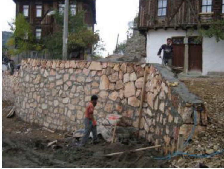
Şekil 2.4 Taş duvar yapımı
