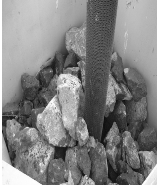
Şekil 1.8 Çakıl doldurulmuş gaz alma bacası (Yoshida, 2006)
