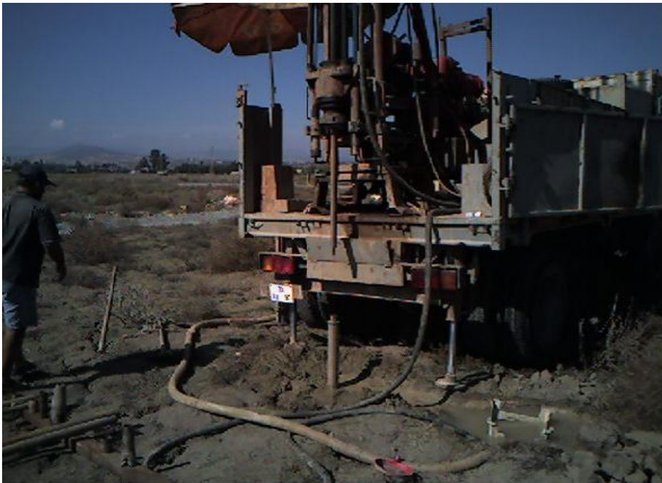
Şekil 3.4b. Sondaj çalışmasından bir görünüm
