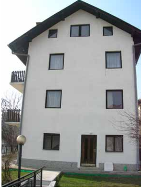
Fotoğraf 50: Alan araştırmasının ilk bir buçuk ayında ikamet edilen Podhrastovi Mahallesi'ndeki ev. (Kalınan ev görülen binanın zemin katıdır.) (19 Şubat 2007, Özgür Dirim Özkan)
