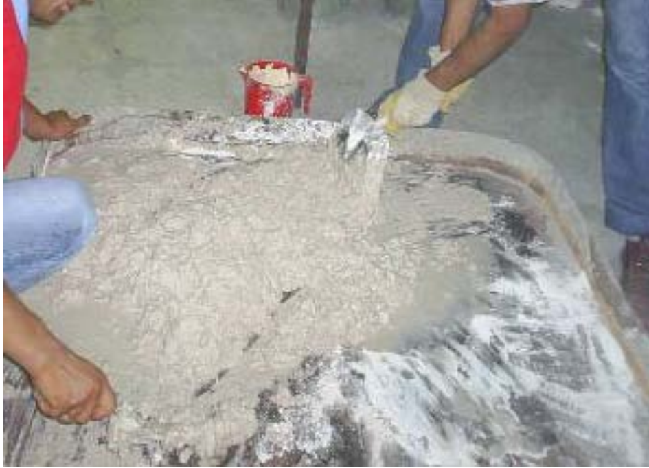
Şekil 3.14. Diyatomit Harcı Karışımının Hazırlanması
