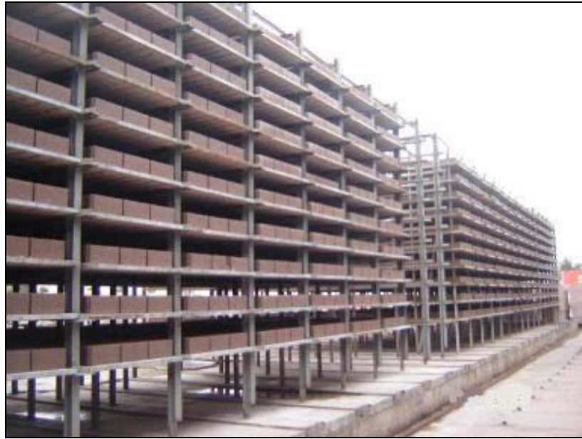
Şekil 3.13. Duvar Bloklarının Kamaralarda Kürü
