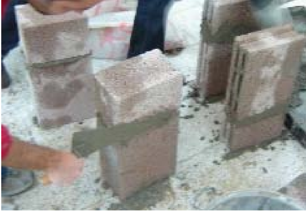
Şekil 3.20. Duvar Bloklarının Derzlerinin Oluşturulması
