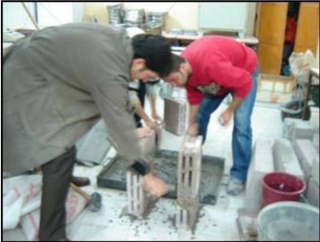
Şekil 3.21. Duvar Bloklarının 500x500xD mm Boyutlarında Örülmesi
