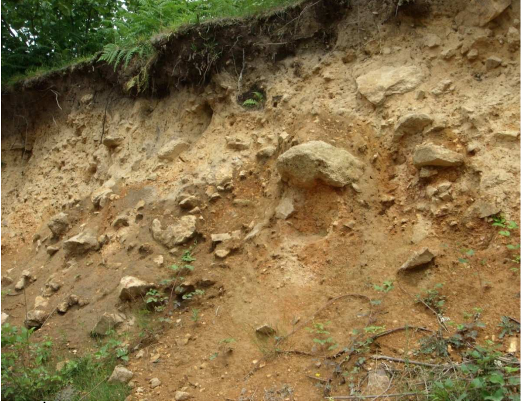
Şekil 4.6. İşletmenin ve atık barajlarının inşa edilmiş olduğu vadinin yamaçlarında gözlenen yamaç molozundan bir görünüm.
