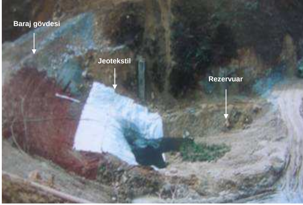
Şekil 3.5. Alt kottaki ikinci atık barajının inşası sırasında filtre malzemesinin üzerine jeotekstil serilmesi (Lahanos işletmesinden temin edilmiştir).
