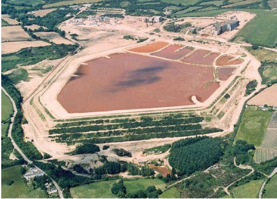
Şekil 2.8. Clemows (İngiltere) atık barajı (parçalara ayrılmış akış yukarı basamaklı halka-dayk tipi) (www.cantabkent.co.uk, 2008).
