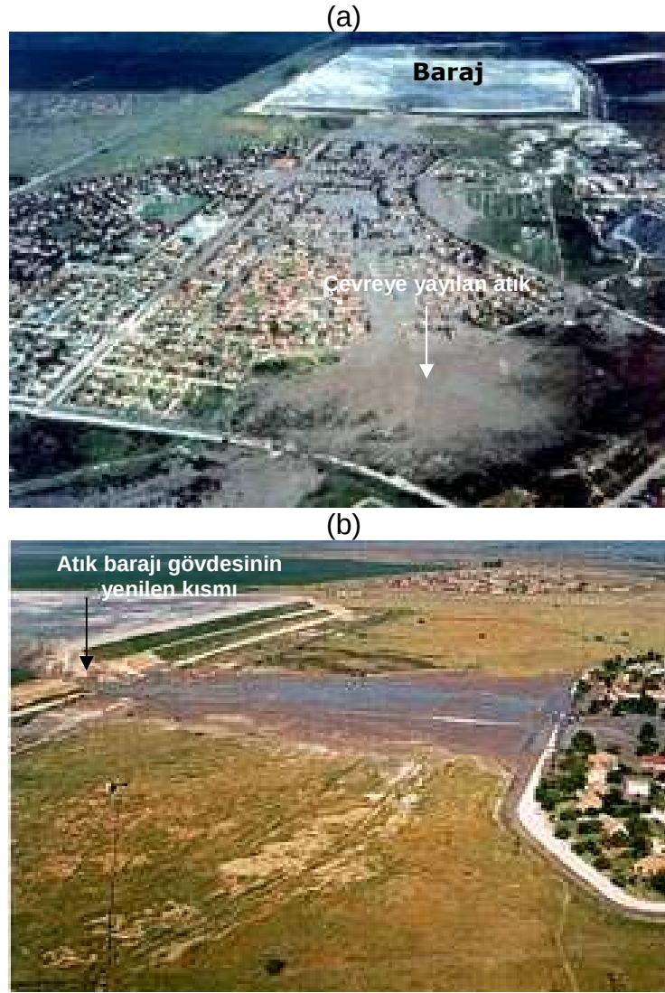
Şekil 2.21. Merriespruit (Virginia, Güney Afrika) atık barajının üstten aşma nedeniyle duraysızlığa uğradıktan sonra (a) karşıdan ve (b) yandan görünümü (www.tailings.info, 2009).
