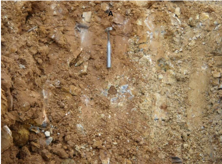
Şekil 3.4. Alt kottaki atık barajının gövde dolgusundan bir görünüm.
