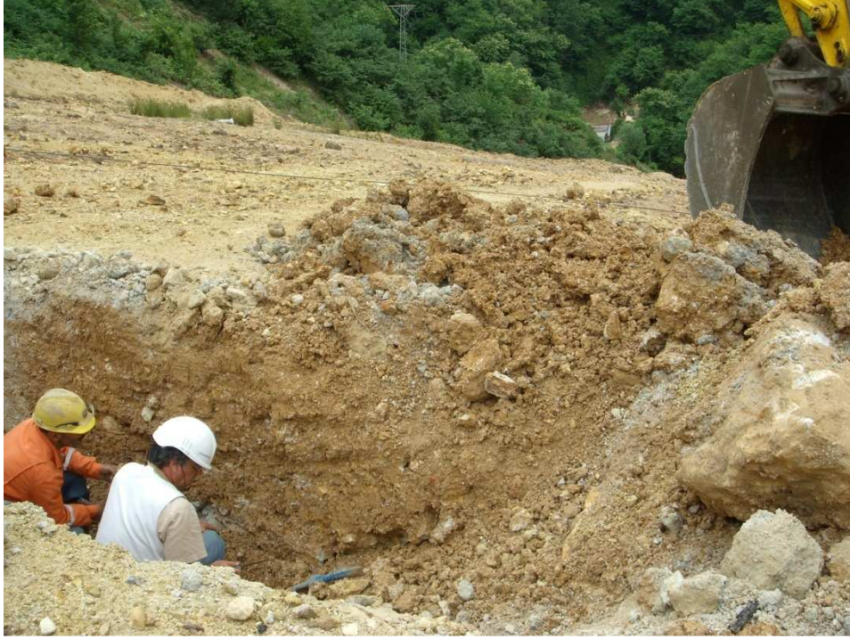
Şekil 5.2. Açılan araştırma çukurlarından birinin ve baraj gövde malzemesinin görünümü.
