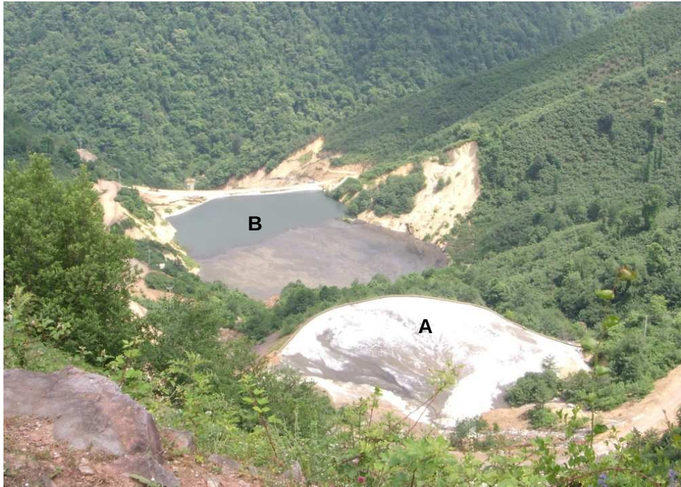
Şekil 3.3. Lahanos işletmesindeki atık barajlarının genel bir görüntüsü: (A) dolan eski atık barajı ve (B) bu çalışmada incelenen atık barajı.
