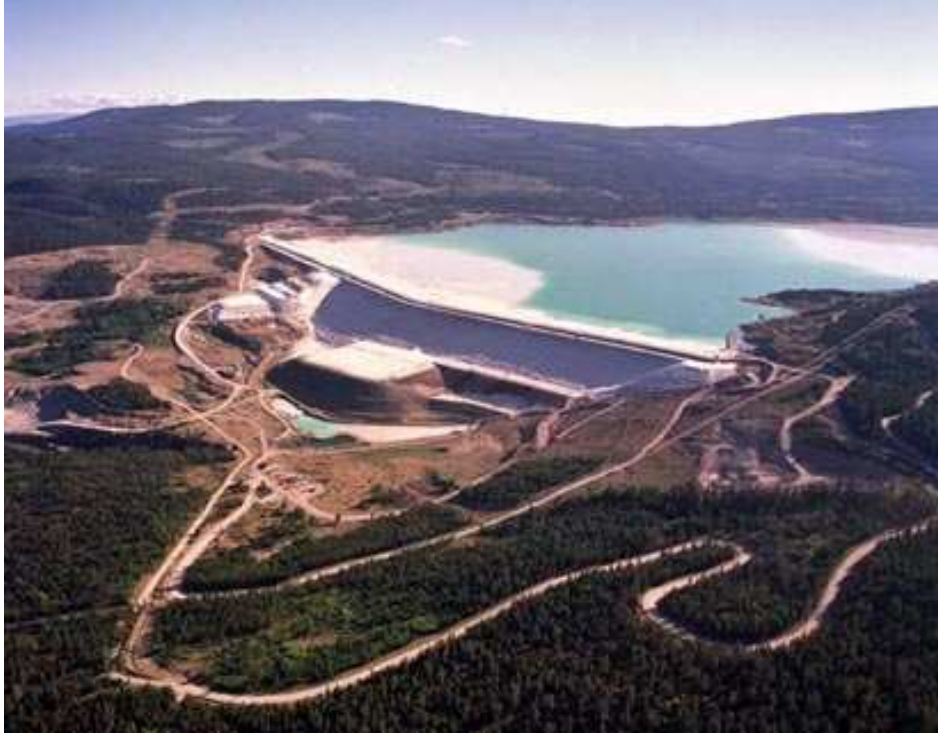
Şekil 2.3. Highland (Kanada) bakır madenine ait vadi tipi atık barajı (www.tailings.info, 2009).
