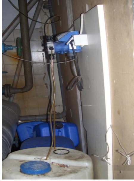
Şekil 8.7 Capitol AVM'deki otomatik dozaj sistemi
