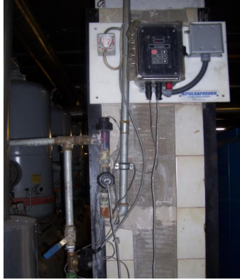
Şekil 8.5 Capitol AVM'deki otomatik blöf sistemi
