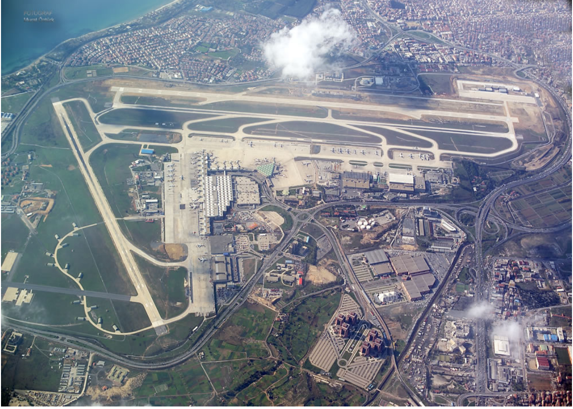
Şekil 2.1. İstanbul Atatürk Havalimanı hava fotoğrafı [3].
