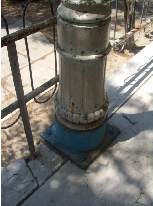
Şekil 6.85 Suphi Koyuncuoğlu Lisesi iş ve teknik atölyesi , (a) dairesel kolonların taban levhası ile zemine birleştirilmesi (b) çelik kolonların üzerindeki guse elemanlarla birleştirilen I profiller.
