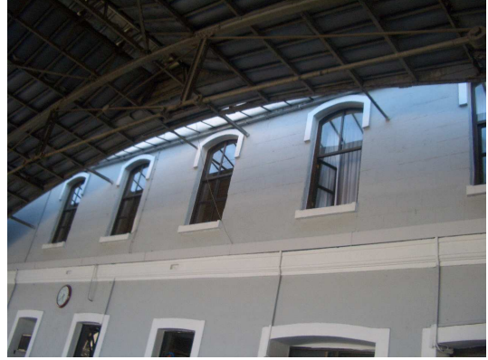
Şekil 6.81 Basmane Garı, (a) yapının peron kısmının üzerini örten üst örtü taşıyıcılarının görünüşü (b) çatı makaslarının yığma duvara gömülmesi.
