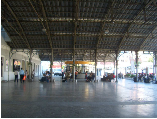
Şekil 6.81 Basmane Garı, (a) yapının peron kısmının üzerini örten üst örtü taşıyıcılarının görünüşü (b) çatı makaslarının yığma duvara gömülmesi.
