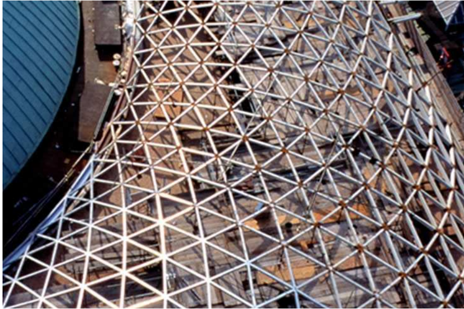
Şekil 6.46 İngiltere Müzesi Büyük Avlusu çelik ve cam çatı strüktürünün oluşturulması 2.
