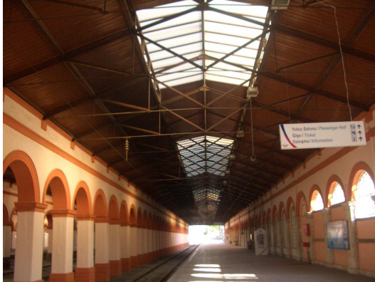
Şekil 3.15(a) Alsancak Garının içinden sıra kemerli (arkat) duvarlara oturan pratt tipi çatı makaslarının görünüşü. (b) Basmane Garının açık bekleme salonundaki dökme demir kolonlar, çelik kemerler ve çatı makaslarının birleşimleri.
