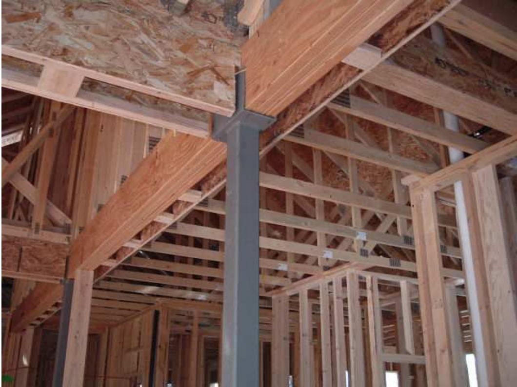
Şekil 6.33 Çelik kolonlara u eleman ile birleştirilmiş tutkallı tabakalı ahşap kiriş elemanı.
