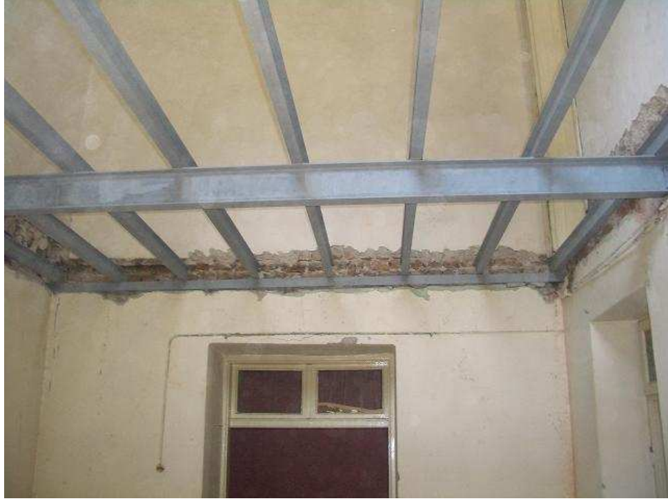
Şekil 6.22 Yığma yapı duvarlarına çelik döşeme kirişleri eklenmesi, Bornova, İzmir.
