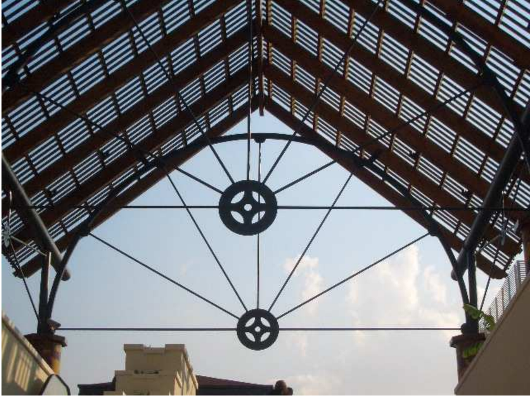
Şekil 6.32 Çelik çatı kirişlerine bulonlanmış ahşap aşık, mertek ve güneş kırıcılar, Forum Bornova, İzmir.
