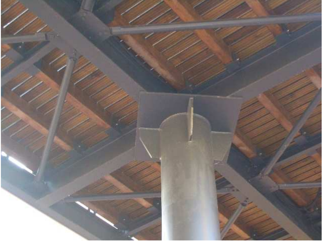
Şekil 6.31 Çelik kirişlere birleştirme elemanı ile bulonlanmış ahşap döşeme kirişleri ve ahşap döşeme kaplaması, Forum Bornova, İzmir.
