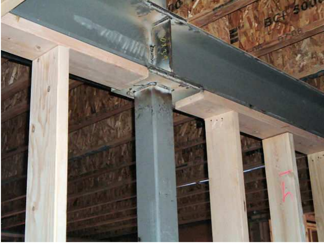
Şekil 6.34 Çelik kolon ve kirişlere çeşitli şekillerde birleştirilmiş ahşap elemanlar.
