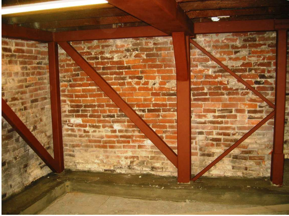
Şekil 6.20 Yığma yapı içerisinde oluşturulan çelik konstrüksiyon.
