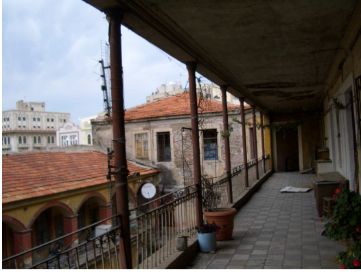
Şekil 6.78 Çukur Han, (a) 10 cm çaplı dairesel dökme demir kolonlar (b) yapı içindeki çelik ile kagir malzemeli volta döşemeler
