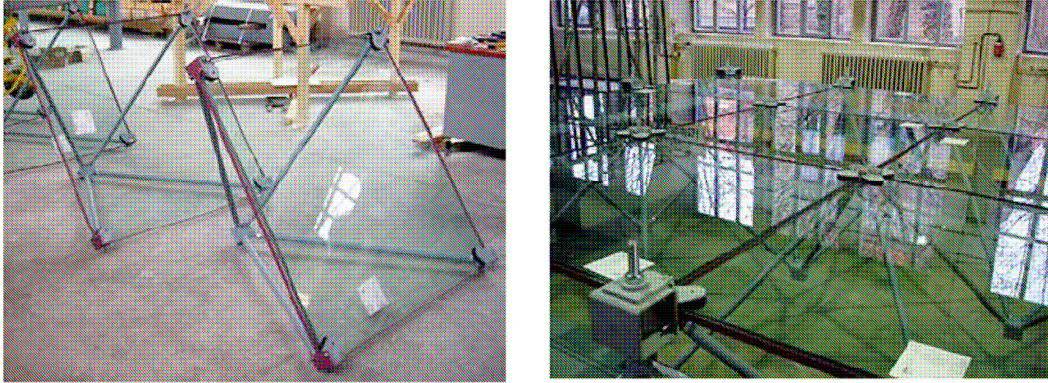
Şekil 6.39 Transparan uzay kafes modüller ve modüllerin birleştirilmesi.
