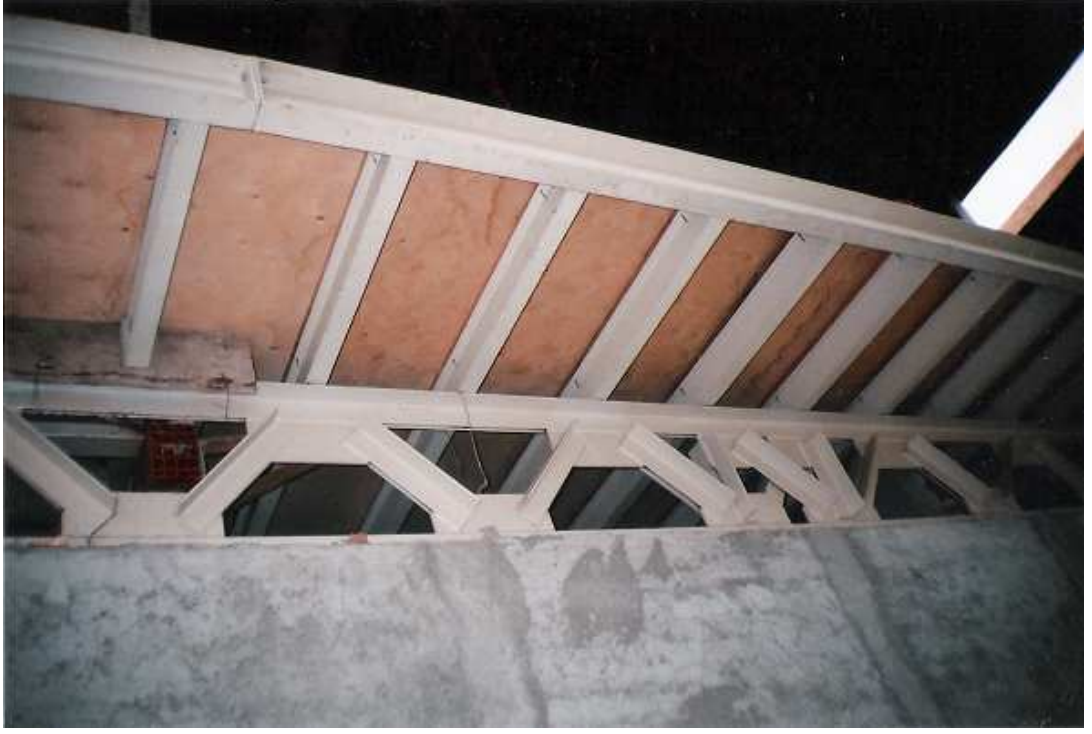
Şekil 6.30 Çelik kafes kiriş üzerinde I profil döşeme kirişleri ve OSB plak döşeme kaplaması, merinos dönüşüm projesi yapısı, Bursa.
