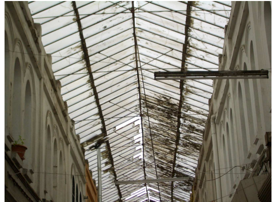
Şekil 6.79 Kavaflar Çarşısı, (a) yapının Fevzi Paşa Bulvarı üzerinden görünüşü (b) yapının makaslarla taşınan çelik ve cam malzemeli ışıklığı.
