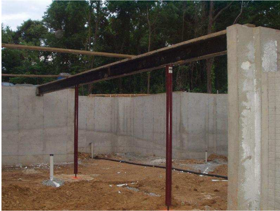
Şekil 6.15 Betonarme perde duvar çelik kiriş birleşimi.
