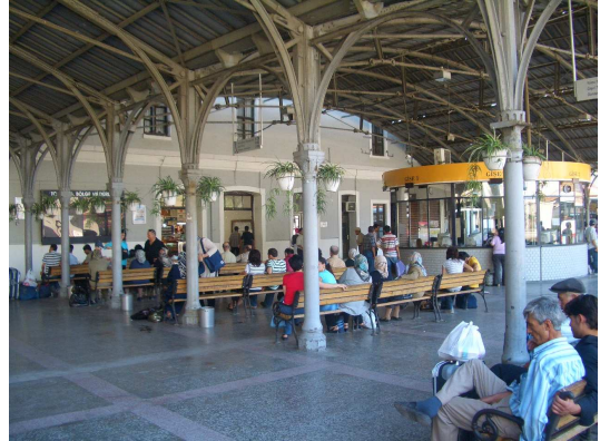
Şekil 3.15(a) Alsancak Garının içinden sıra kemerli (arkat) duvarlara oturan pratt tipi çatı makaslarının görünüşü. (b) Basmane Garının açık bekleme salonundaki dökme demir kolonlar, çelik kemerler ve çatı makaslarının birleşimleri.
