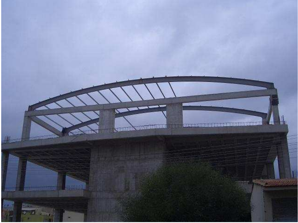
Şekil 6.14 Çamdibi katlı pazaryeri inşaatında çelik çatının betonarme yapıya birleşimi, İzmir.
