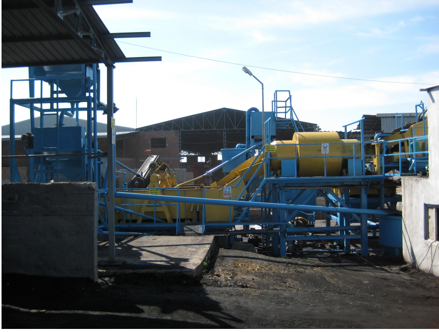
Şekil 5.3. Kömür Zenginleştirme Tesisi
