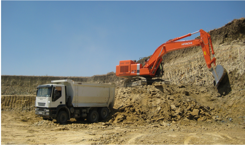
Şekil 5.1. Ekskavatör + Kamyon Çalışması
