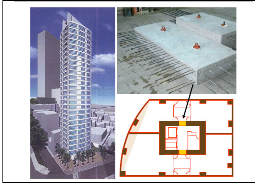
Şekil 2.15 Glorio Roppongi gökdeleninde kullanılan lifli mikro beton sönümleyiciler (Kunieda ve Rokugo, 2006).
