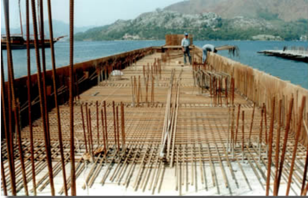
Şekil 4.2: İskele – Saha Betonu İnşası
