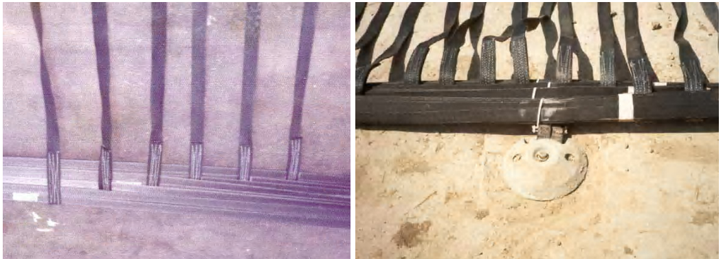
Şekil 2-7 Tekli Ağ Elemanları ve Gruplandırılarak Sabitlenen Bariyer Ağı
