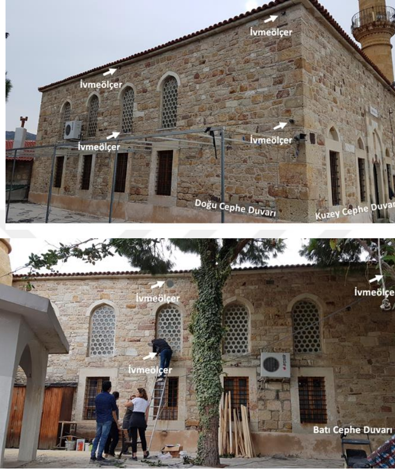
Şekil 4.6 Kayalar Camii cephe duvarları üzerine yerleştirilen ivmeölçerin konumu
