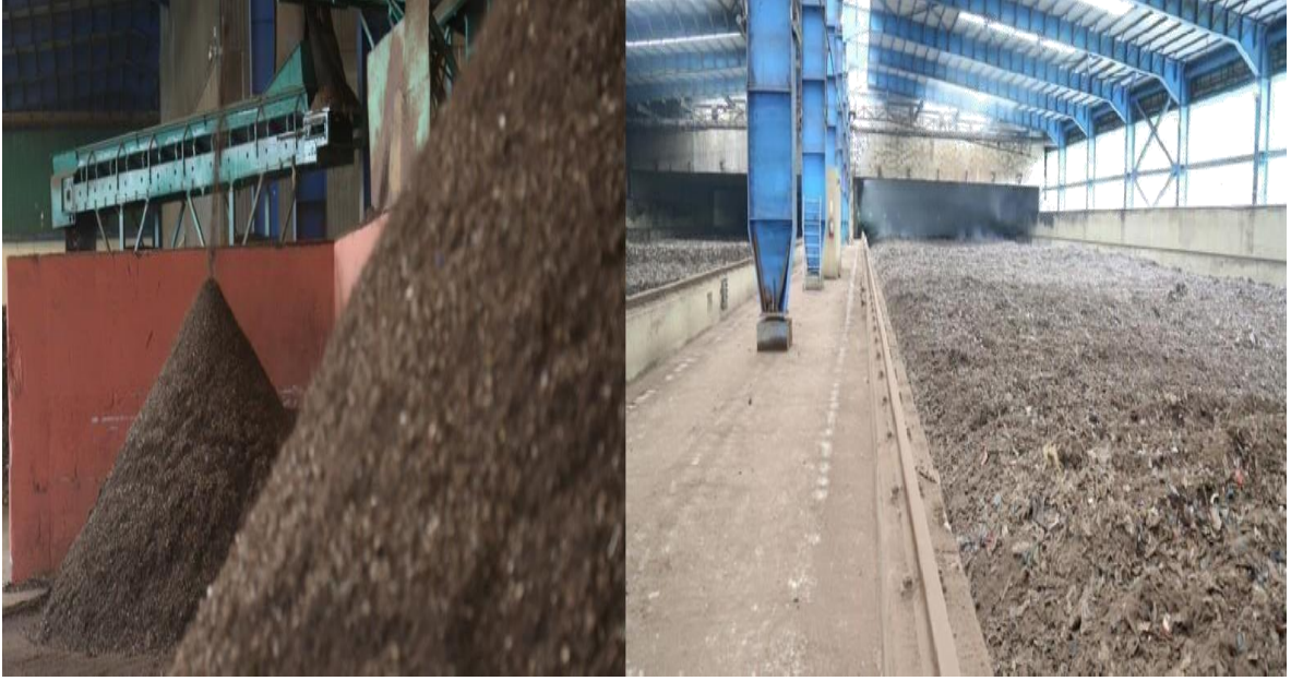
Resim 4.1. İstanbul (Kemerburgaz) Kompost Geri Dönüşüm Tesisi
