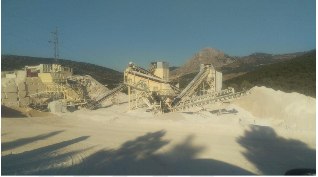
Şekil 4.69. Mermer üretimi sonrasında açığa çıkan etkisiz atıkların değerlendirilerek beton santraline gönderilmesi için kurulan tesisten (konkasör) bir görünüm (Bademli kuzeyi)
