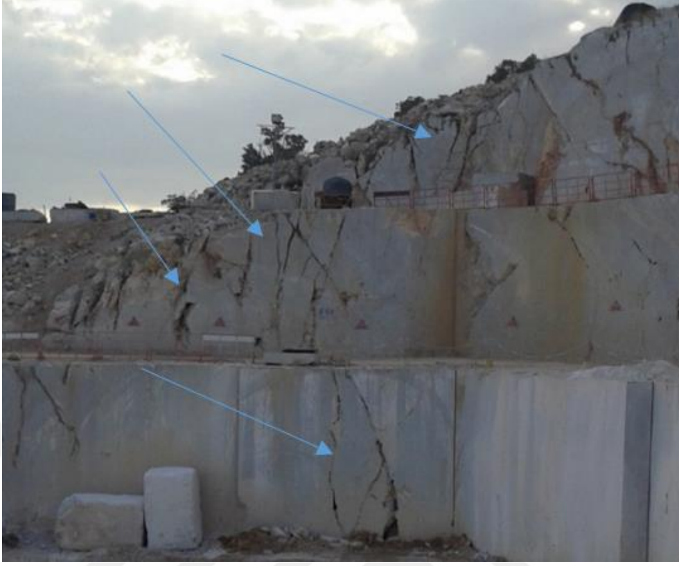
Şekil 4.49. Ocak kademelerinde görülen kırık ve çatlak sistemleri
