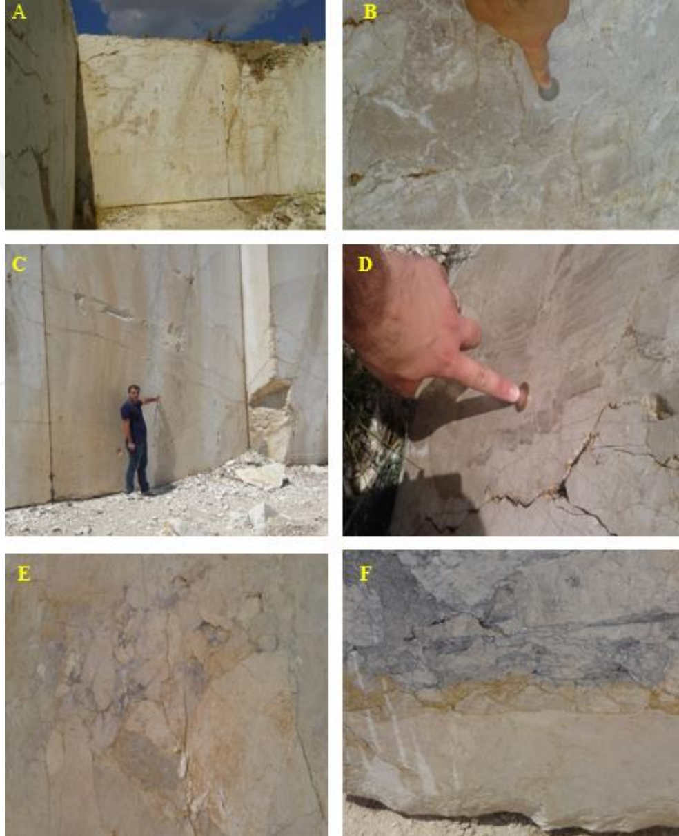
Şekil 4.31. Deliktaş formasyonunda yapılan ticari mermer üretiminde karşılaşılan olumsuzluklar (A: Ocak kademesinde homojen olmayan kireçtaşı dokusu/yapısı, B: Blok üzerinde yoğun ve dağınık haldeki dolomit girdileri, C: Ocak kademesinde görülen tektonik etkiler ve yoğun yabancı madde girdileri, D-E-F: Bloklarda görülen yabancı maddeler)
