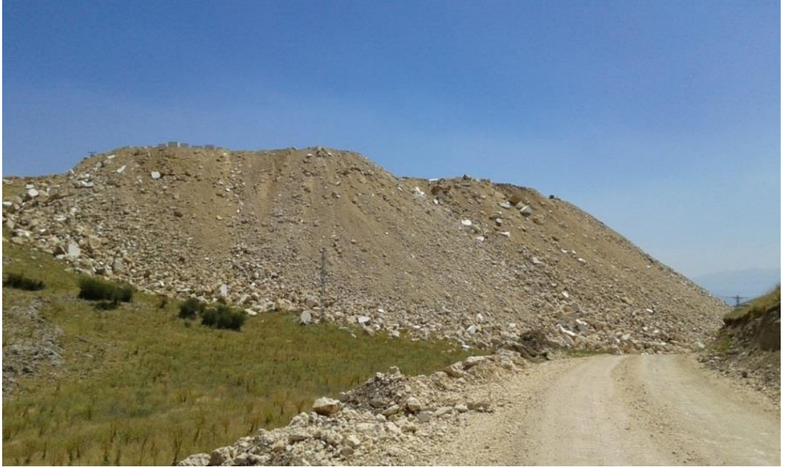
Şekil 4.64. Mermer atıkları ve pasaların tedbirler alınmadan ocak nakliye yoluna yakın depolanması nedeniyle işletme güvenliği (nakliye yolları) açısından risk oluşturan alandan yakın görünüm
