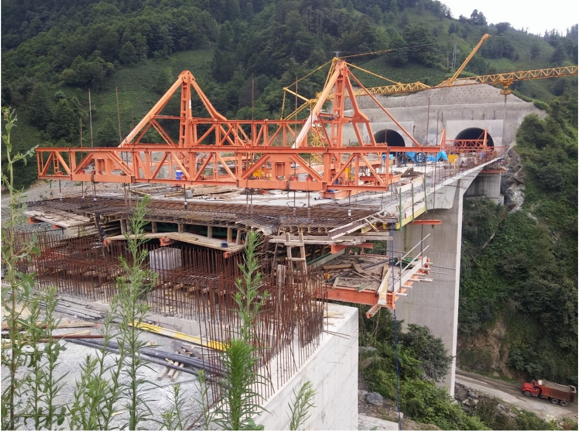
Şekil 1.26. Beton dökümüne ait dengeli konsol dilimi
