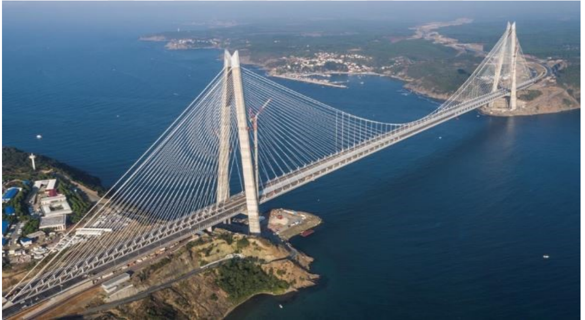
Şekil 1.11. Yavuz Sultan Selim köprüsü
