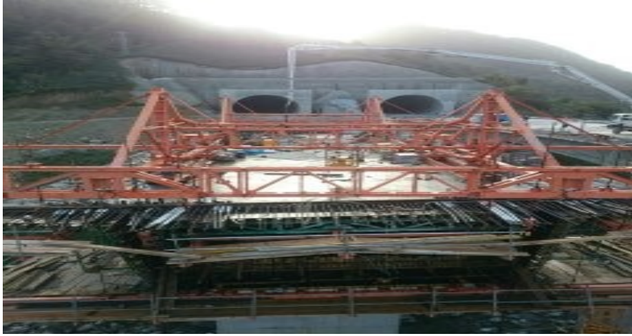
Şekil 1.24. Dengeli konsol köprü döküm arabası
