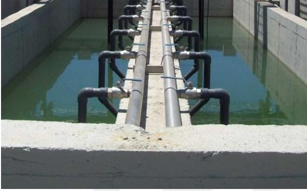
Şekil 1.2. Örnek bir yağ tutucu ünitesi
