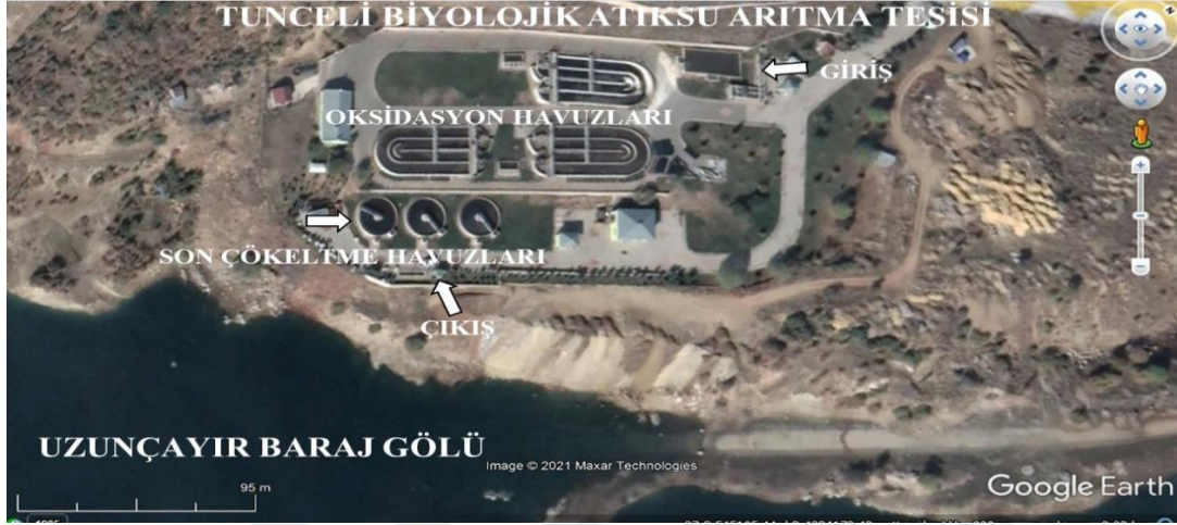
Şekil 2.1. Tunceli biyolojik atıksu arıtma tesisi
