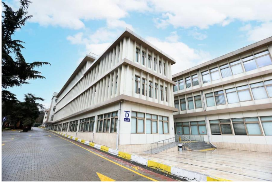
Şekil 3.19. Fsmvü Haliç Kampüsü derslik binası (URL-51).
