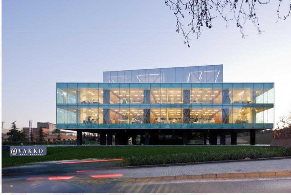
Şekil 4.18. Vakko Moda Merkezi cephe görünüşü (URL-75).
