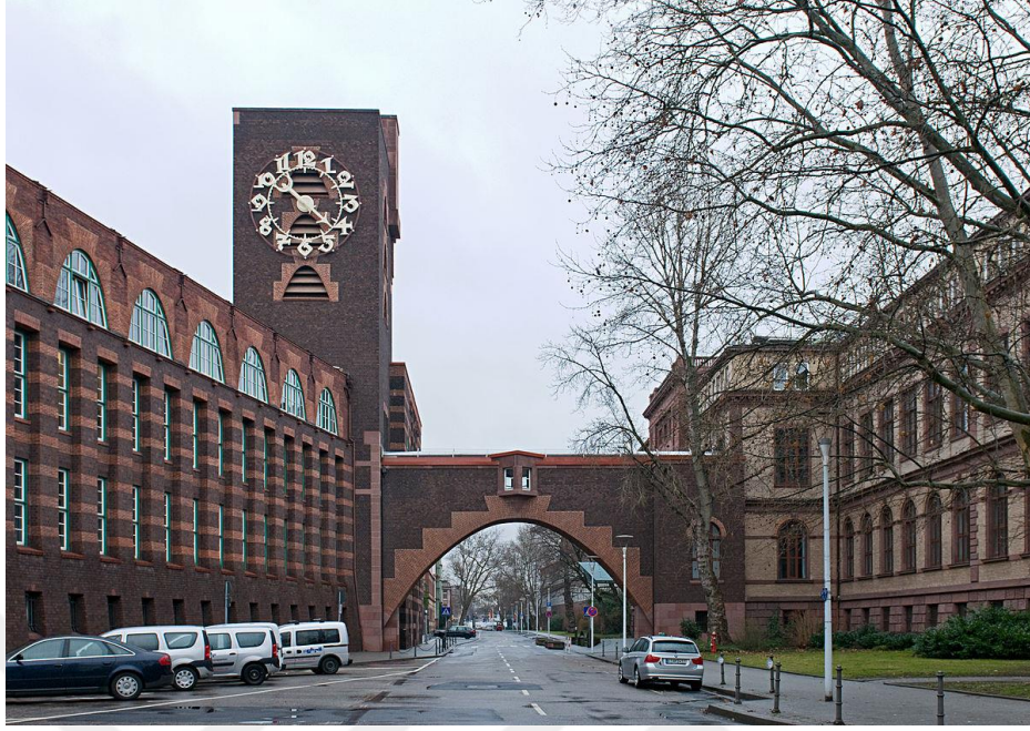
Şekil 1.5. Hoechst Yönetim Binası (URL-5).
