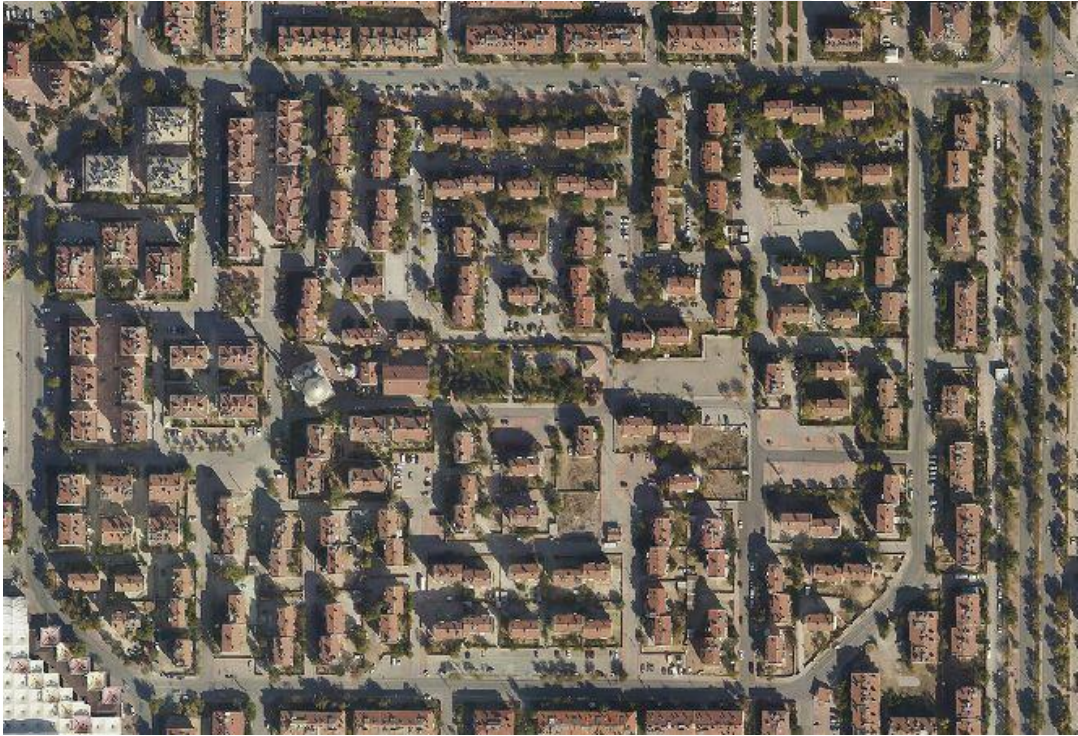
Resim 4.2. Binkonutlar adı verilen sosyal konutların bulunduğu komşuluk biriminin güncel durumu (Konya Büyükşehir Belediyesi Kent Bilgi Sistemi)
