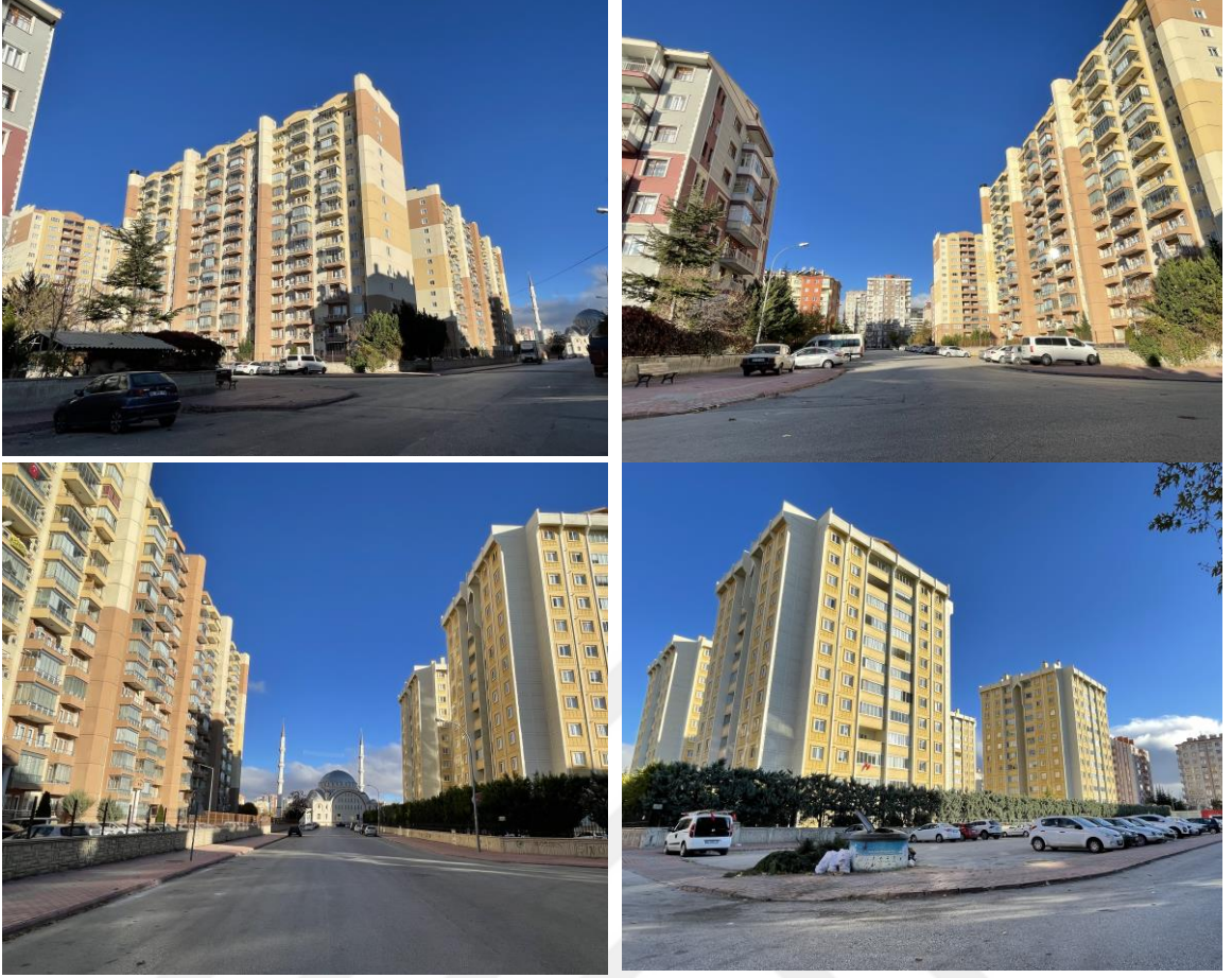
Resim 4.4. Bölgede tadilatlar aracılığıyla uygulanan güvenli/kapalı sitelerin oluşturduğu kentsel mekanlar. (Sami Kalfaoğlu kişisel fotoğraf arşivi)
