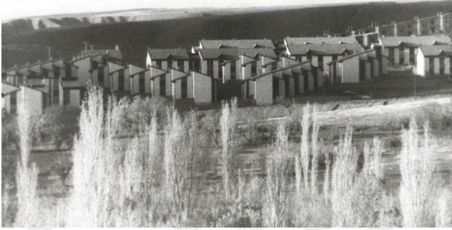
Resim 2.14. Çorum Binevler yapımı tamamlanan bloklar ( https://archives.saltresearch.org/ )
