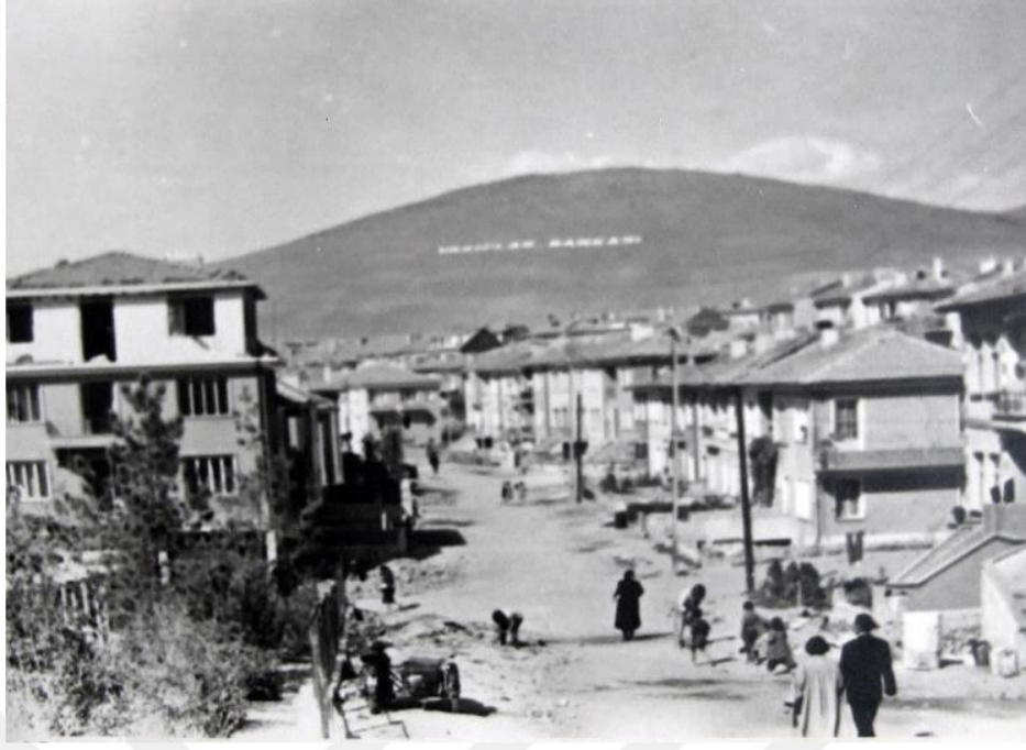
Resim 2.8. Yenimahalle’den bir görünüm (Şinasi Yüksel Arşivi’nden aktaran Okkalı,2019)
