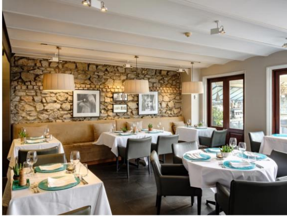
Görsel 35. Tapasuma Restoranda yapının özgün halinden korunarak kullanılan çelik volta döşeme ve taş duvar ( https://www.sumahan.com/ , 2022)
