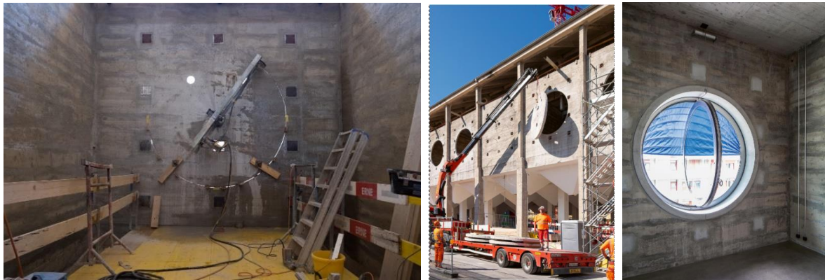
Görsel 53. Cepheye açılan boşluklar (Seitz, Conversion Silo Erlenmatt, Basel, 2020)
